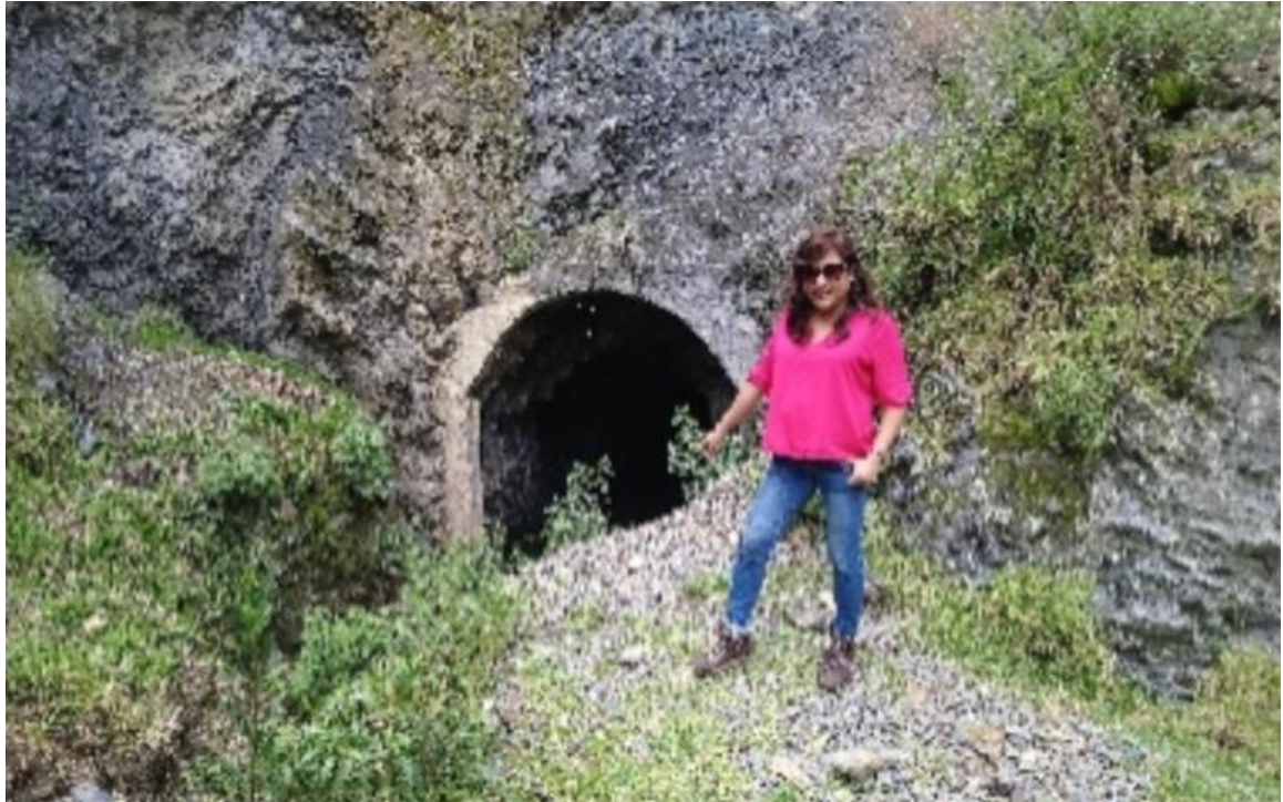
Figura 120: Infraestructura existente en la cuenca Mchique.
