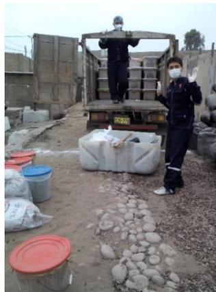
Figura 6: Contenedores con excretas deshidratadas mezcladas con material secante, para formación de pilas
