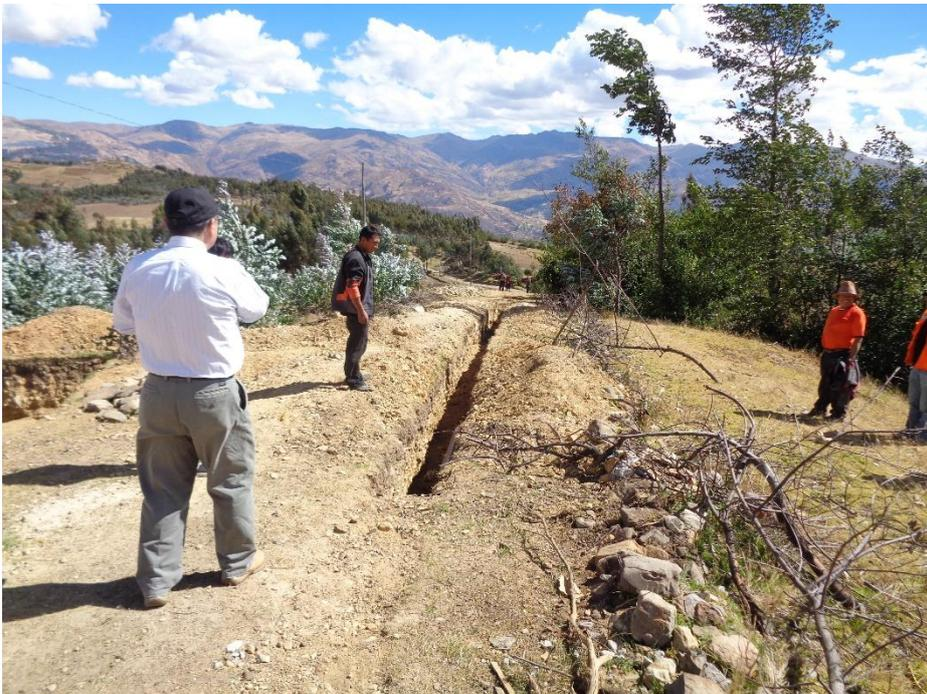
**Figura N° 36: Zanja de la ejecución de la obra de agua potable y la proyección del trazo del sifón**
