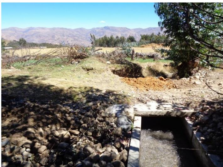
**Figura N° 6: Canal Ishinca en la progresiva 6+350. Zona de captación del Sifón**
