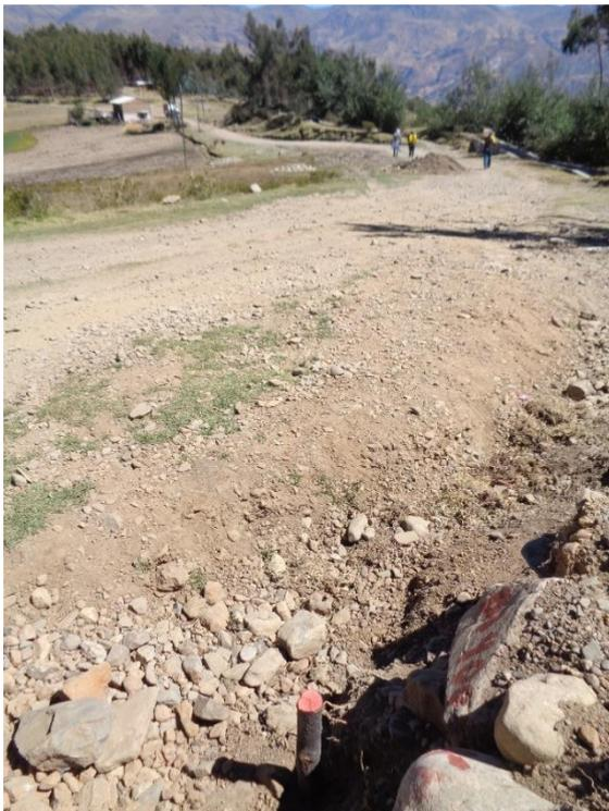
**Figura N° 33: La línea de conducción del Sifón se desplazara por la margen izquierda de la trocha de acceso Pashpa -Huantzapampa**
