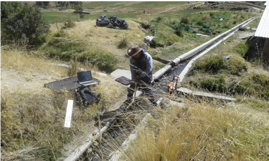
**Figura 16: Trabajos de aforamiento en canal secundario**
