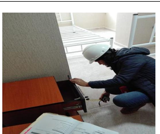
Instalación de las mesas de noche
