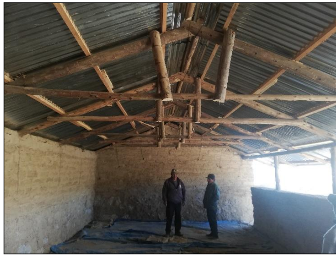
Figura 23: Vista interior de armado de techo
