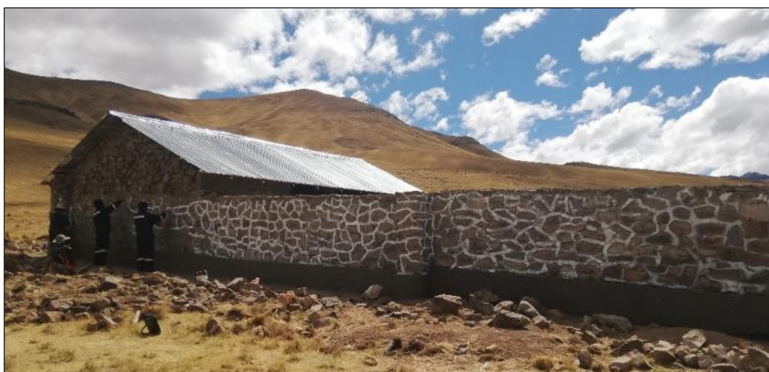
Figura 36: Sellado de juntas con mortero de cemento en los muros exteriores
