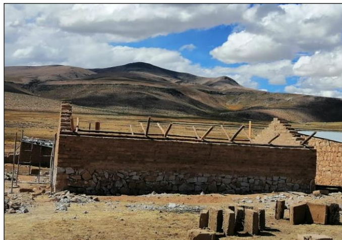
Figura 22: Vista exterior de armado de techo
