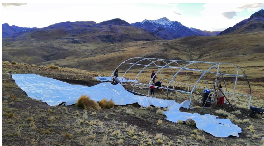
Figura 38: Armado de los tubos metálicos de la carpa
