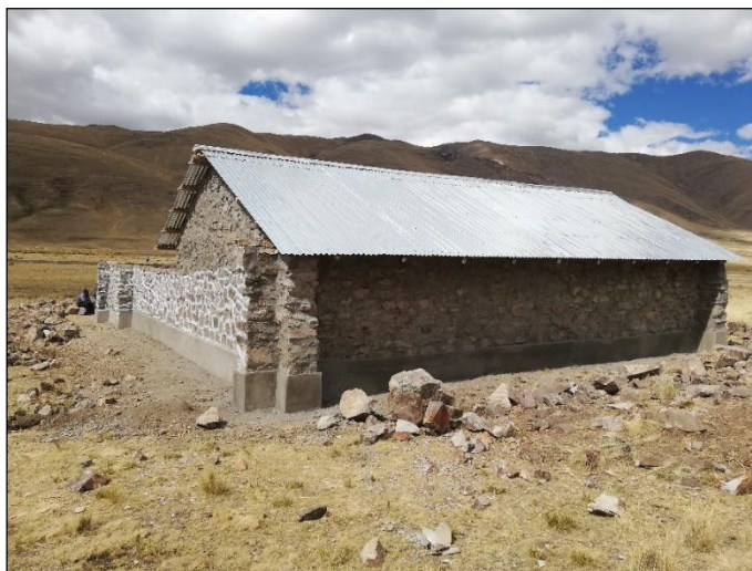
Figura 35: Vista exterior de techo
