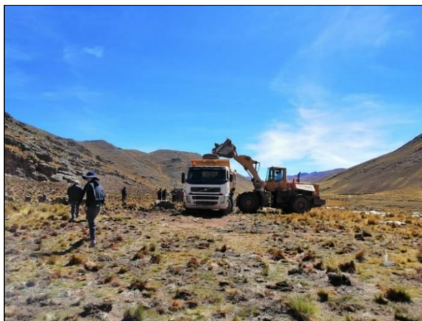
Figura 32: Traslado de piedra al punto de construcción
