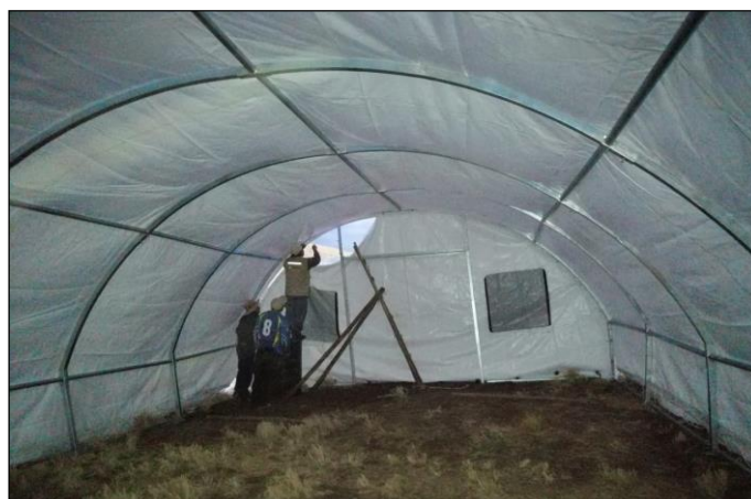
Figura 39: Tendido de lona
