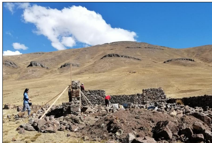
Figura 34: Levantamiento de muros de piedra
