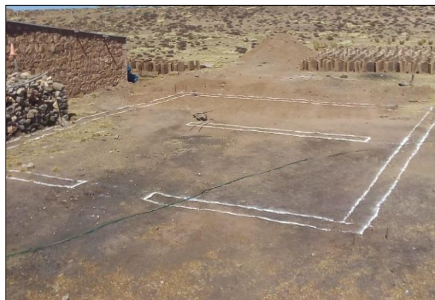
Figura 18: Trazo de cimentación
