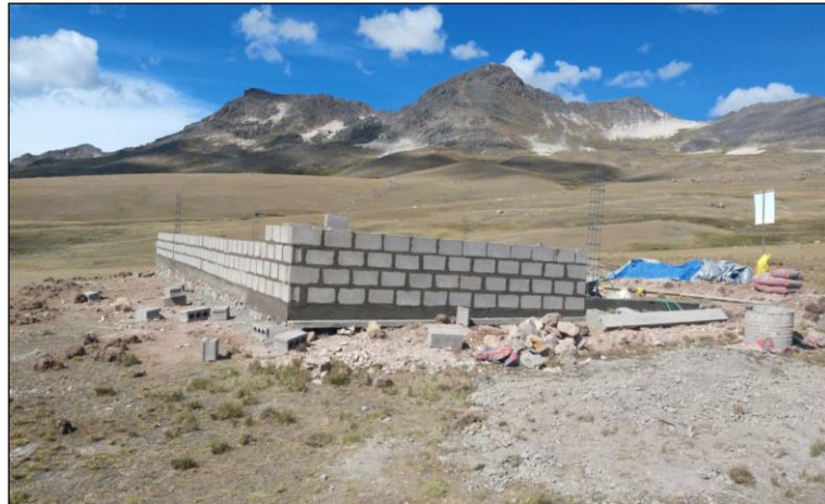
Figura 26: Muro de bloquetas
