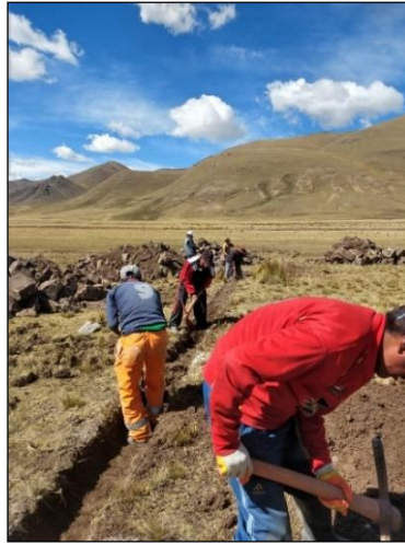
Figura 33: Trabajos de excavación para cimientos y sobrecimientos
