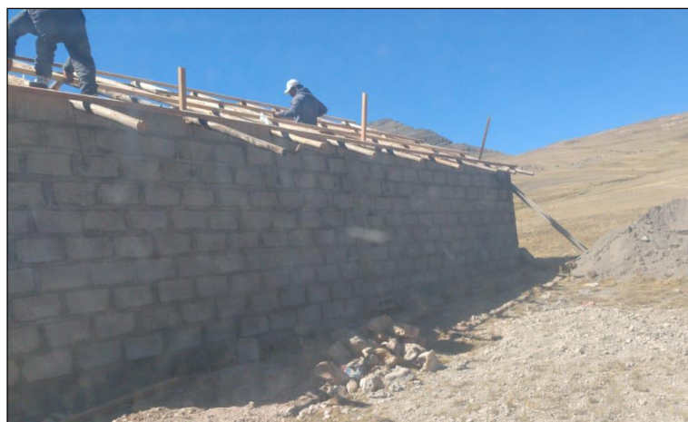
Figura 27: Armado de techo
