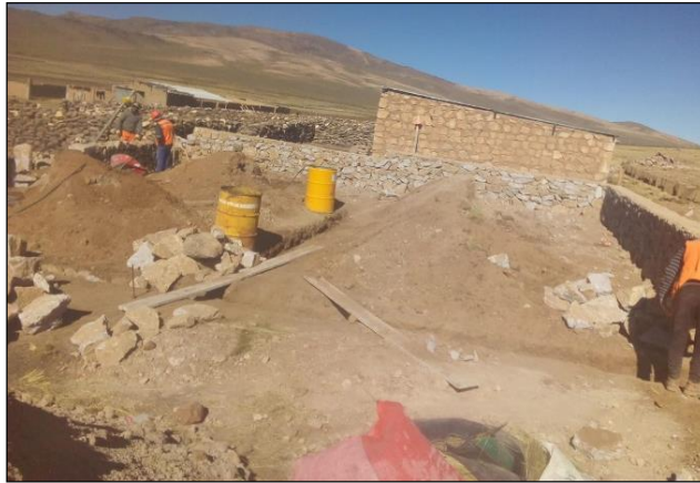
Figura 19: Elaboración de muro de piedra
