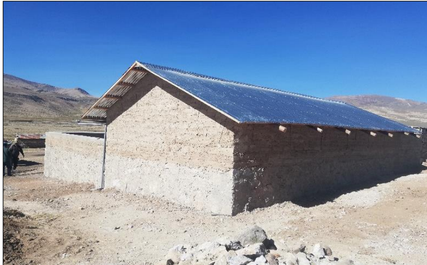
Figura 25: Vista posterior de cobertizo terminado
