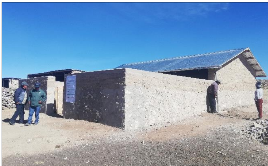
Figura 24: Vista frontal de cobertizo terminado
