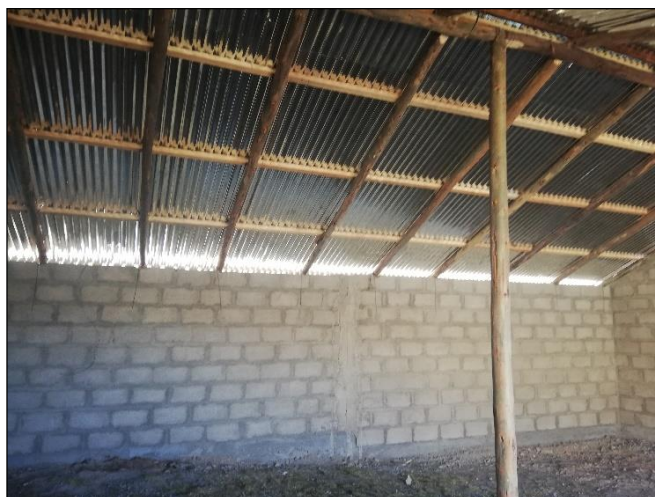
Figura 28: Vista interna de armado de techo del cobertizo Macusani
