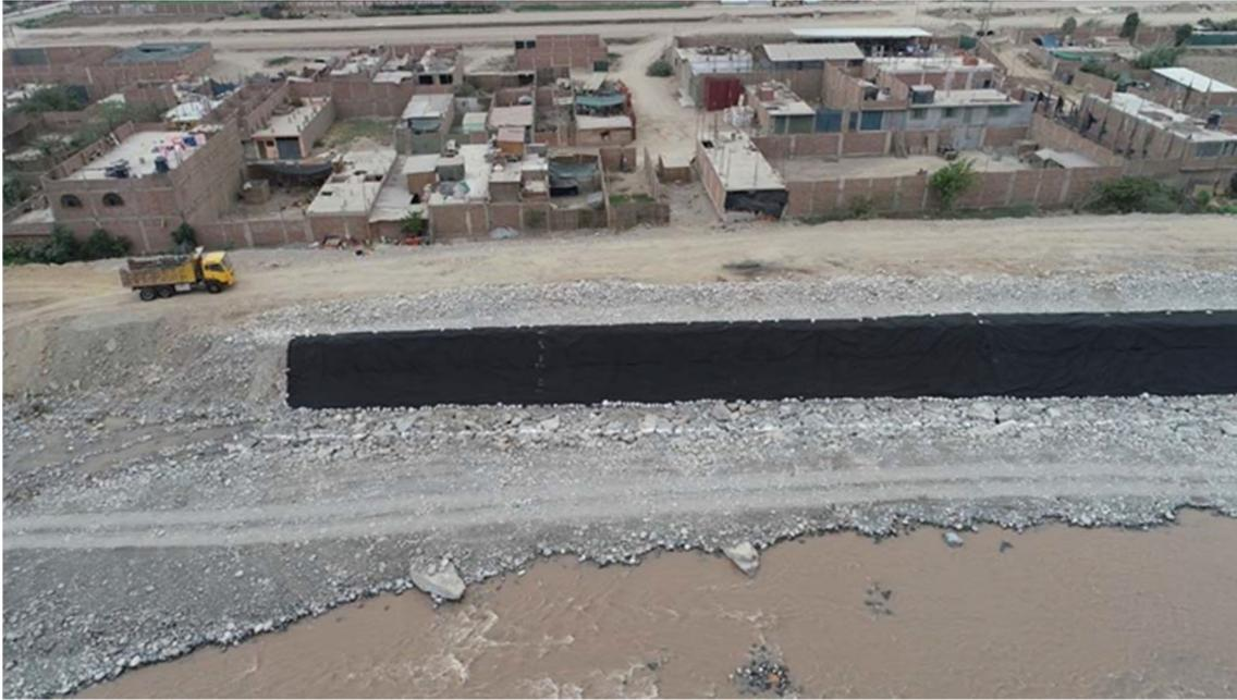
Figura 17: Geotextil sobre talud del dique
