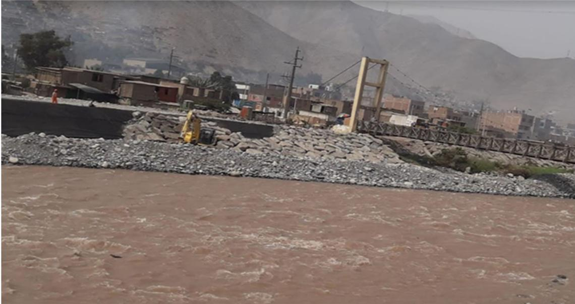
Figura 21: Trabajos de acomodo de roca para protección del dique
