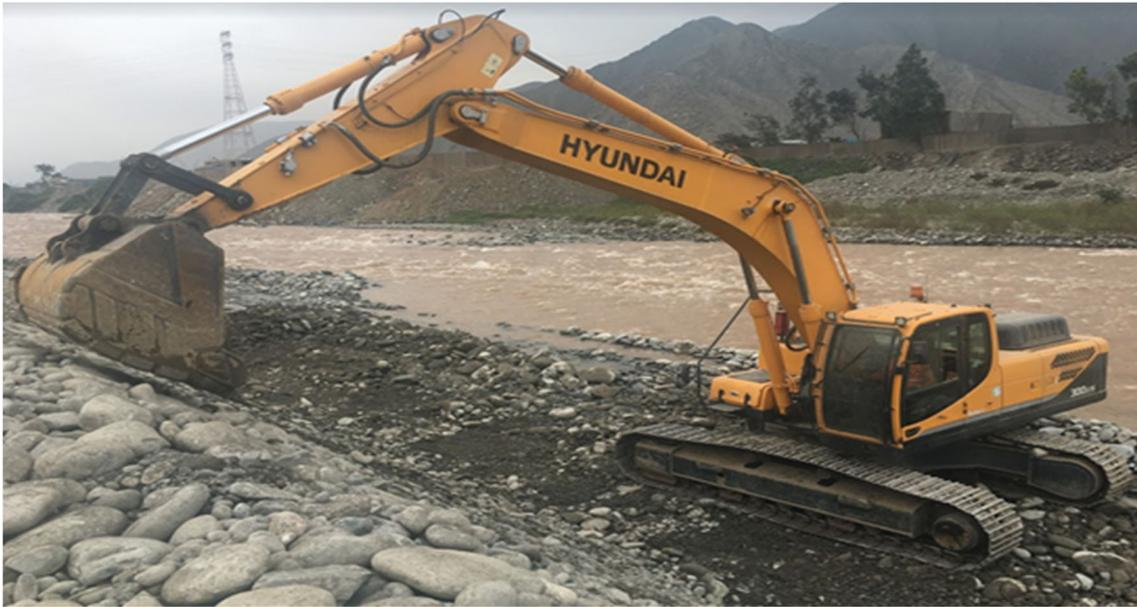
Figura 16: Perfilado de taludes de acuerdo a la geometría del expediente técnico.
