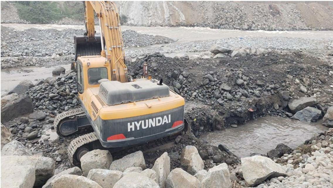
Figura 18: Trabajos de excavación de uña para fundación del enrocado
