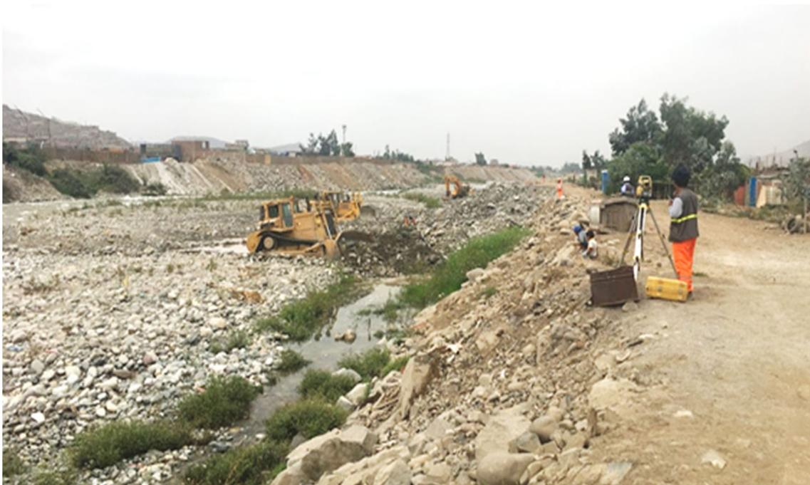
Figura 14: Trabajos de conformación de terraplén.
