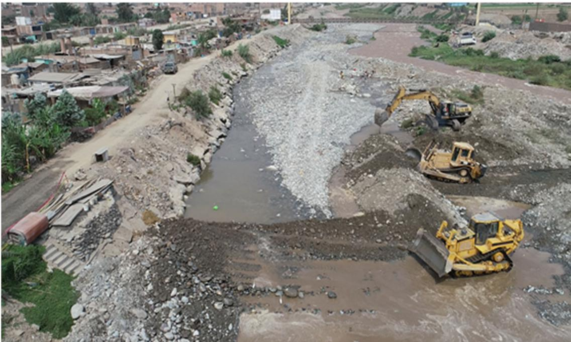
Figura 15: Perfilado de taludes con excavadoras.
