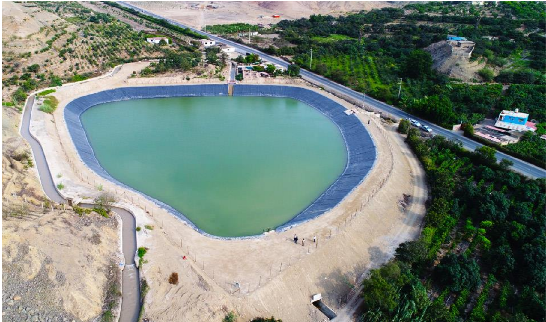
Anexo 3: Foto aérea de la obra terminada
