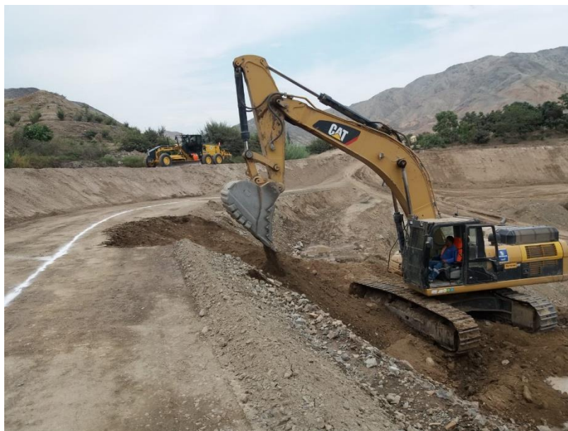
Figura 13: Conformación de banqueta
