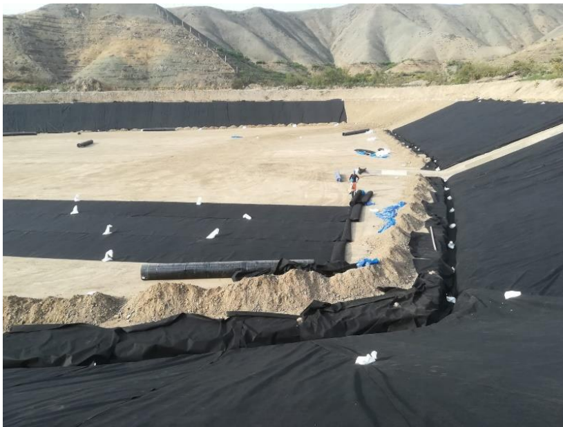
Figura 21: Instalación del geotextil.
