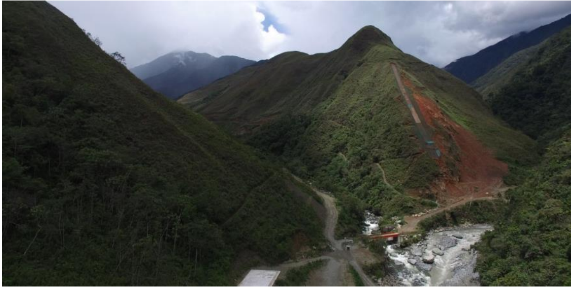
Figura 33: Vista aérea tubería forzada y futura casa de máquinas CH Ayanunga, 2019
