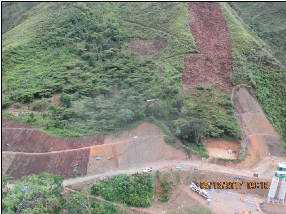
Figura 32: Tramo 0+300 – 0+505, instalación parcial de biomanta, PK 0+300 – 0+370.
