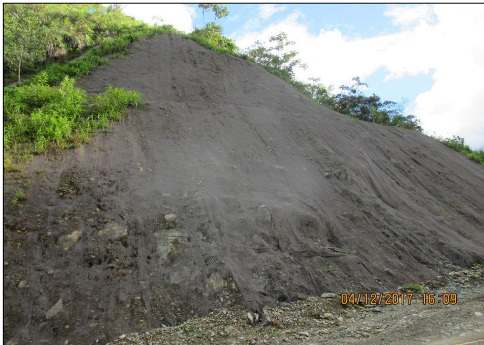
Figura 30: Tramo PK 0+150 – 0+220, se instaló biomanta como medida de control de erosión.
