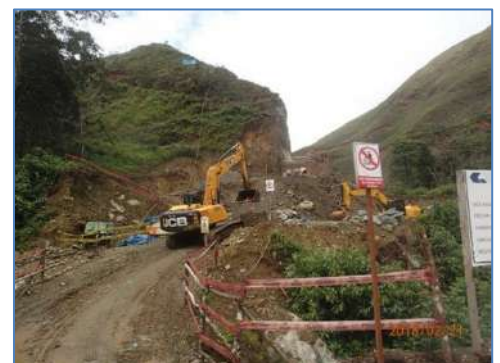
Excavación de la zona de conducción
