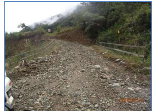
Camino de acceso a Cámara de Carga (tramo 1)
