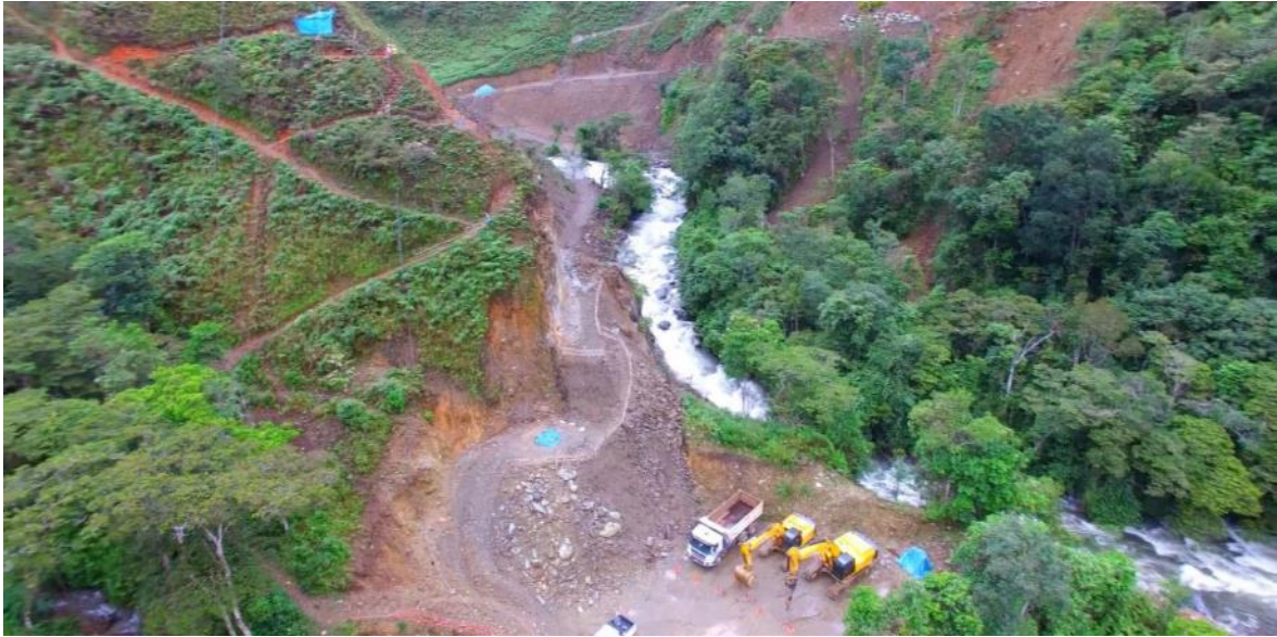
Figura 35: Vista aérea conexión de tramo 1 y tramo 2, pre corte de camino de servidumbre, 2018
