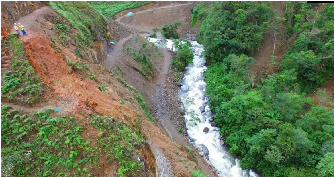
Figura 36: Vista de habilitación de carretera provisional por río en época de estiaje para acceso a tramo 2
