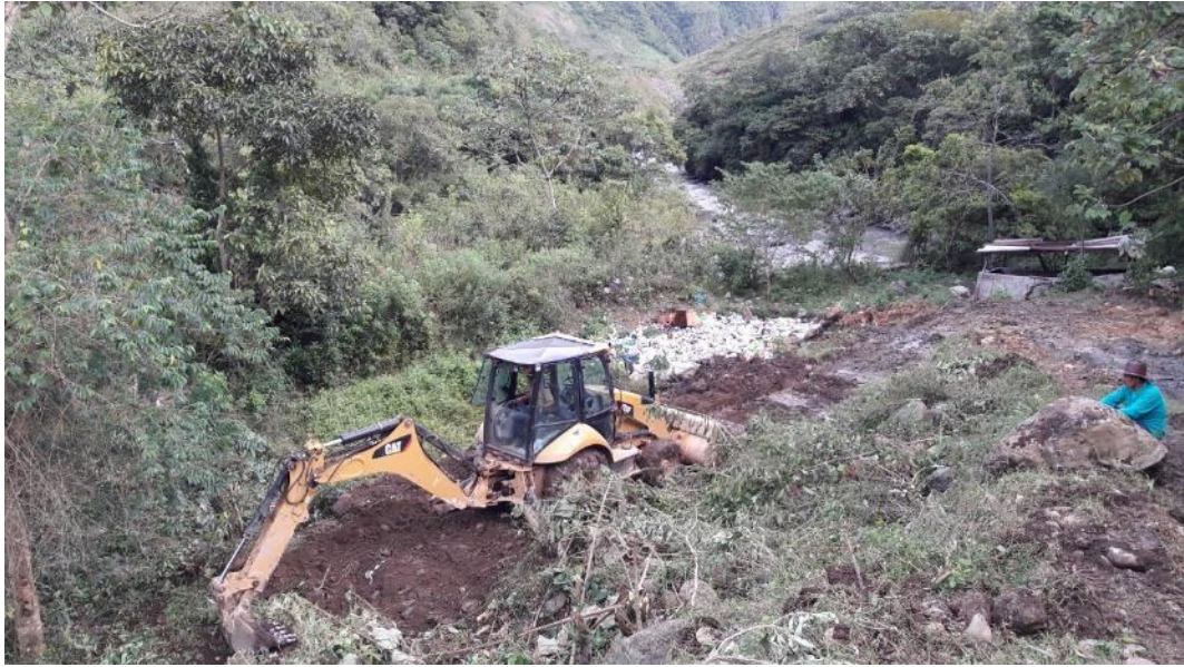
Figura 23: Habilitación de terreno CP Caunarapa para relleno sanitario, 2018
