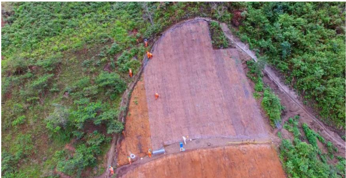
Figura 34: Vista de trabajos en trabajos de talud, instalación de malla de doble torsión y zanjas de coronación con concreto lanzado, 2018
