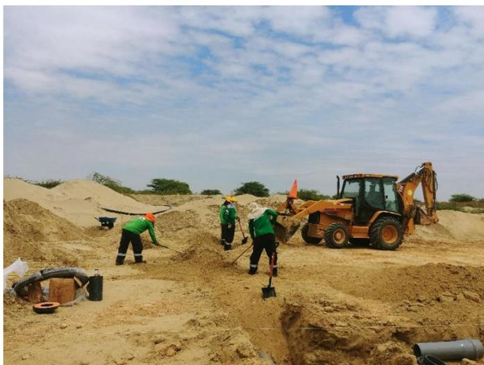
**Figura 25: Tapado de la tubería de interconexión**
