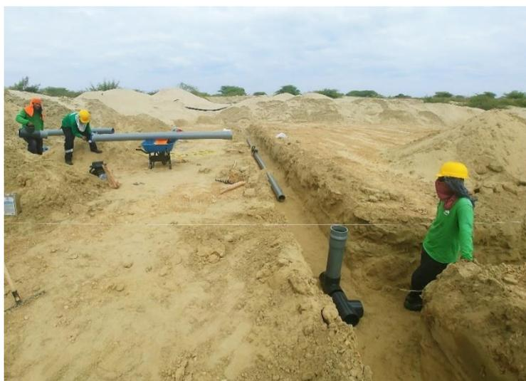
**Figura 23: Instalación de tubería de interconexión.**
