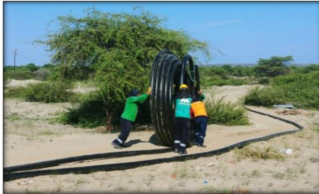
**Figura 8: Instalación de manguera HDPE 110mm.**
