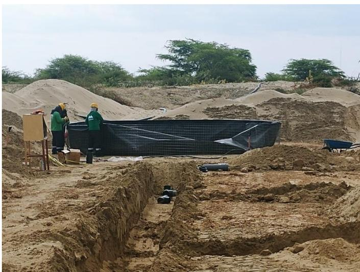
**Figura 26: Instalación del primer geotanque.**
