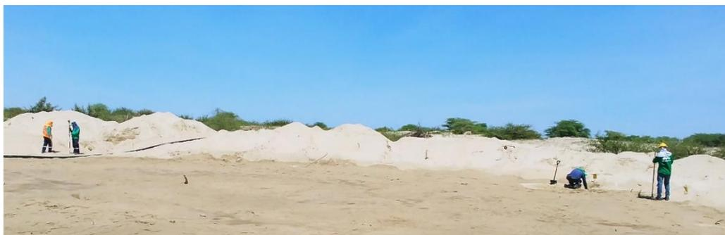
**Figura 22: Nivelación de área a instalar de reservorios móviles.**
