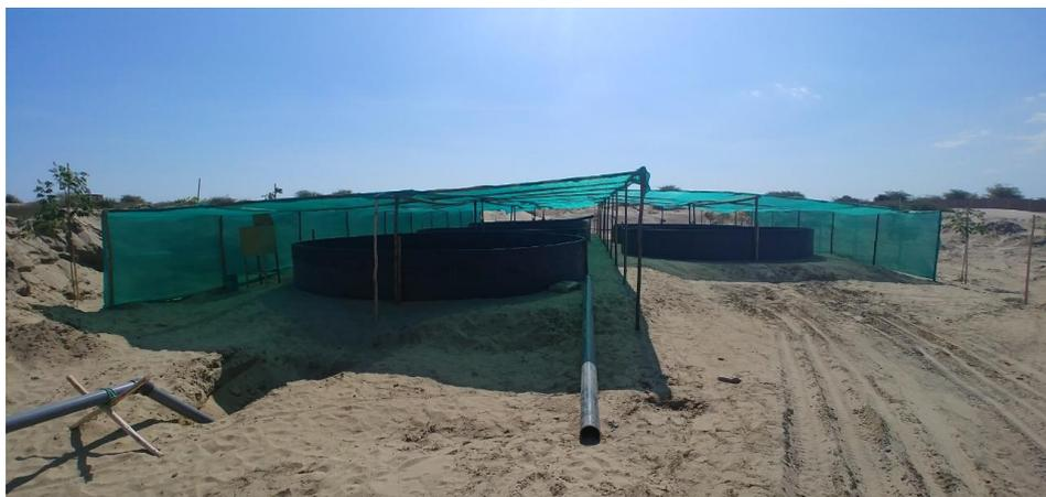
**Figura 28: Instalación del sistema de geotanques.**
