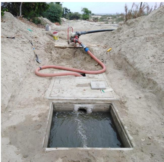
**Figura 29: Bombeo del agua del canal de oxidación.**
