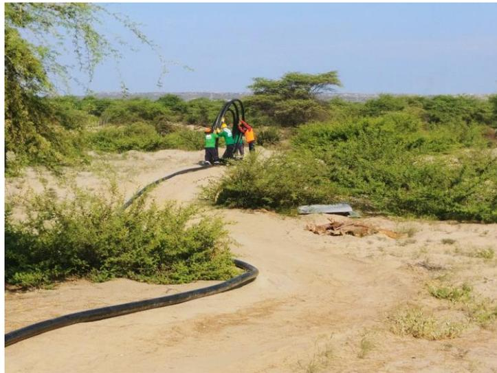
**Figura 21: Desenrollado de manguera HDPE**
