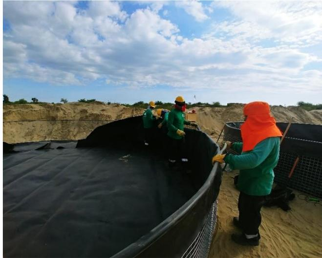
**Figura 27: Instalación del primer geotanque.**
