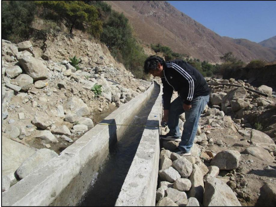
**Figura 21: Medición del canal de concreto:  $B=0.80$  x  $H=0.60$  m, Ancho= $0.17$ m**
