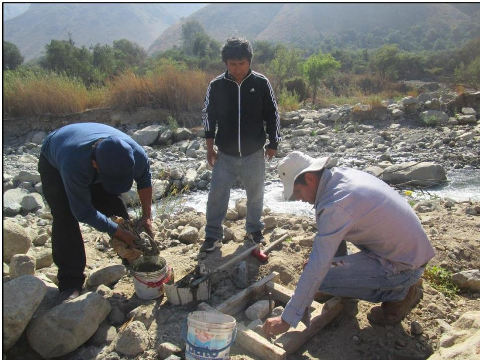
**Figura 22: Armado del encofrado para el hito de control topográfico**
