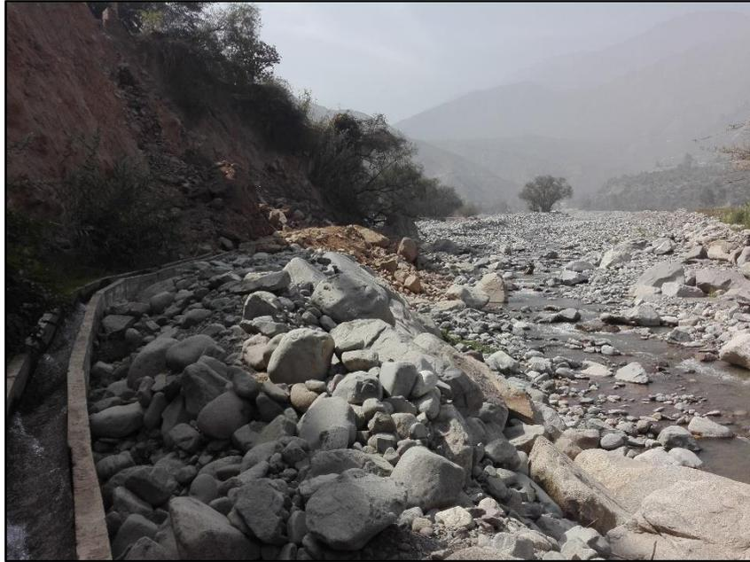
**Figura 13: Vista del río Santa Eulalia a la altura del primer sector crítico donde se colocar el enrocado para proteger el canal de concreto**
