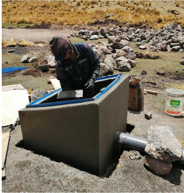
Figura 18: Estructura de toma, instalada aguas arriba del dique
