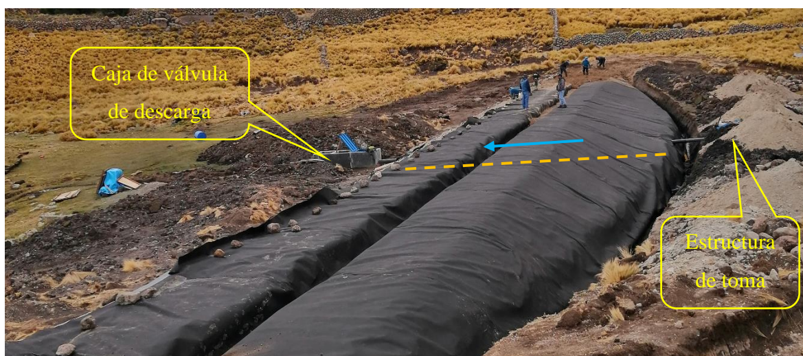
Figura 20: Tubería PVC-UF, C-10 DN 160mm instalada transversalmente al eje del dique
