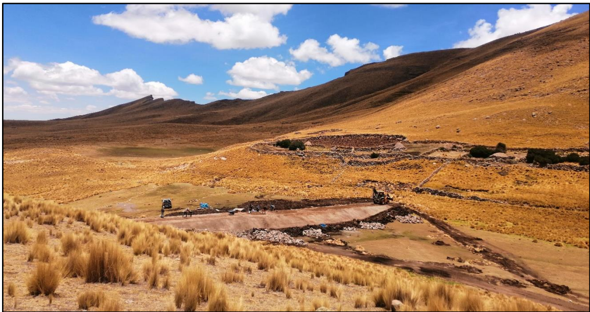
Figura 12: Conformación de terraplén, en cuerpo del dique. En un avance del 90%
