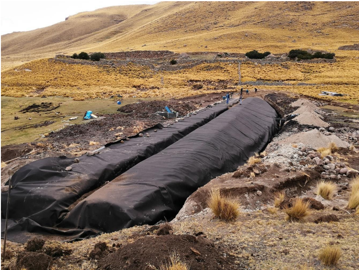
Figura 17: Colocado de geomembrana lisa HDPE con cobertura de geotextil en ambos lados, para su protección
