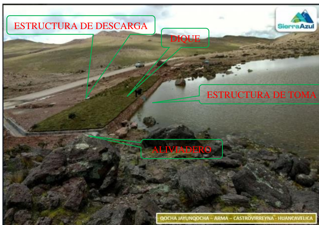
Figura 3: Construcción culminada del dique en la Qocha Jayunqocha, en el distrito de Arma, provincia de Castrovirreyna, región Huancavelica
