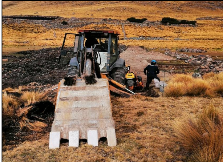
Figura 6: Retroexcavadora cargadora y equipos menores en obra
