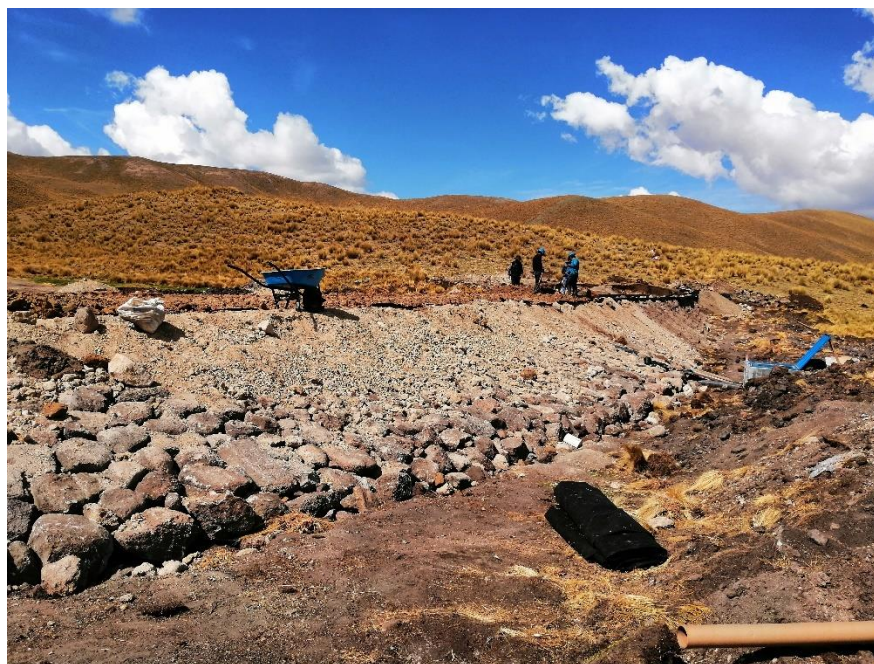
Figura 13: Conformación de espaldón con piedra
