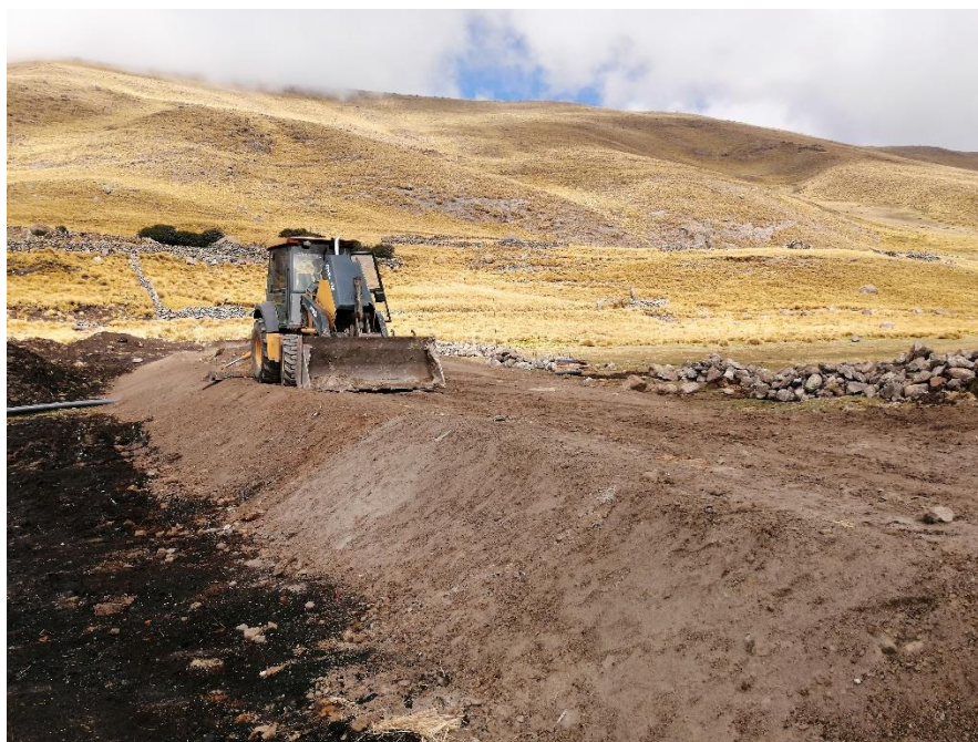
Figura 11 :Piedras colocadas en espaldón de dique
