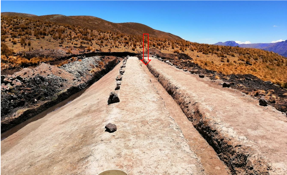
Figura 15: Excavación de zanja en la corona del dique
