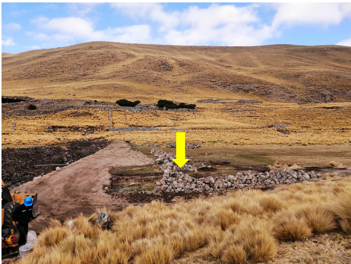
Figura 10: Piedras acopiadas para el espaldón de dique
