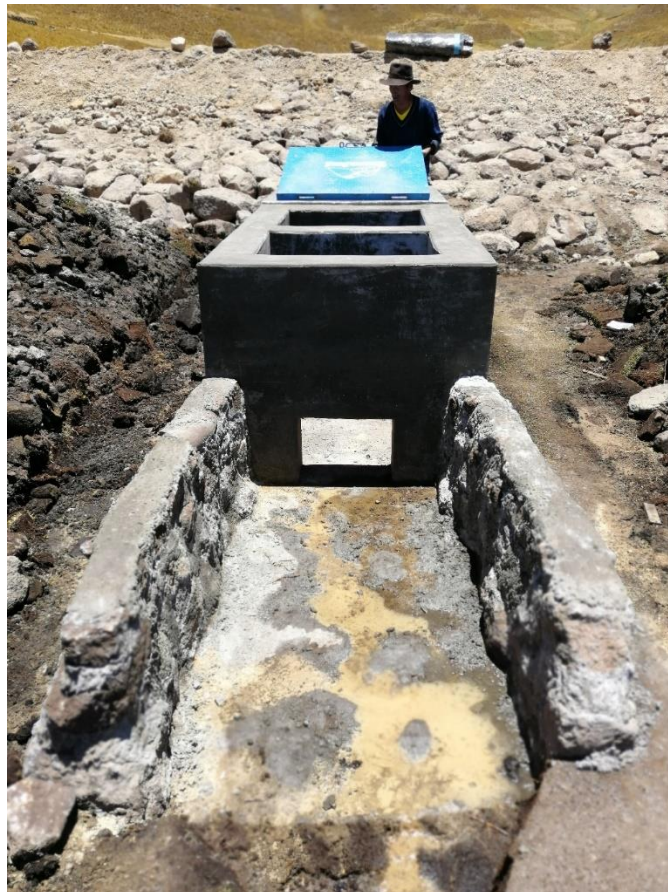
Figura 19: Estructura de descarga, instalada aguas abajo del dique
