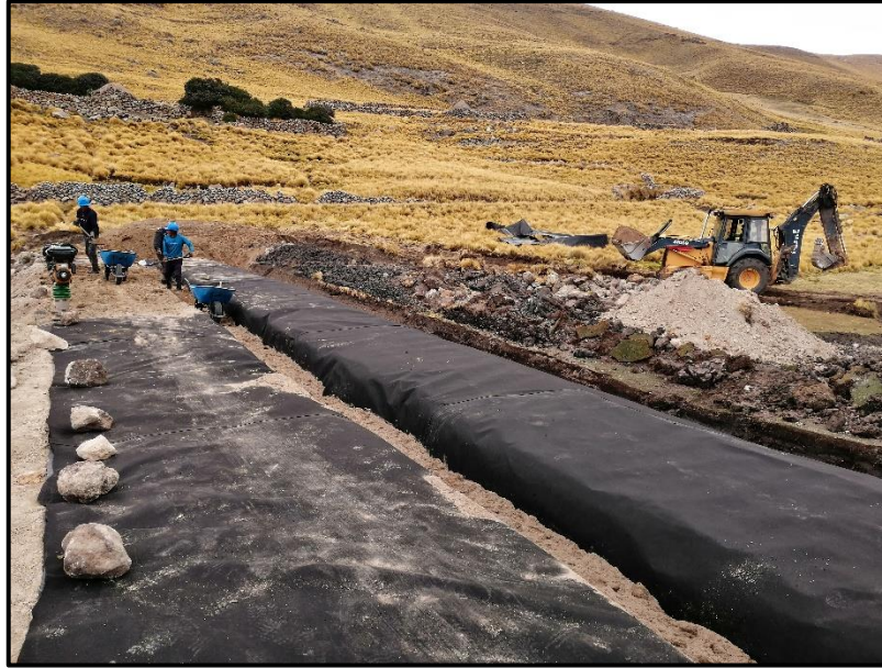
Figura 16: Llenado de material propio en la zanja de la corona del dique
