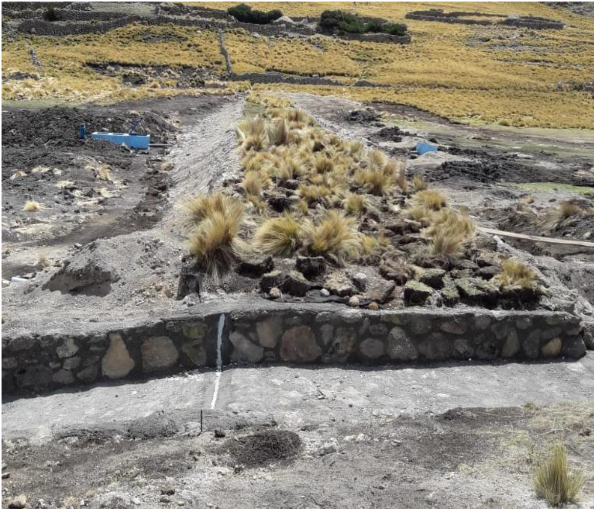
Figura 23: Aliviadero de demasía culminado su construcción
