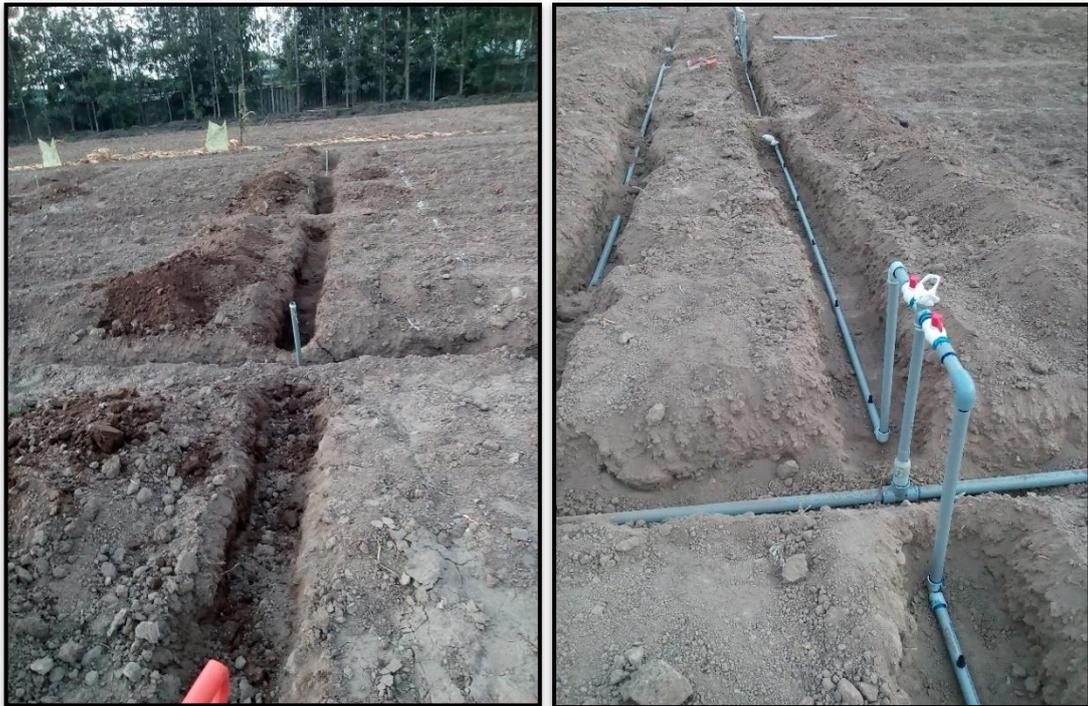
**Figura 18: Instalación de arcos de riego, porta-laterales y laterales**
