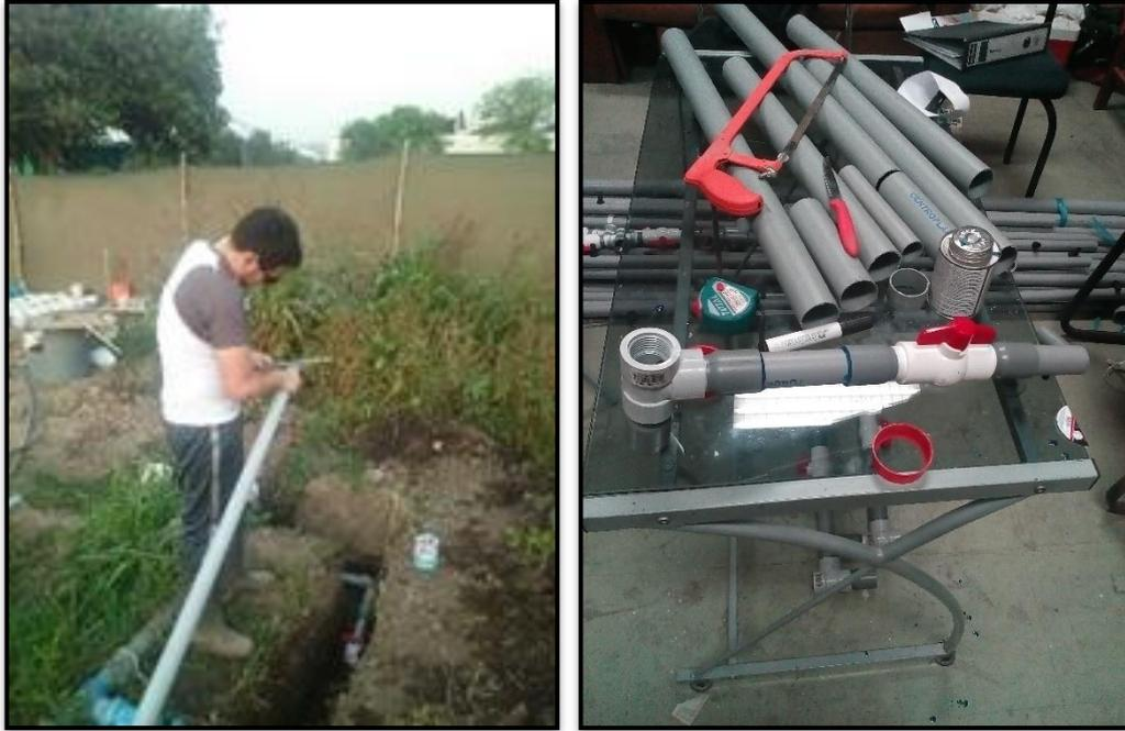
**Figura 17: Instalación de tubería principal y elaboración de arcos de riego**
