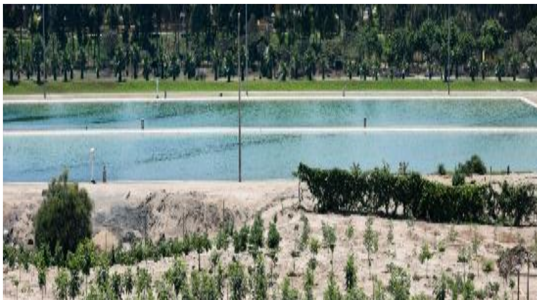
Figura 12 Planta de tratamiento de aguas residuales (PTAR) Parque Zonal Huáscar VES.
