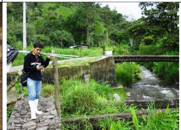
Foto 18. Zona baja, cerca del puente. Sobre estructura antideslizamientos.
