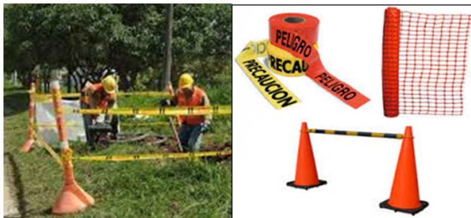
Figura13. Señalización del Área de Trabajo
