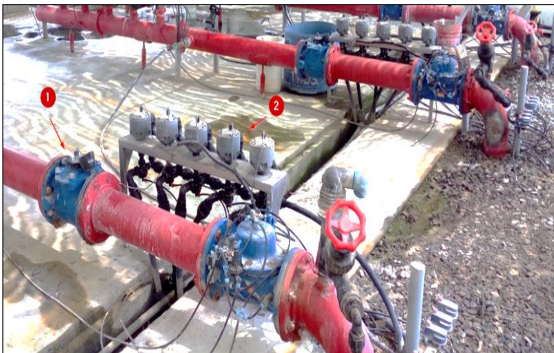
Anexo 28: Caudalímetro con pulsos de 1 m 3 para control de riego (1) y fertímetros de 1.0 l/s para dosificación de fertilizantes (2)
