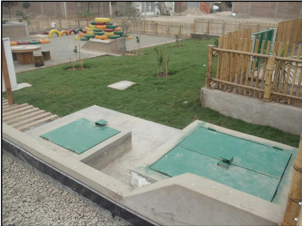
**Fotografía 10: Humedal artificial saturado - Primeras pruebas**
