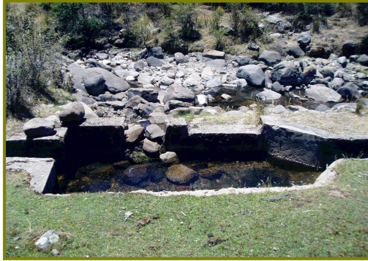
Figura 32: Desarenador existente.
