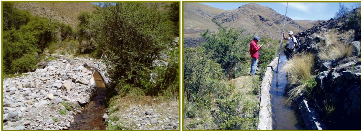
Figura 33: Canal trapezoidal existente
