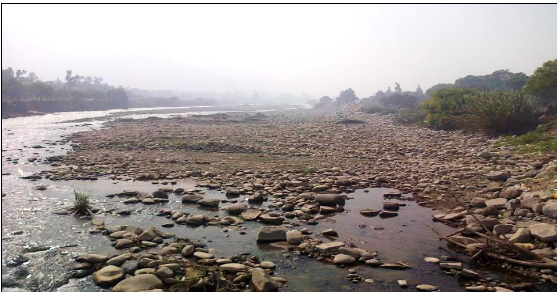
Figura 22: Vista aguas arriba del Puente Morón
