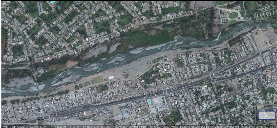
Figura 53: Morfología del cauce del Rímac - Vista aguas arriba del Puente Morón.
