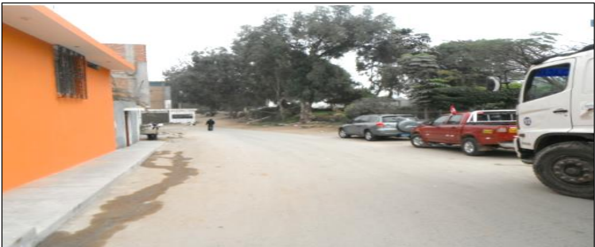
Figura 28: Vía de acceso aguas debajo de la entrada al P. Morón
