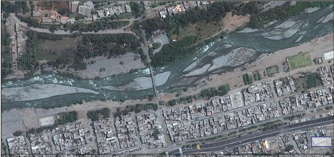
Figura 51: Morfología del río Rímac en el tramo del Puente Morón.
