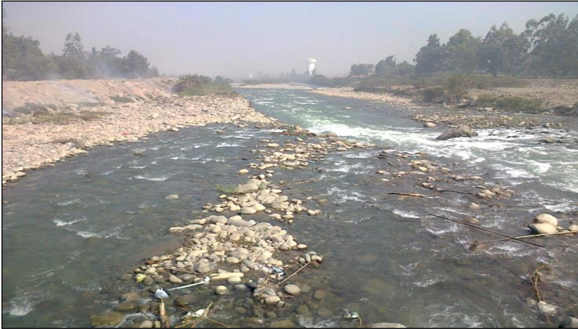
Figura 23: Vista aguas abajo del Puente Morón
