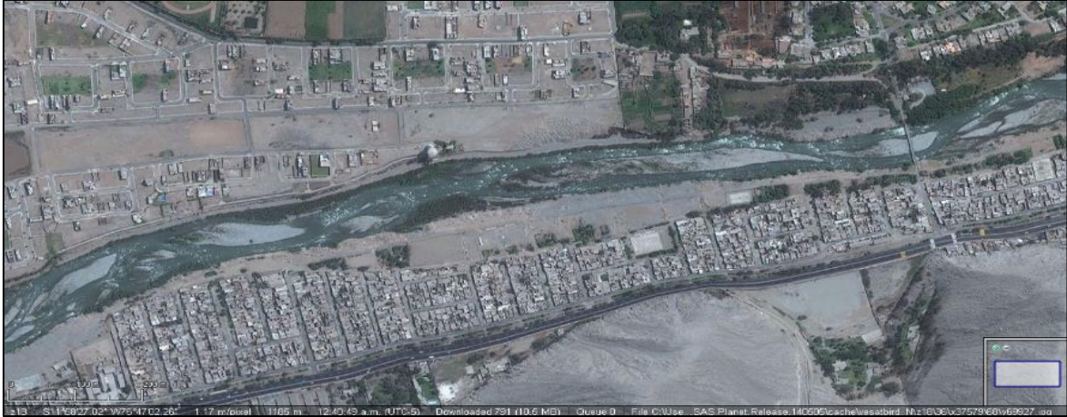
Figura 55: Morfología del cauce del Rímac - Vista aguas abajo del Puente Morón.
