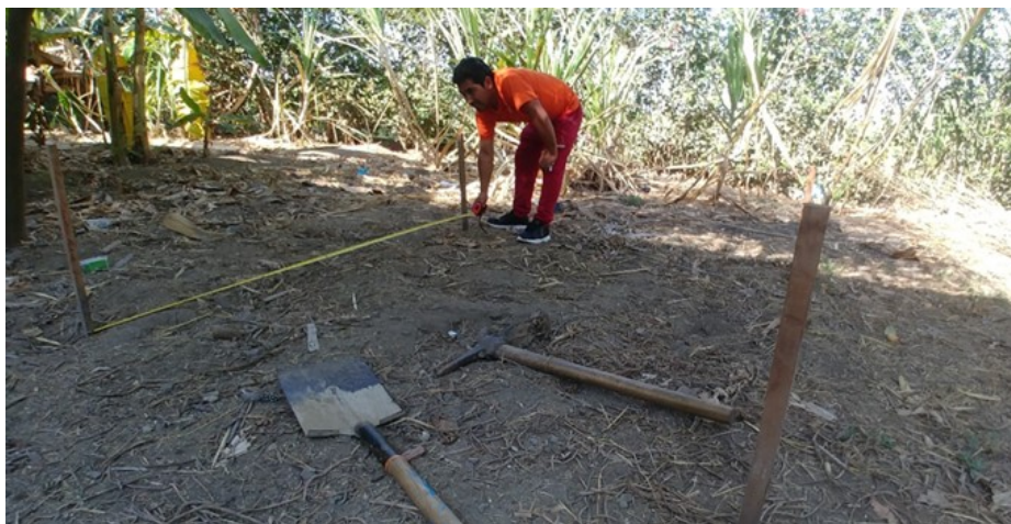
Figura 17: Vista del estacado de las pozas de lavado
