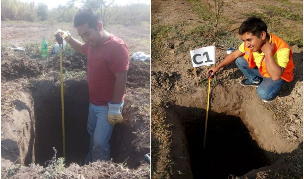
Figura 9: Vistas de la excavación de calicatas
