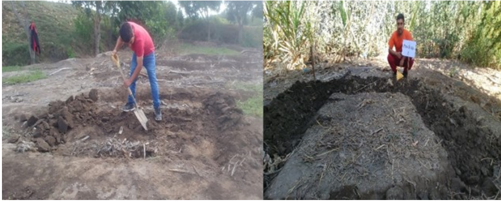
Figura 18: Vistas de la instalación de las pozas de lavado
