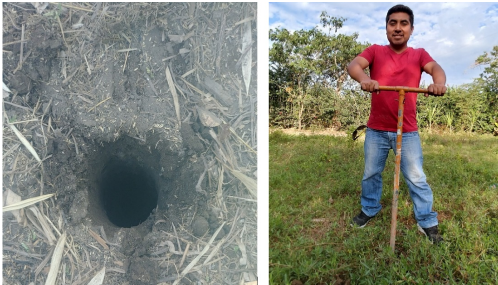
Figura 12: Vistas de la instalación de pozos de observación
