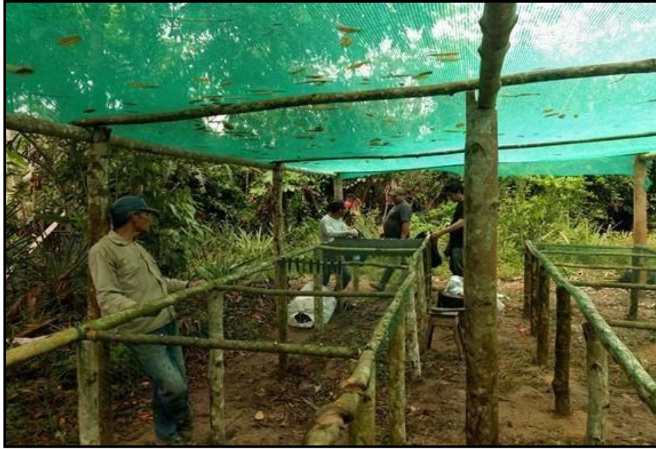
Figura 11. Instalación de soporte para tubetes en Contamana (Loreto).
