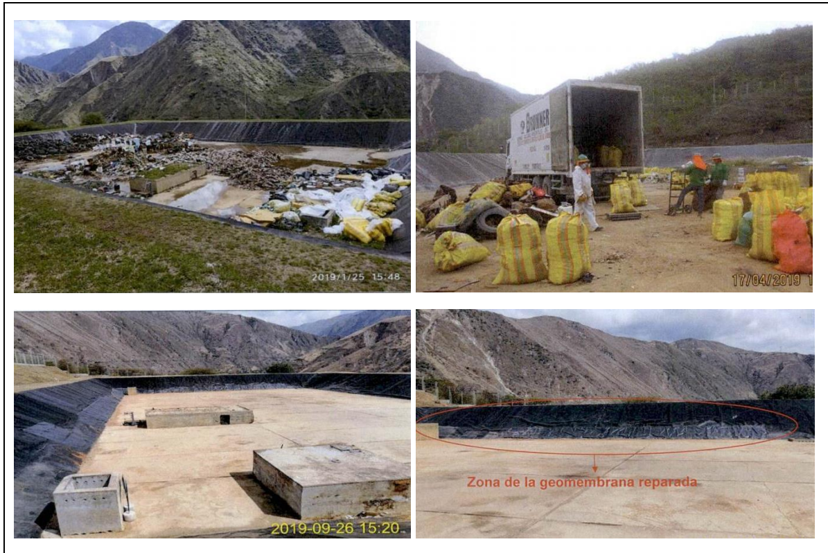
Figura 30. Trabajos de acondicionamiento del relleno Villa Azul
