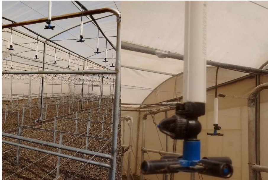
Figura 12. Sistema de riego con nebulizadores tipo “foggers”
