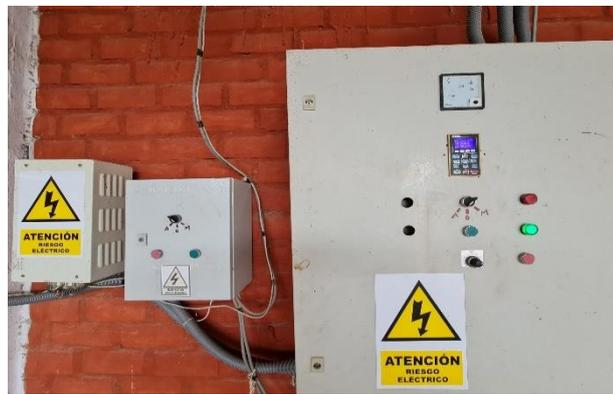
**Figura 28.** Controlador de riego
