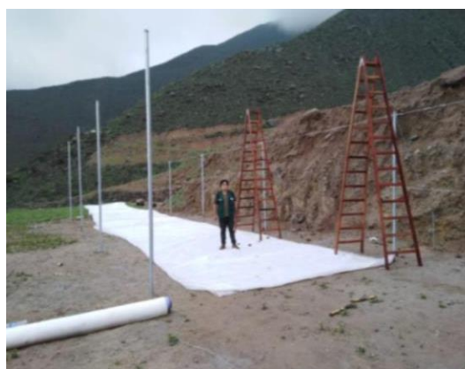
Figura 15. Instalación de estructura.
