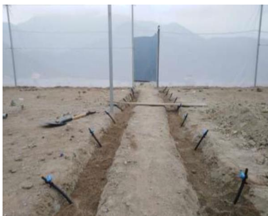
Figura 18. Enterrado de tubo con mechas
