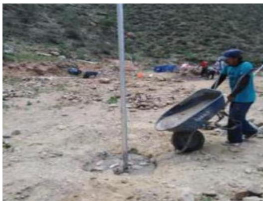
Figura 16. Cimentación de estructura.
