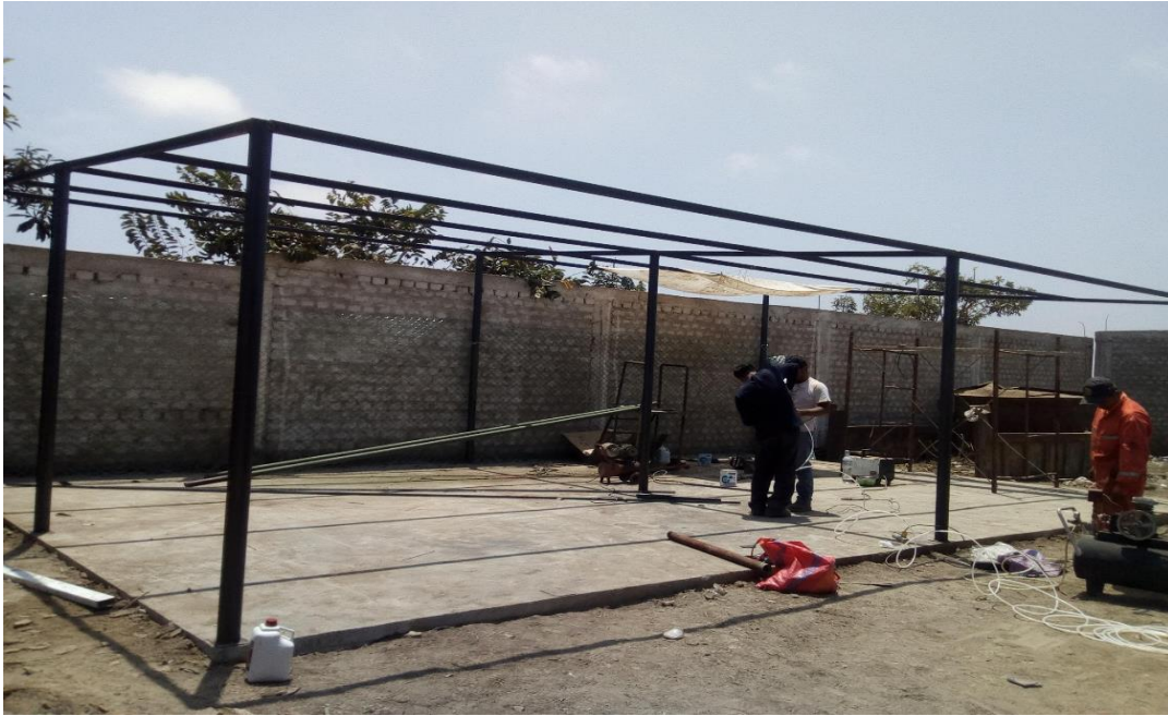
Figura 9: Centro de acopio del programa “Campo Limpio” en proceso de construcción, en el Estadio deportivo municipal del distrito de Chíncha Baja, 2018
