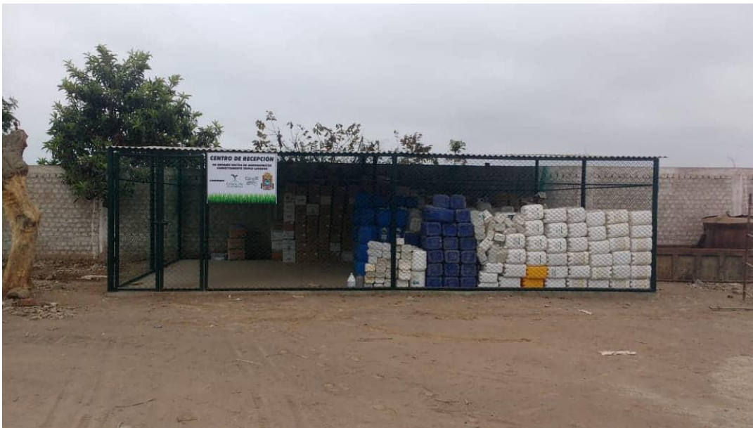
Figura 10: Centro de acopio del programa “Campo Limpio” construido y en operación en el distrito de Chíncha Baja, 2018
