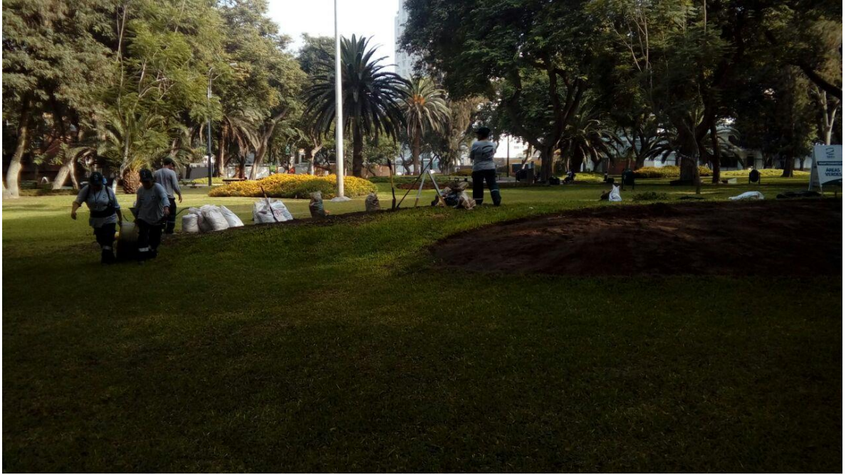
Fotografía 3: Preparación del terreno para cambio de macizos
