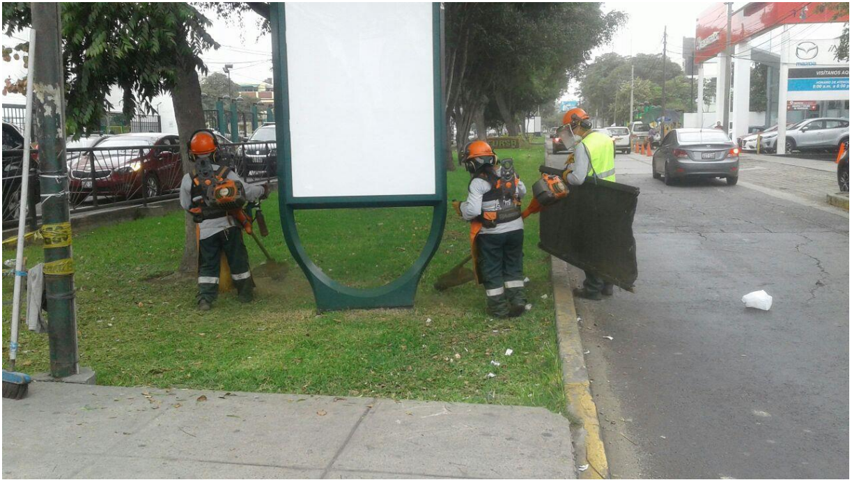
Fotografía 9: Corte de césped en bermas centrales
