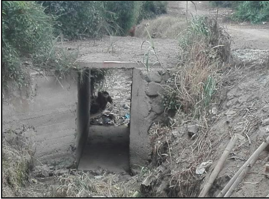
Figura 10: Vista de puente vehicular existente, progresiva km. 8+162.95
