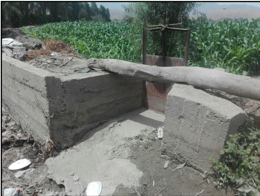
Figura 7: Vista de toma lateral existente a la altura de la progresiva km. 8+830.00
