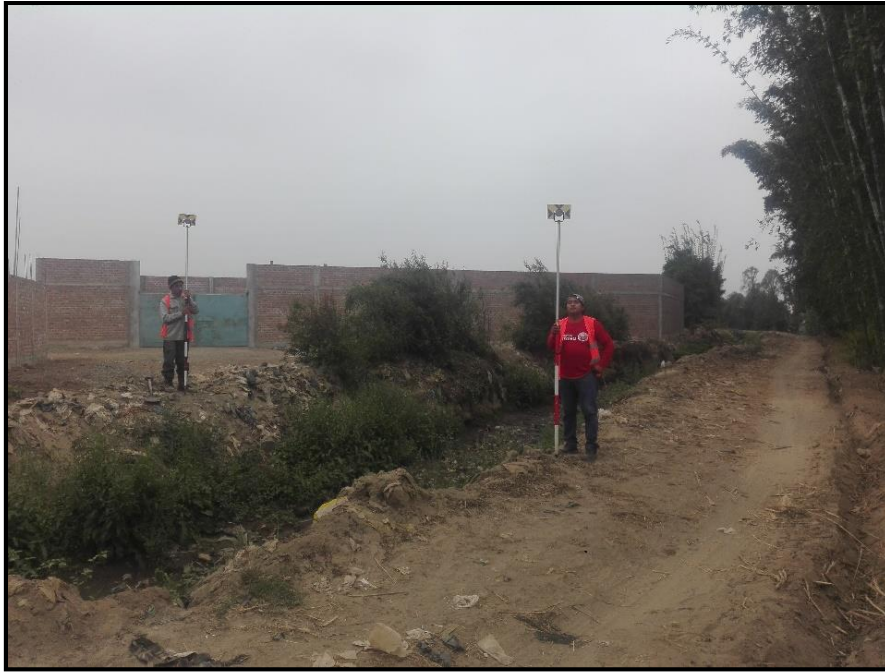
Figura 4: Vista del canal Palpa Bajo en la progresiva km. 8+880
