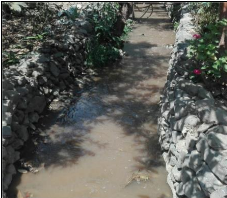
Figura 3: Vista del canal Palpa Bajo en la progresiva km. 7+260
