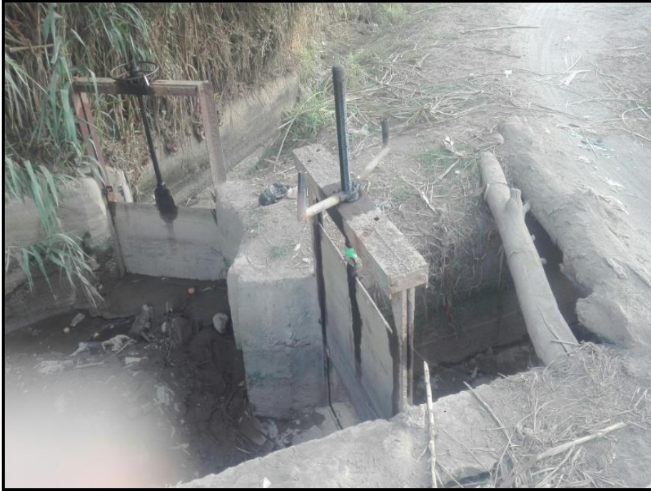
Figura 6: Vista de toma lateral existe a la altura de la progresiva km. 7+450.00
