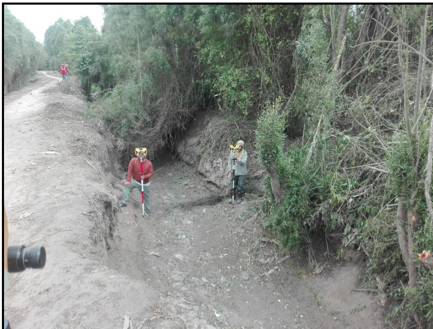
Figura 5: Vista del canal Palpa Bajo en la progresiva km. 10+406.57
