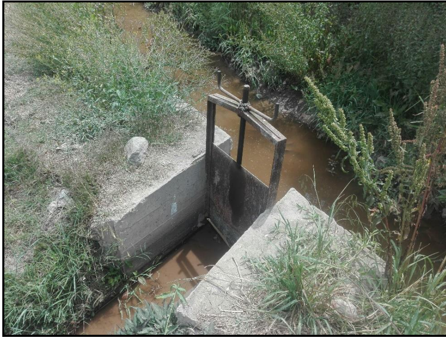
Figura 8: Vista de toma lateral existente, progresiva km. 10+378.70
