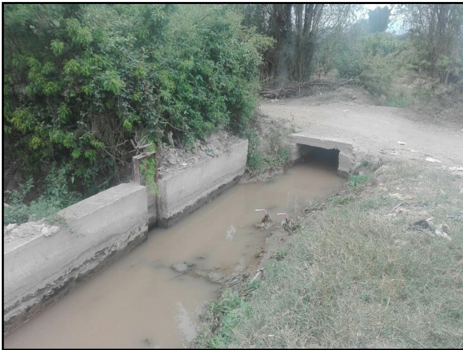
Figura 11: Vista de puente vehicular existente, progresiva km. 9+629.29
