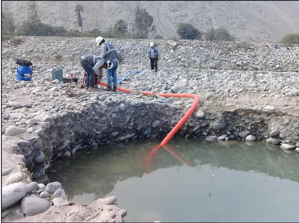
**Figura 32: Instalación del equipo de bombeo en la calicata 2**
