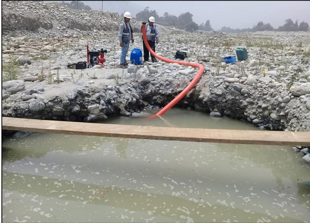
**Figura 34: Instalación del equipo de bombeo en la calicata 3**
