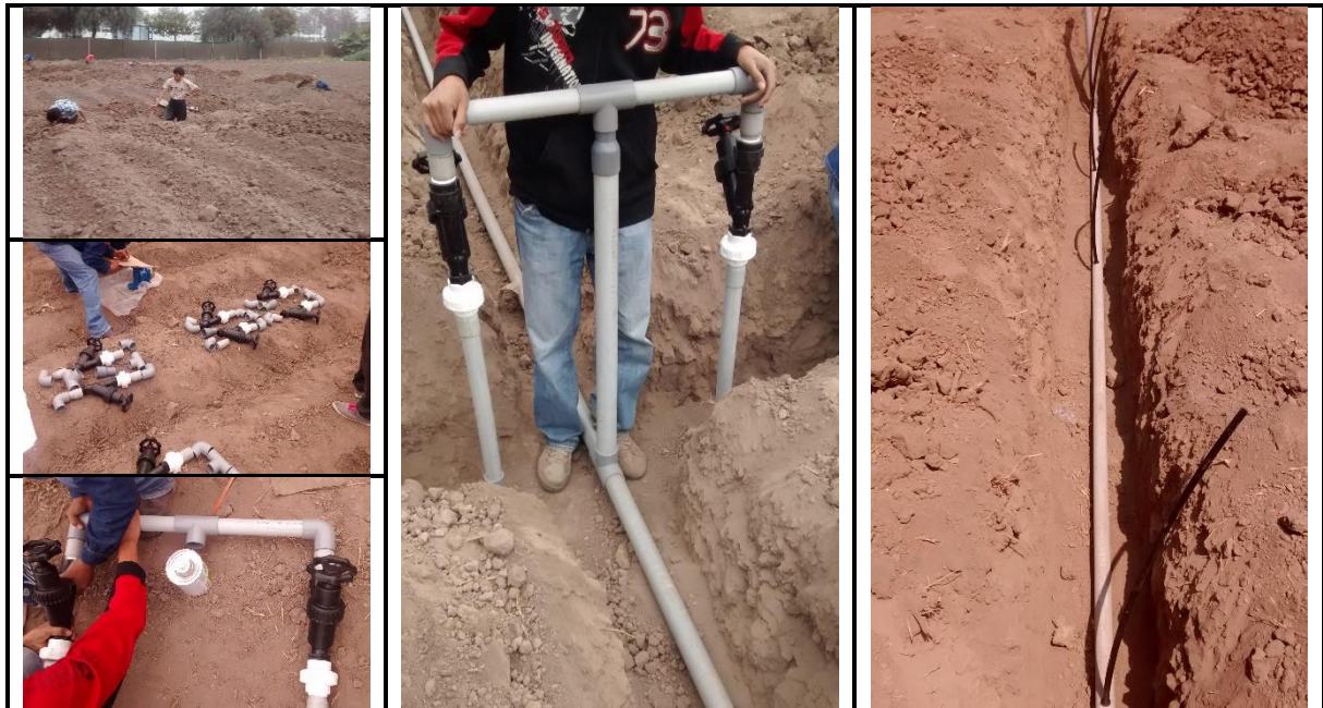
Figura 50. Preparación e instalación del sistema de riego
