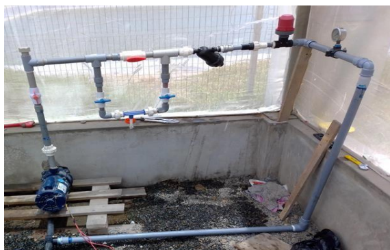
Instalación del cabezal de riego
