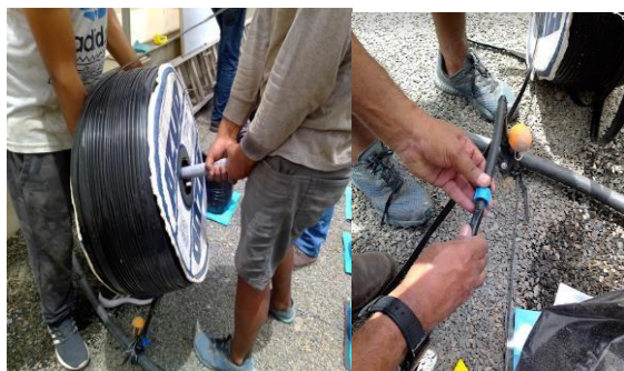
Instalación de las cintas de riego AZUD
