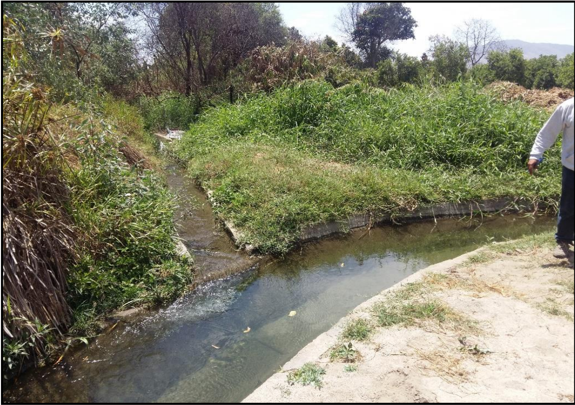
Figura 18: Vista del canal Unión Alta, progresiva 0+551.50
