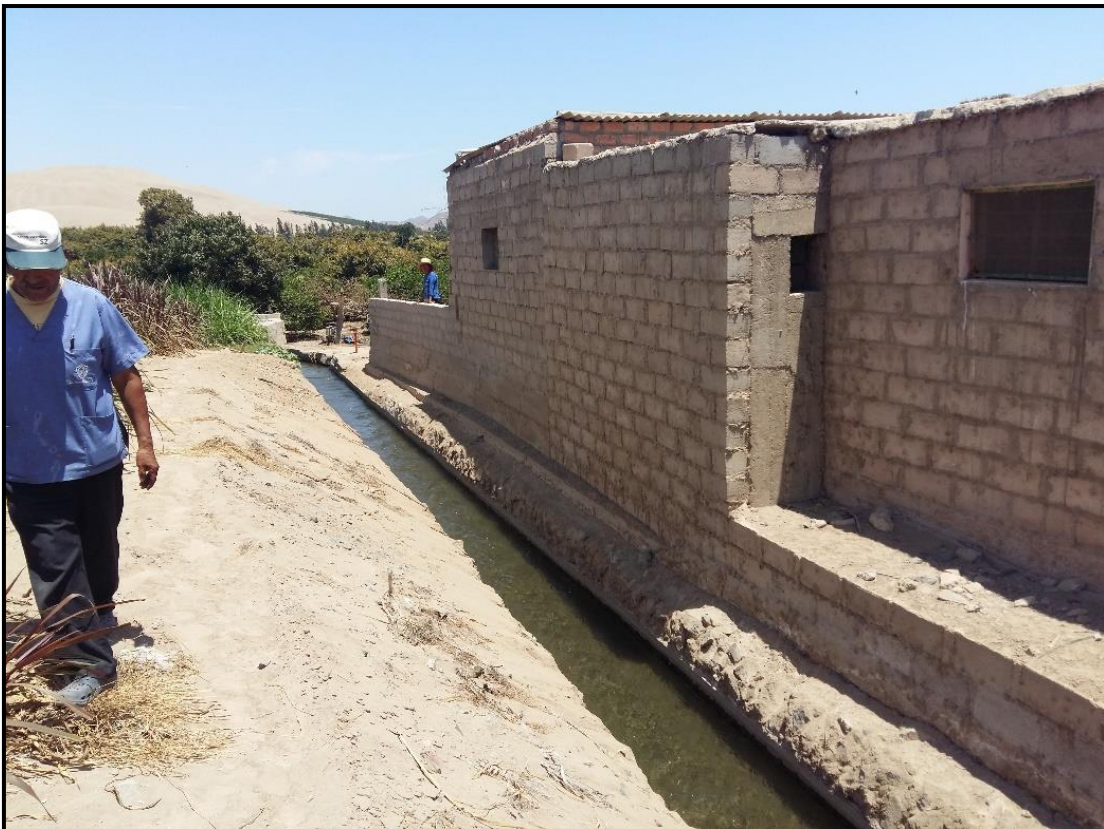
Figura 21: Vista del canal Unión Alta, progresiva 2+850
