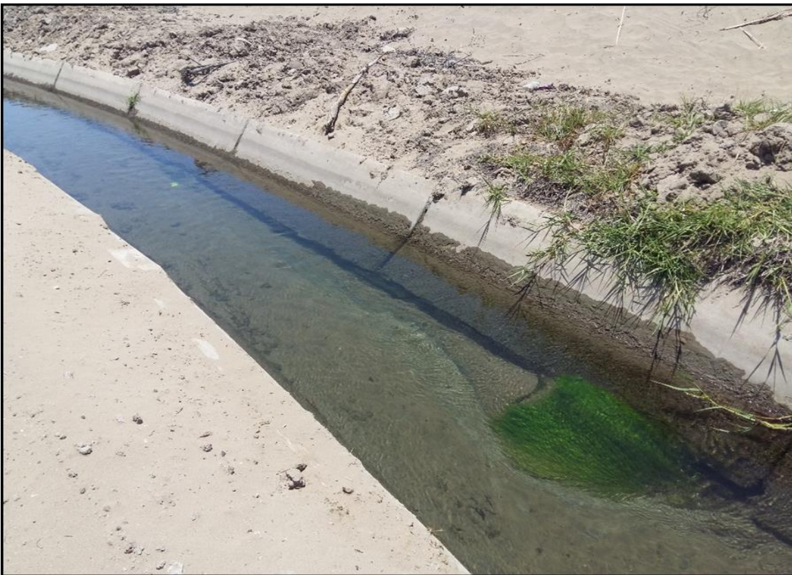
Figura 13: Vista del canal Unión Alta, progresiva 01+340
