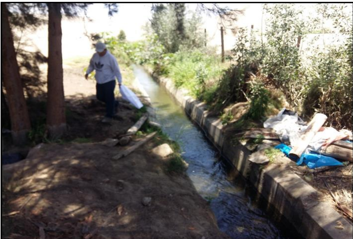
Figura 15: Vista del canal Unión Alta, progresiva 01+770
