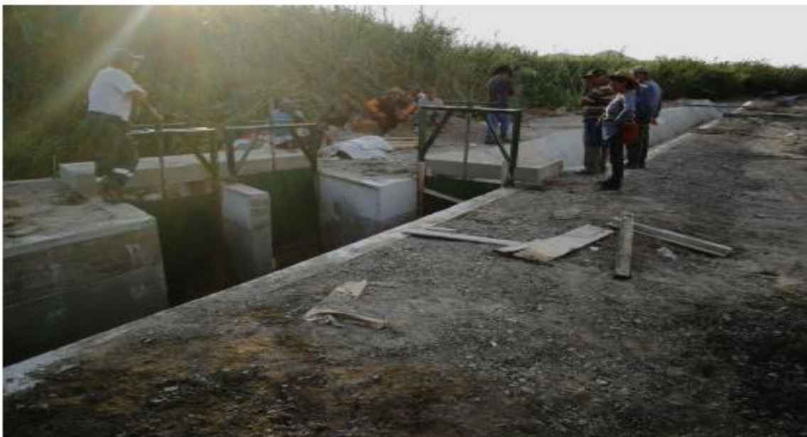
Figura 32: instalación de compuertas
