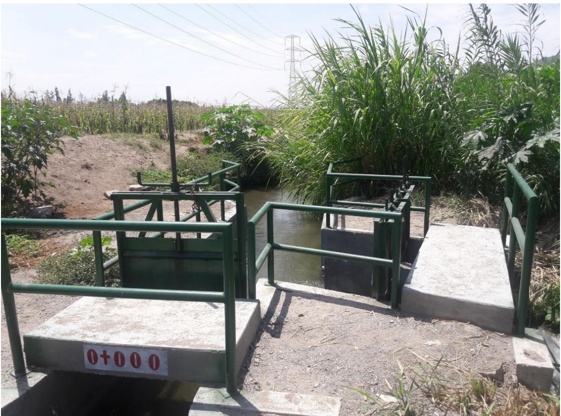
Figura 39: Estructura acabada y con progresiva.
