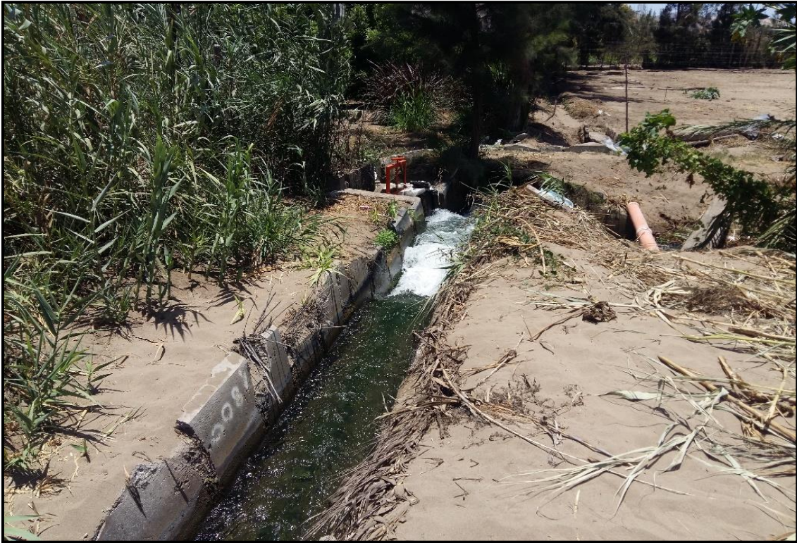
Figura 16: Vista del canal Unión Alta, progresiva 01+820
