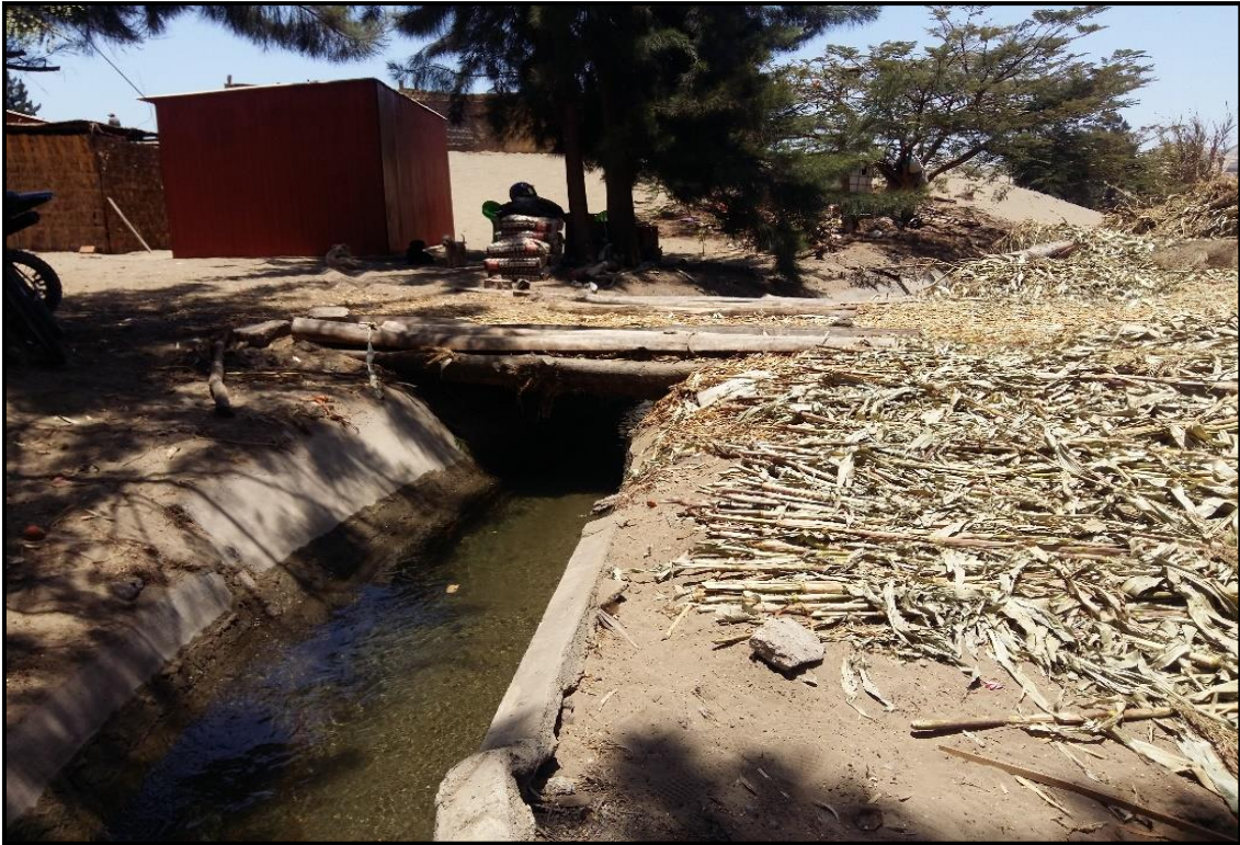
Figura 20: Vista del canal Unión Alta, progresiva 1+441.50
