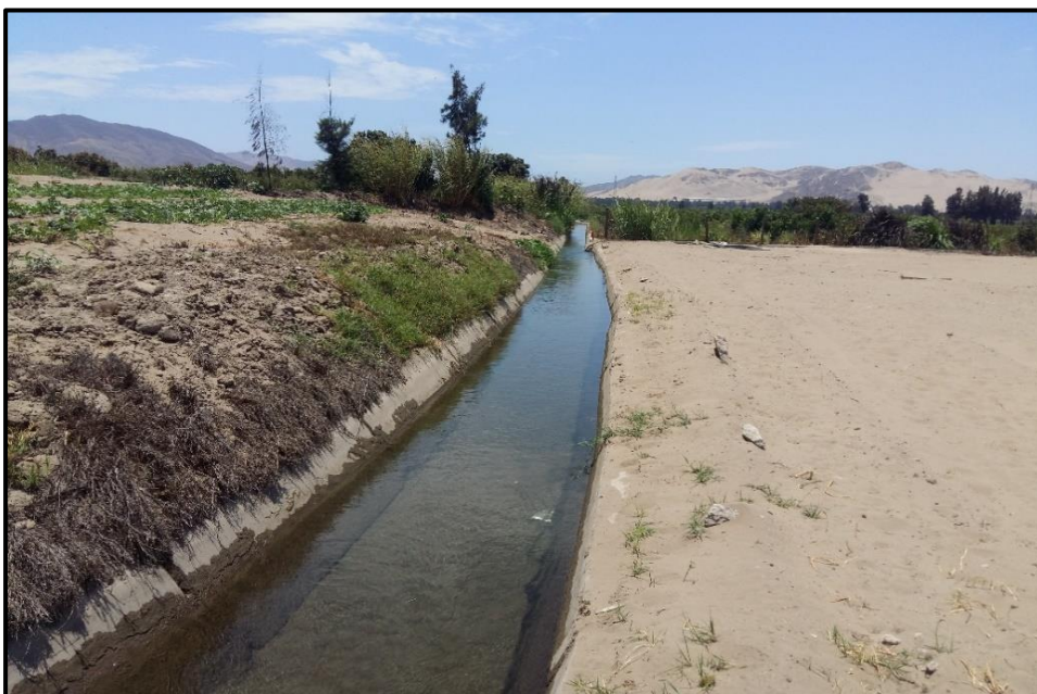
Figura 11: Vista del canal Unión Alta, progresiva 01+290
