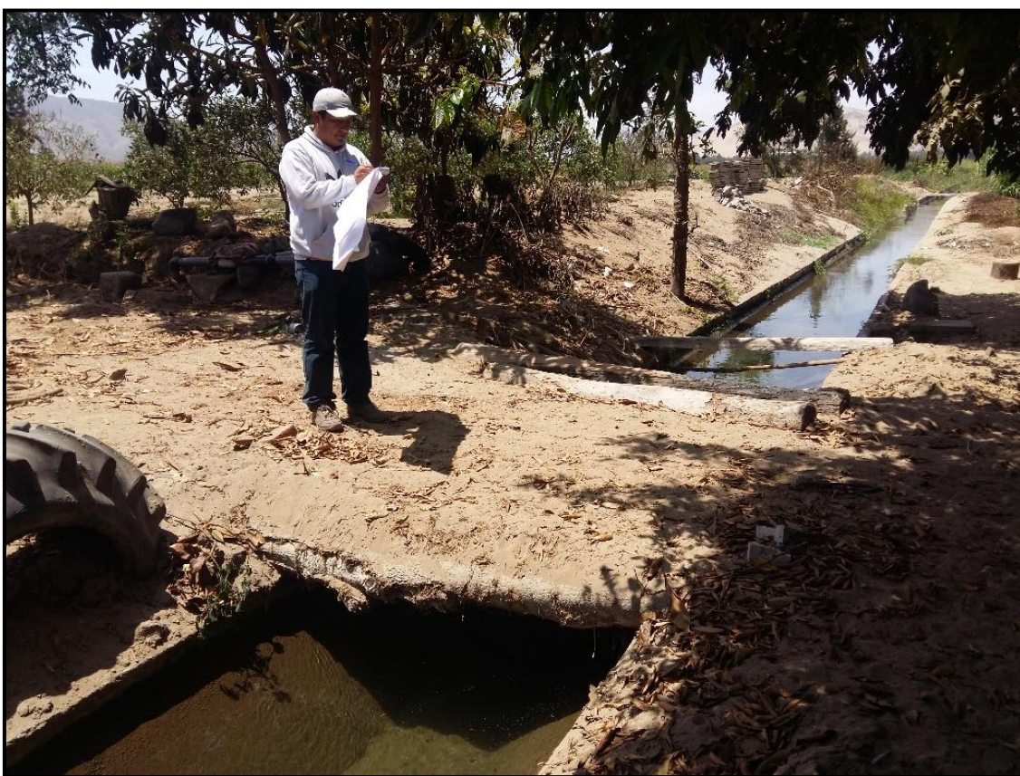
Figura 17: Vista del canal Unión Alta, progresiva 0+551.50
