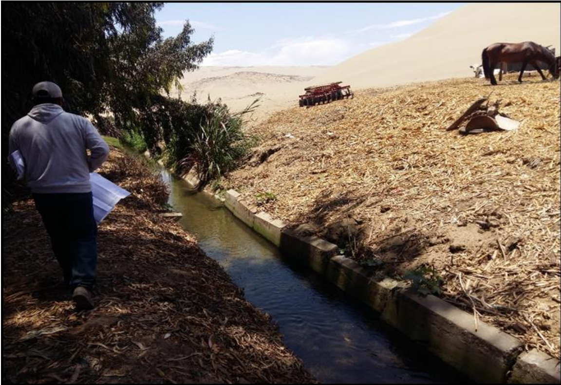
Figura 14: Vista del canal Unión Alta, progresiva 01+510
