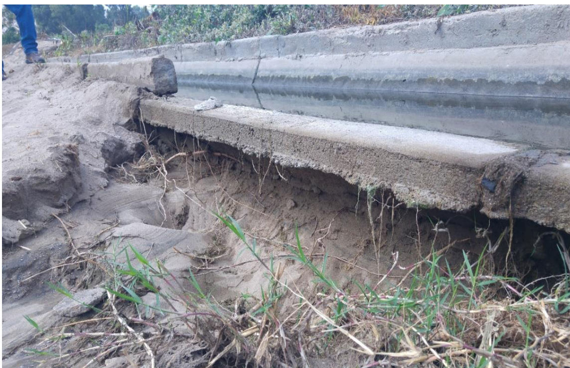
Figura 25: Vista del canal Unión Alta, progresiva 1+030.50
