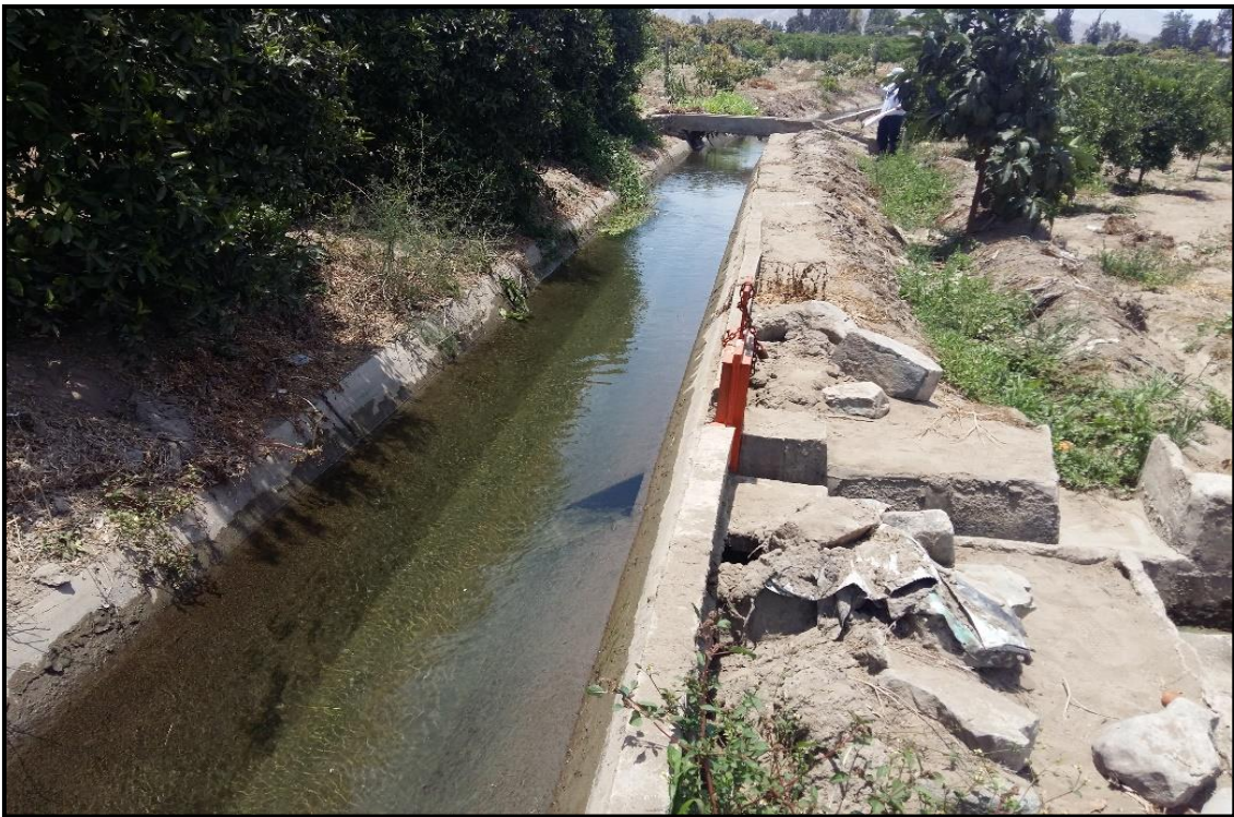
Figura 19: Vista del canal Unión Alta, progresiva 1+083.50
