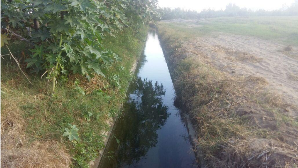
Figura 26: Vista del canal Unión Alta, progresiva 0+800.50, con pendiente nula.
