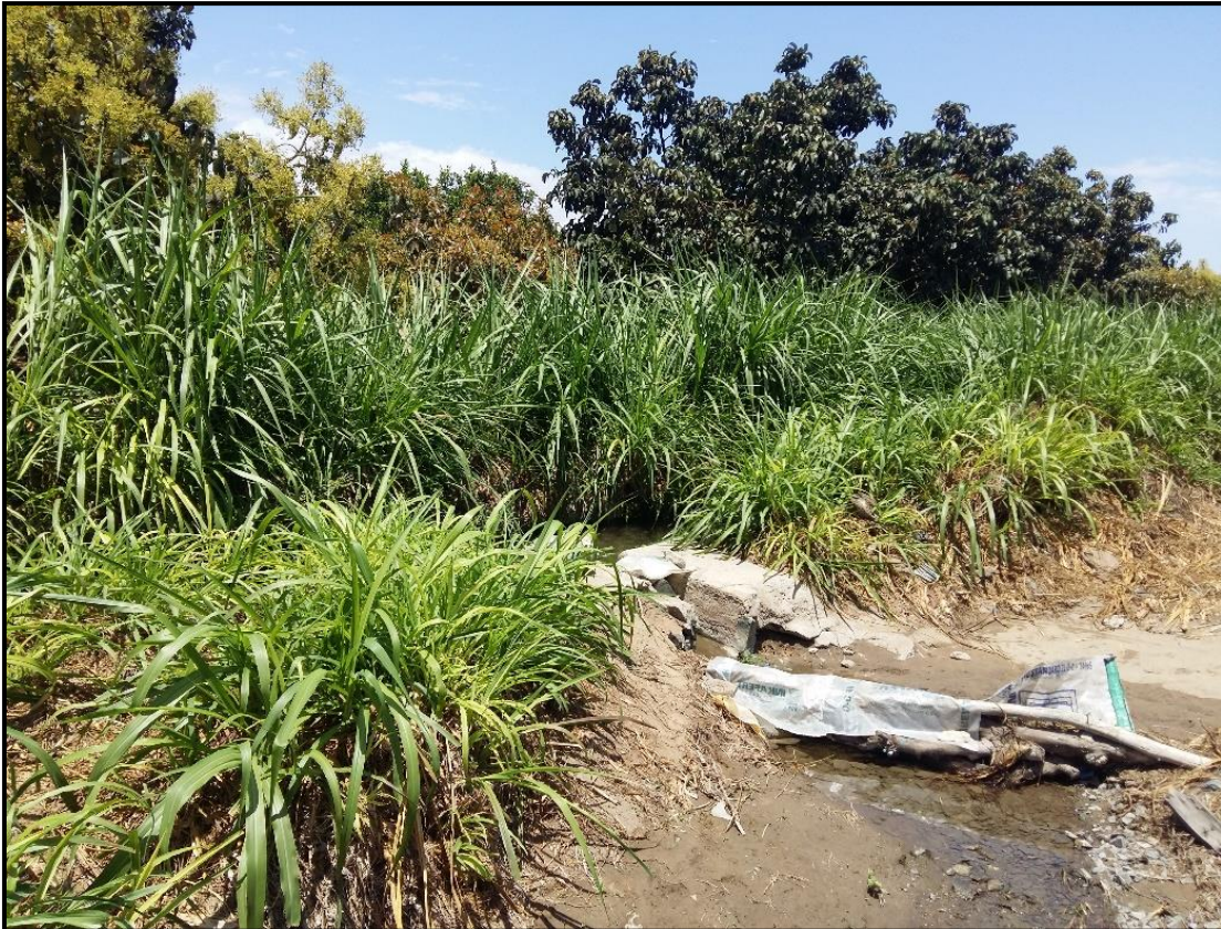
Figura 22: Vista del canal Unión Alta, progresiva 2+933.50
