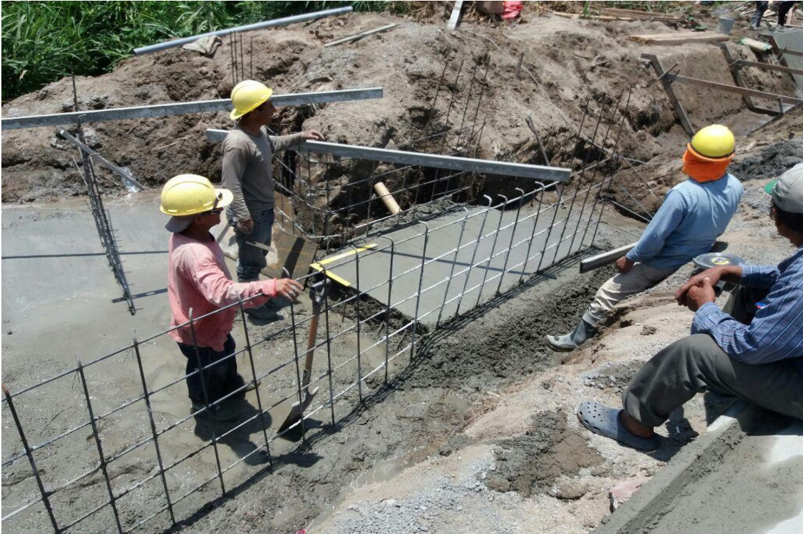
Figura 38: proceso de construcción de estructura partidor .
