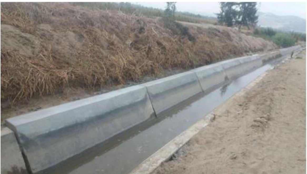
Figura 31: Tramo crítico totalmente reparado
