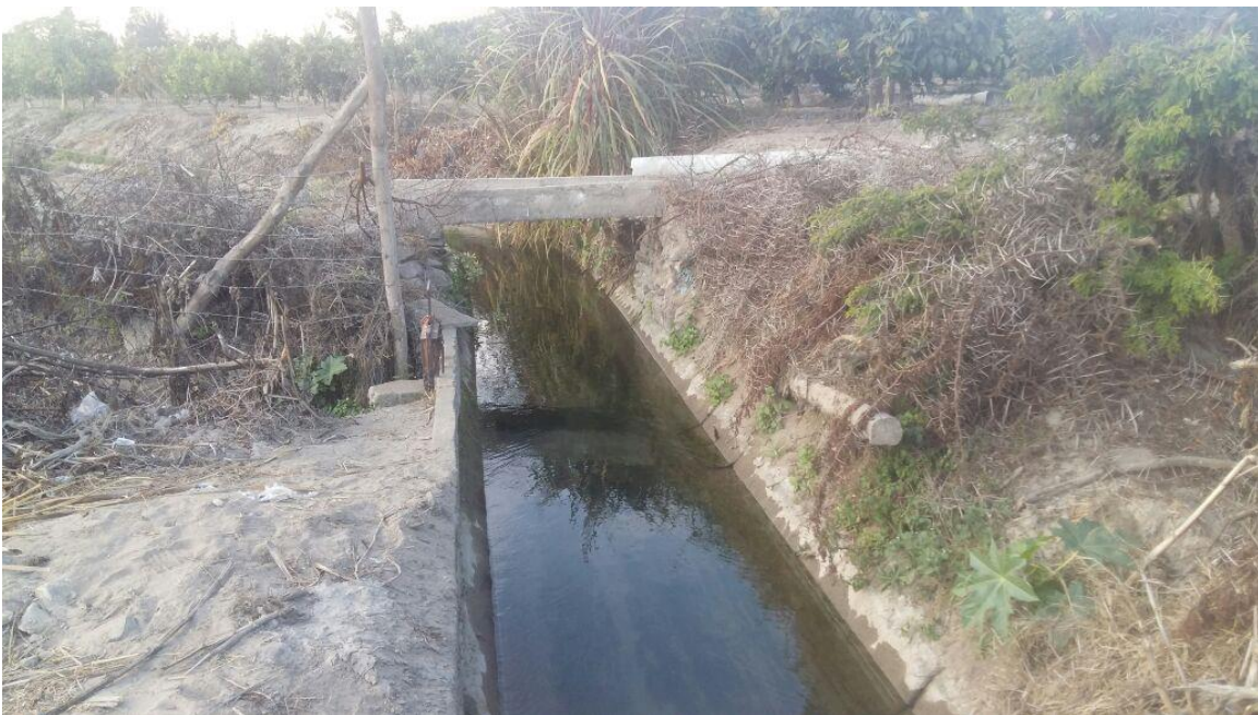
Figura 27: Vista del canal Unión Alta, progresiva 0+930.50 con pendiente nula.
