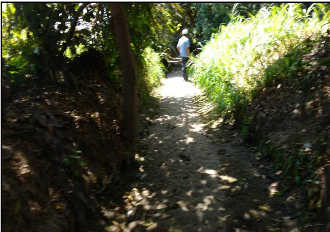
Figura 23: Vista del canal Unión Alta, progresiva 4+520.50
