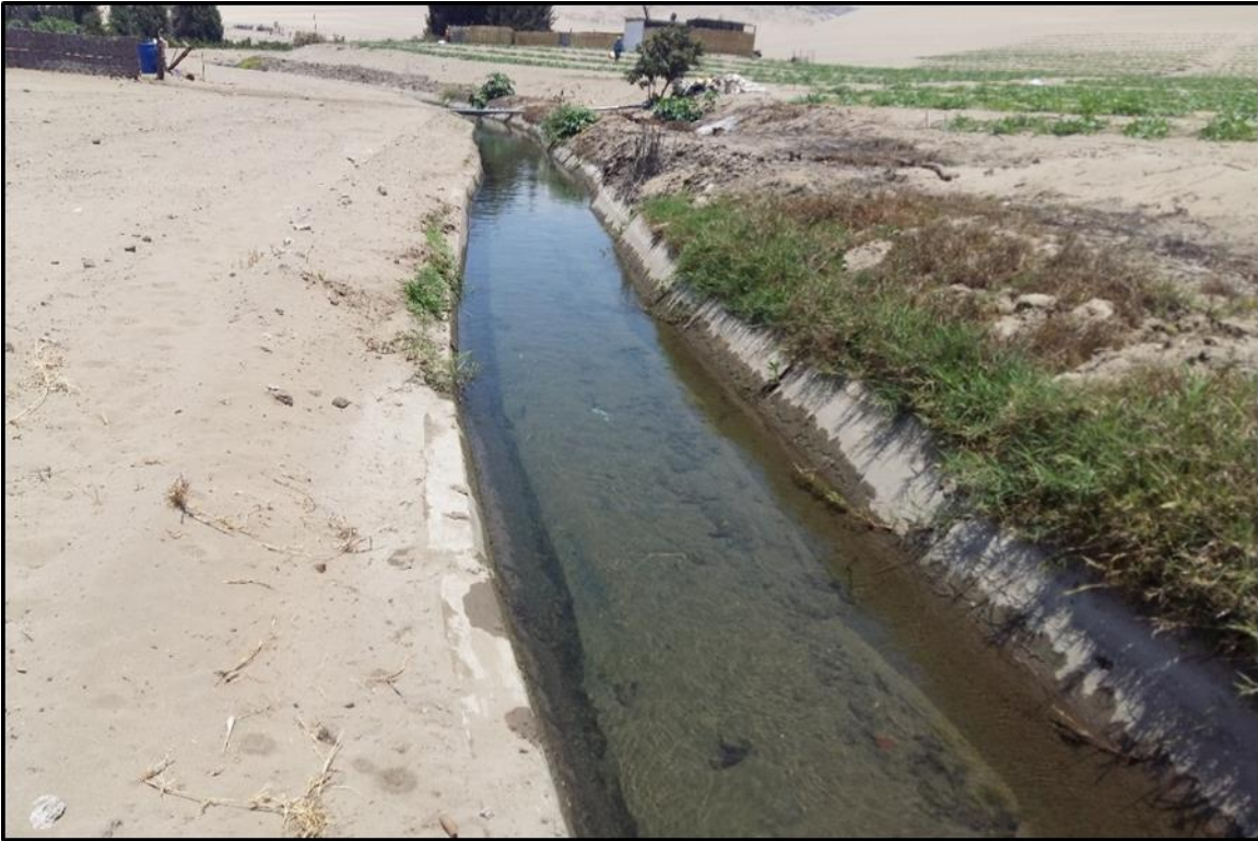
Figura 12: Vista del canal Unión Alta, progresiva 01+310
