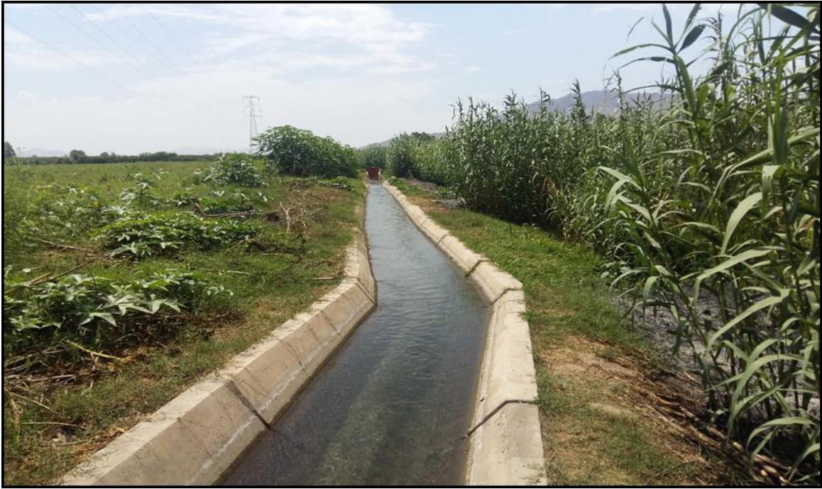
Figura 9: Canal derivador Unión Alta
