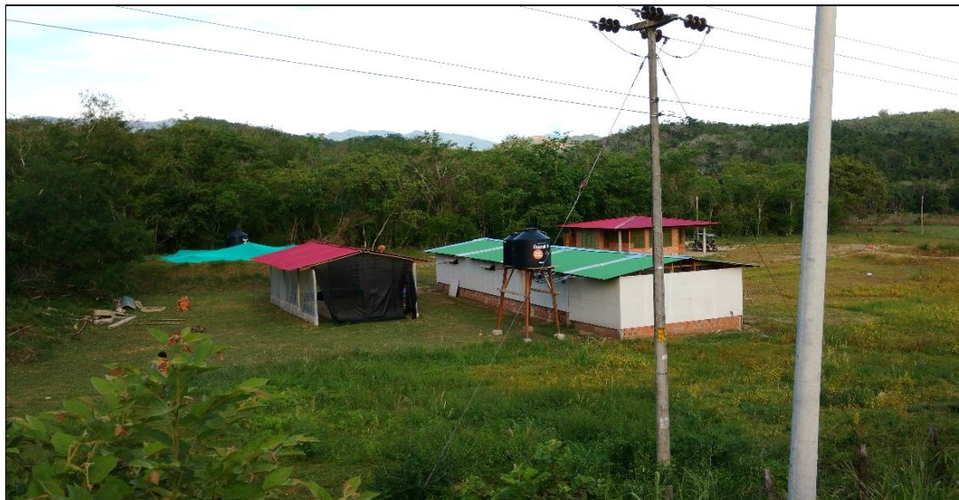
Vista panorámica de las construcciones, etapa 1. Comprende: Invernadero secundario (tanques de biofloc), invernadero principal (incubación y alevinaje), reservorio con geomembrana (izquierda), casa de administración y estanques de tierra para levante de alevines.
