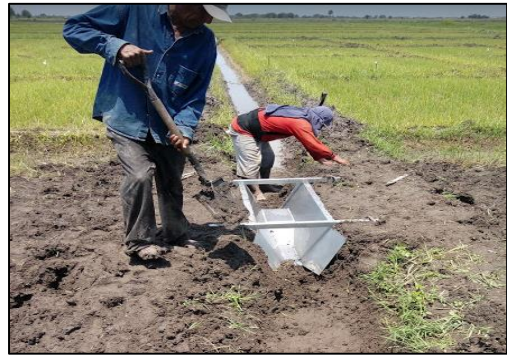
Anexo 33: Instalación de vertedero.
