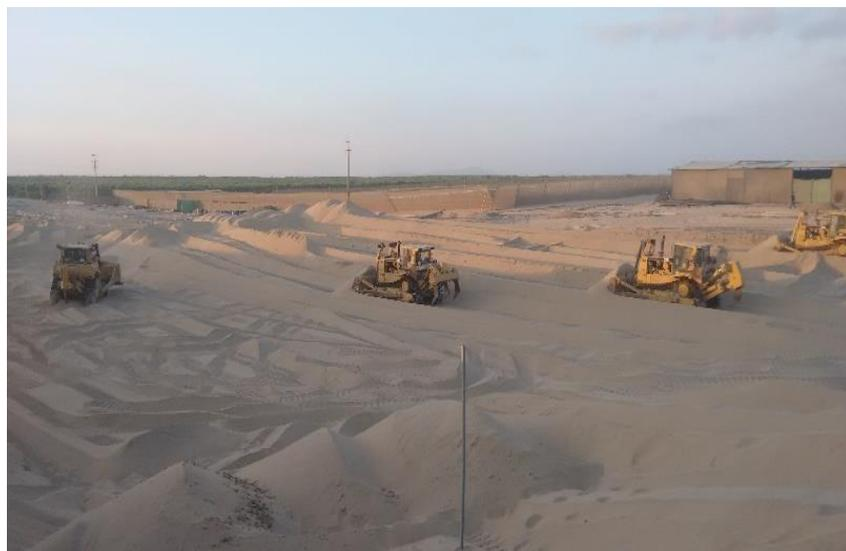
**Figura 8:** Nivelación gruesa con maquinaria pesada Caterpillar oruga D8
