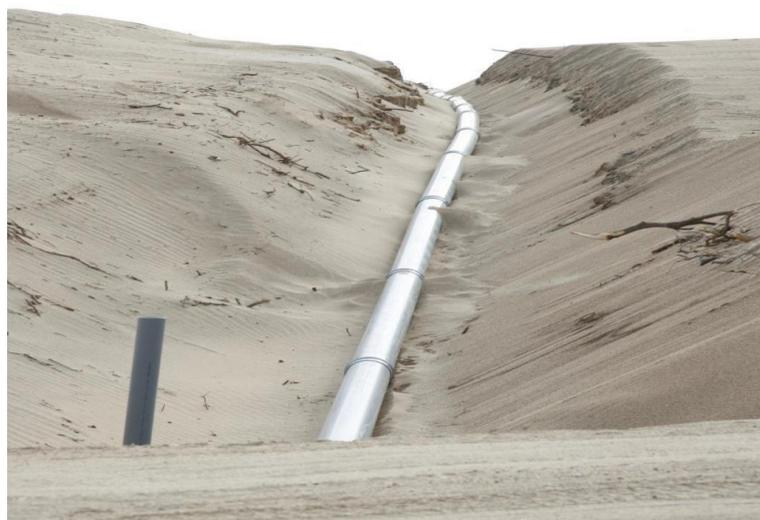
**Figura 14:** Instalación de la tubería de PVC en la zanja realizada por la excavadora.
