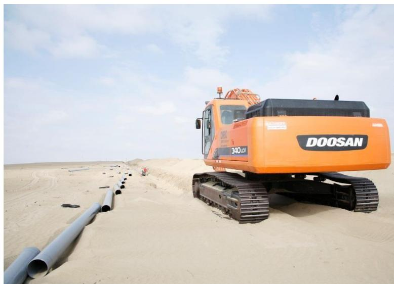
**Figura 13:** Excavadora realizando la zanja.
