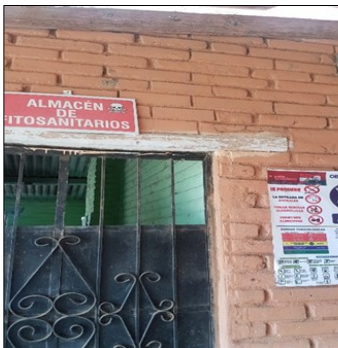
Figura 10: Almacén de Fitosanitarios.
