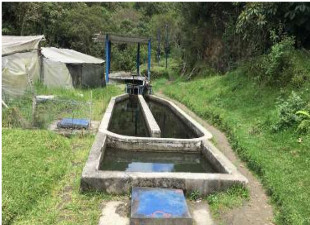
Figura 13. Captación Jipiro 1 – Jipiro 2
