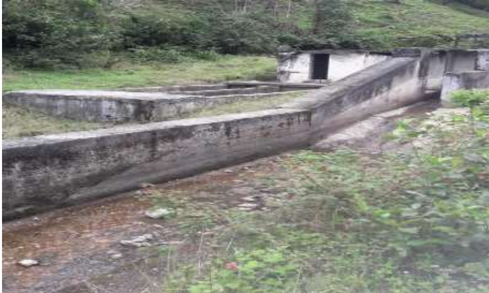
Figura 14. Captación San Simón
