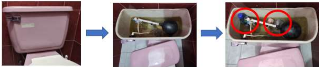
Figura 30. Procedimiento de ahorro de agua en tanque de inodoros.
