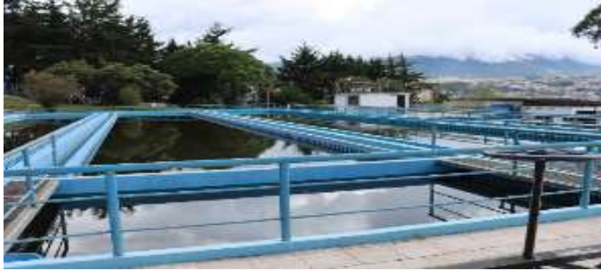
Figura 16. Planta de agua potable Pucará
