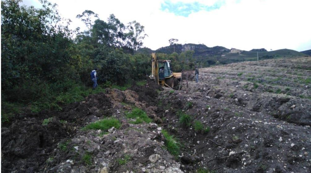
**Figura 24: Zanjado para red matriz y portalaterales de riego**
