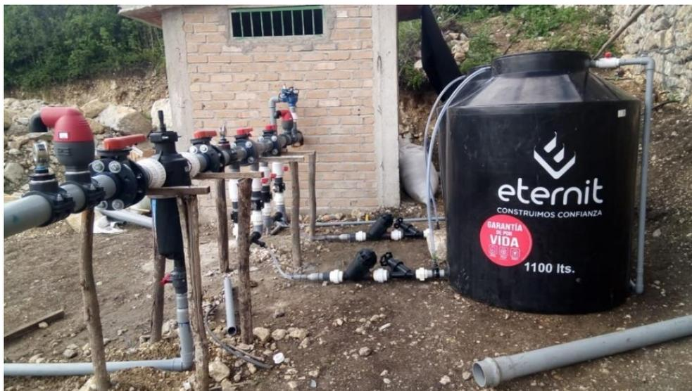
**Figura 26: Cabezal de riego del Lote 1 durante su instalación**
