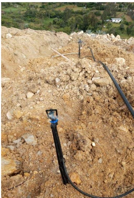
**Figura 20: Microaspersor autocompensado Rivulis RFR**
