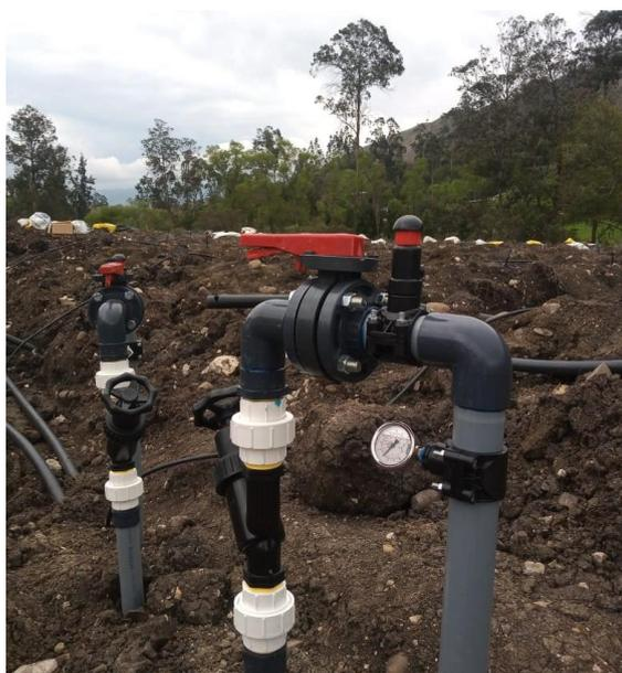
**Figura 17: Arco de riego típico del proyecto**
