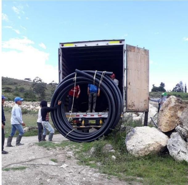
**Figura 29: Descarga de tubería matriz.**
