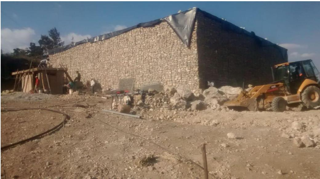
**Figura 5: Reservorio de  $3,000\text{ m}^3$ , construido con gaviones.**
