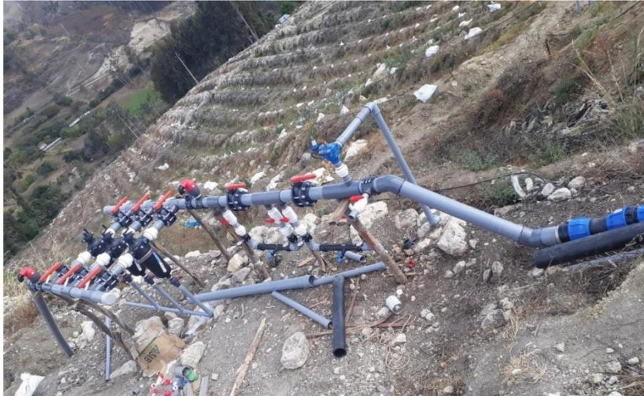
**Figura 25: Cabezal de riego del Lote 2 durante su instalación.**
