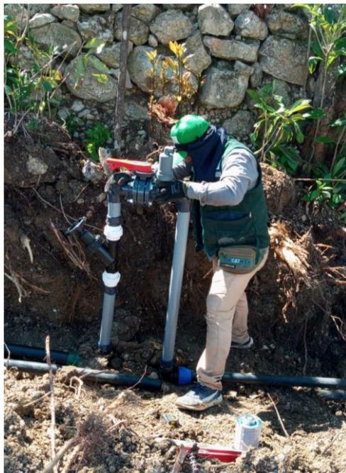
**Figura 31: Instalación de arco de riego.**
