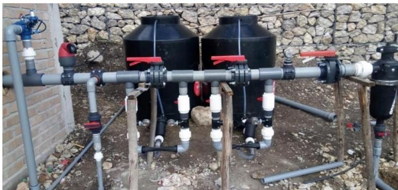
**Figura 10: Sistema de filtrado y fertilización del Lote 1**
