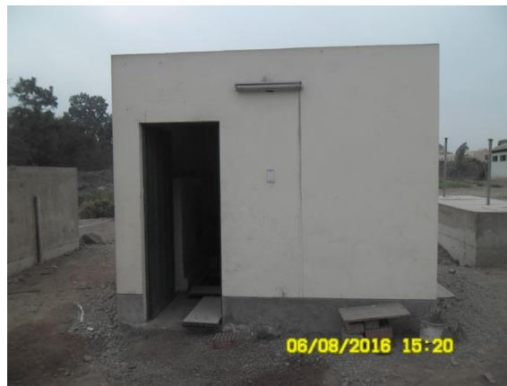
Figura 42. Caseta de bombeo
