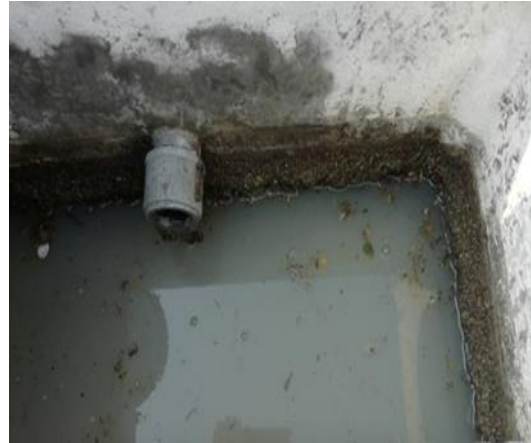
Figura 17. Tubería actual de entrada al tanque baffled
