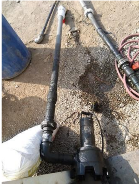
Figura 46. Limpieza de la bomba de captación
