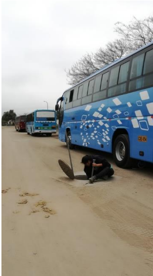
Figura 40. Limpieza del buzón de derivación
