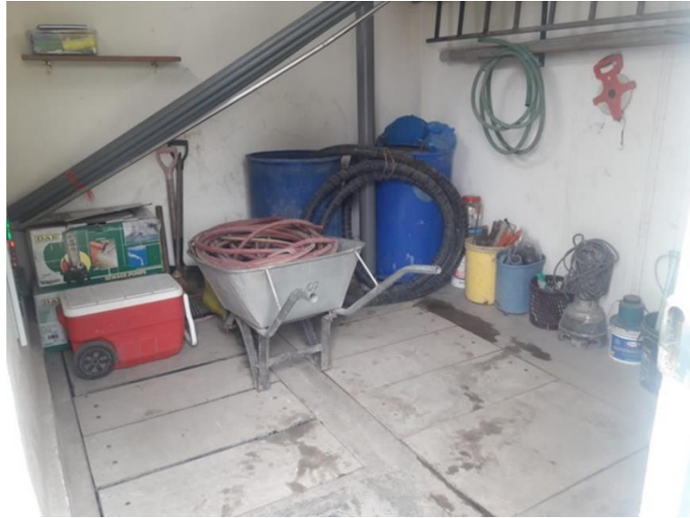
Figura 43. Interior de la caseta de bombeo
