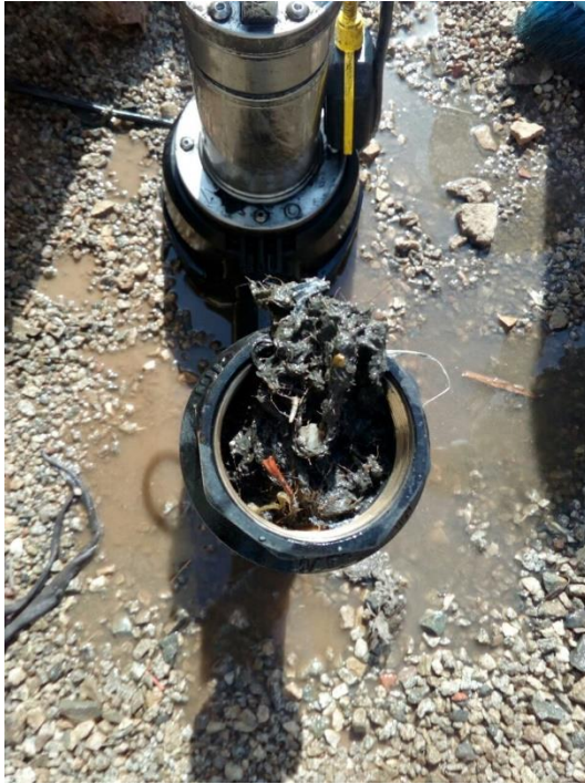
Figura 47. Extracción de material no deseado de las bombas de captación
