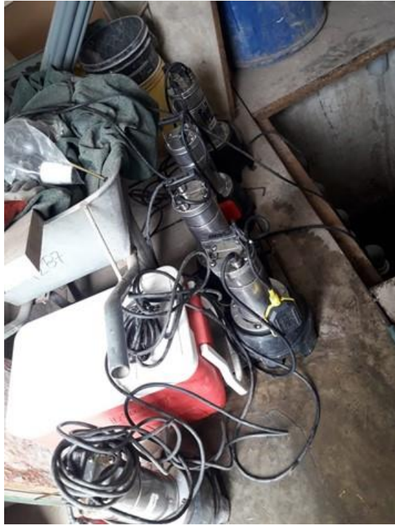
Figura 45. Bombas de captación de aguas residuales domésticas
