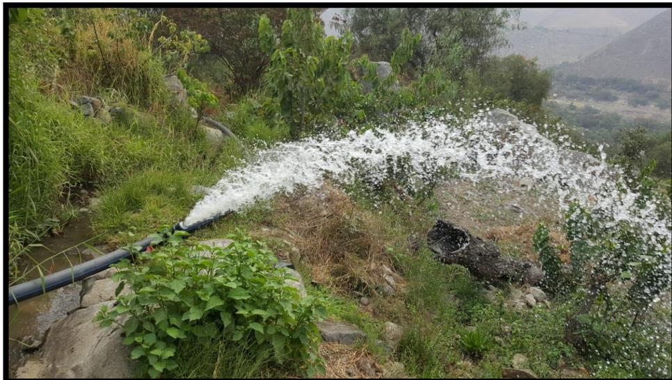
**Figura 32: Prueba hidráulica final**
