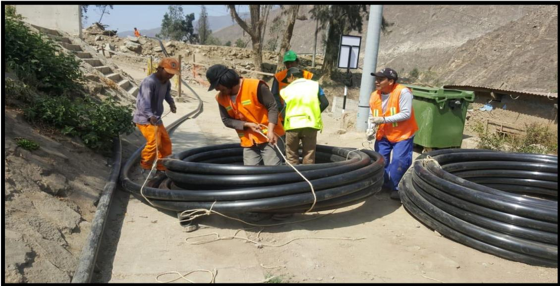
**Figura 20: Desenrollamiento de manguera de HDPE de 90mm**
