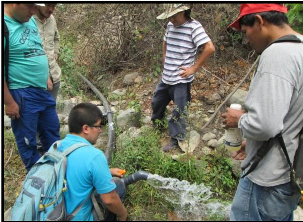
**Figura 30: Pruebas hidráulicas presurizadas**
