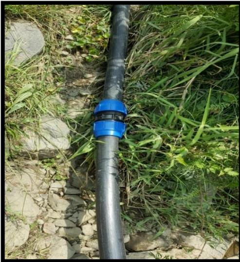
**Figura 25: Instalación de uniones**
