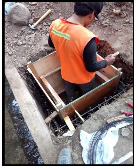
**Figura 24: Encofrado captación**
