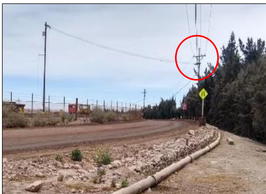
Figura 5: Punto de energía eléctrica en Villa Botiflaca
