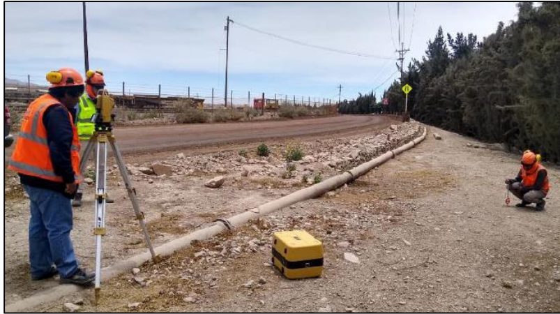
Figura 10: Levantamiento topográfico con estación total
