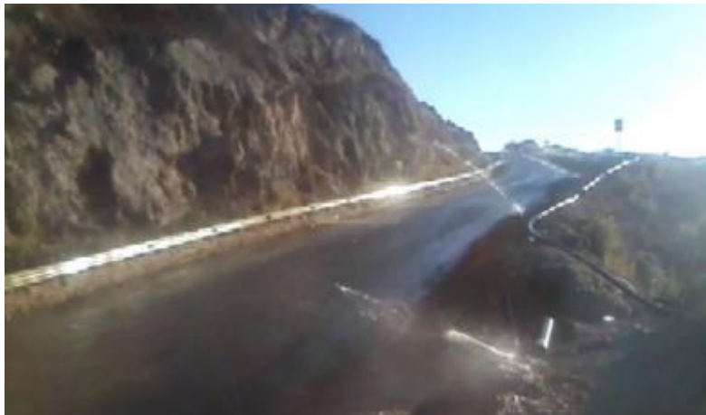
Figura 4: Riego por aspersión en las vías de acceso para el control de polvos en la minera Barrick Lagunas Norte
