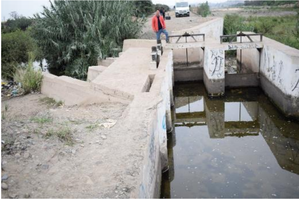
Figura 21: Toma de captación de la Comisión de Regantes Mejorada en la cuenca baja del río Lurín
