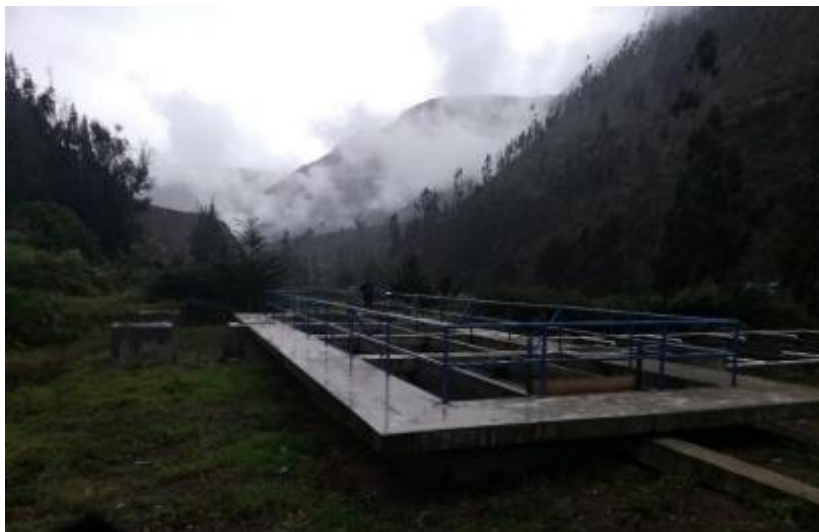
Figura 28: Supervisión de PTAR en el distrito de Palca
