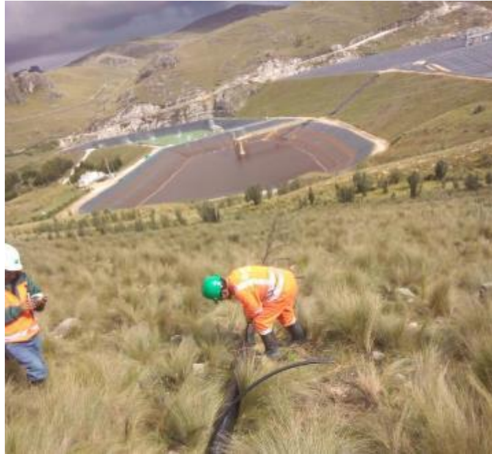
Figura 30: Conjunto de reservorios de la minera Barrick Lagunas Norte para el almacenamiento de aguas tratadas y su posterior uso en el riego por micro aspersión
