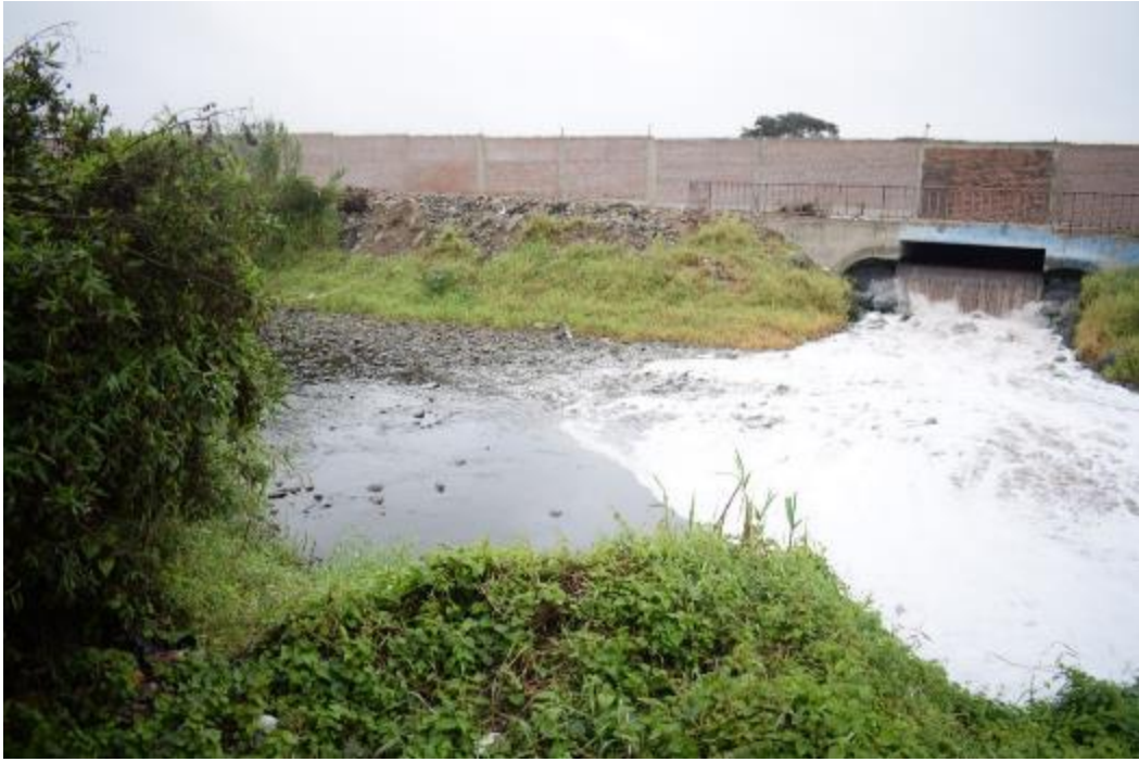
Figura 22: Inspección de la descarga de la PTAR San Bartolo al río Lurín
