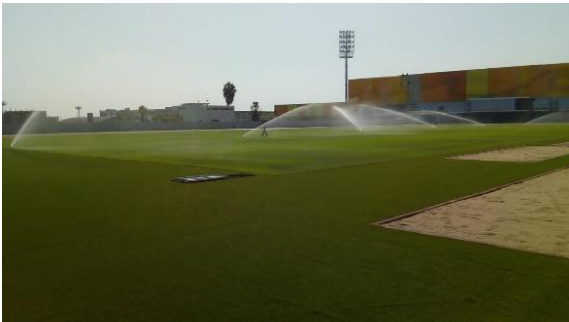
Figura 29: Sistema de riego por aspersión para áreas verdes en la VIDENA
