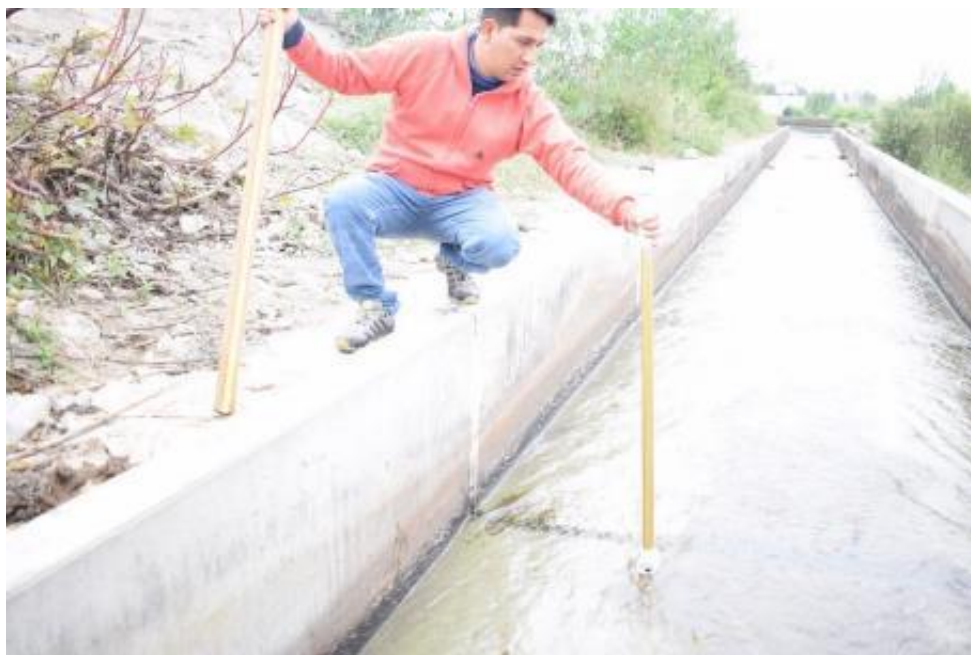
Figura 11: Inspección de canales de riego en la cuenca baja del río Lurín
