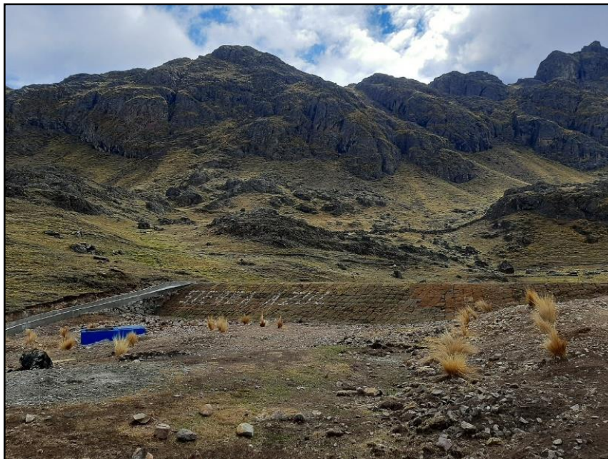
Figura 16: Cobertura de champa en el talud aguas abajo en el dique de Patoccocha 1 (Hca12-2019-Q2)
