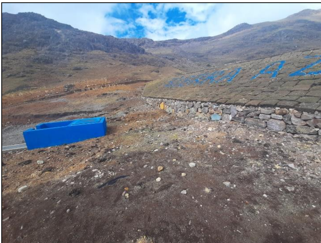
Figura 17: Cobertura de champa en el talud aguas abajo en el dique de Loma (Hca12-2019-Q4)
