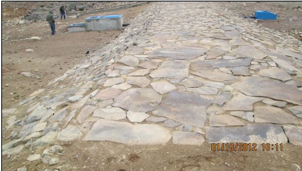
Figura 23: Dique de la qocha Tipiqocha (Hca15-2019-Q2)
