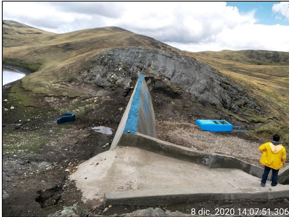
Figura 3: Dique de concreto ciclópeo de la gocha Canlalay (Hca13-2019-Q3)
