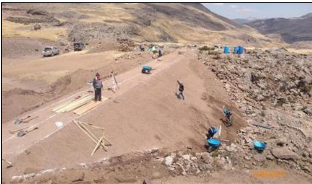
Figura 2: Dique de tierra de la qocha Pisgoqocha (Hca16-2019-Q8)
