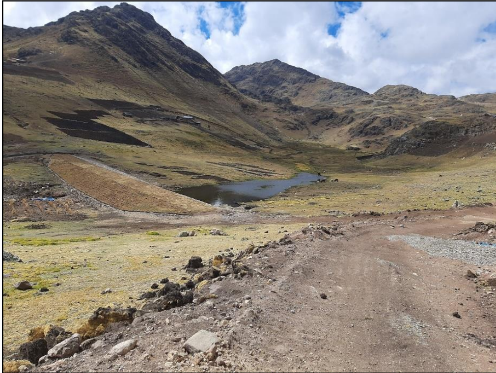
Figura 19: Cobertura de champa en el talud aguas abajo en el dique de Sorapata (Hca12-2019-Q6)
