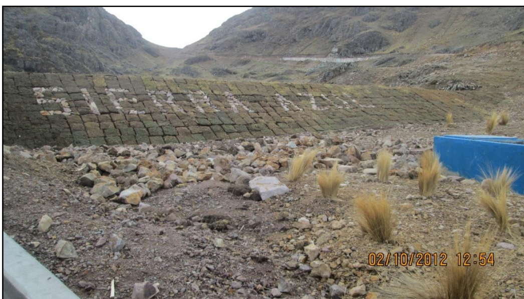
Figura 18: Cobertura de champa en el talud aguas abajo en el dique de Chicoticillo (Hca12-2019-Q5)
