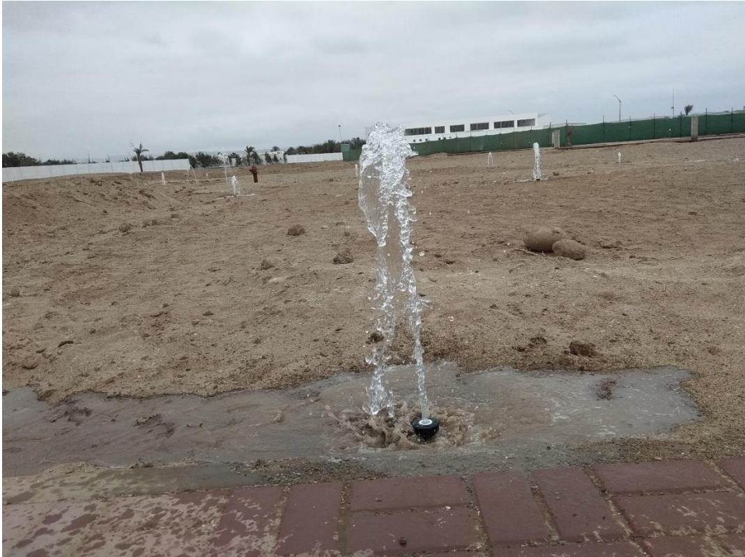
Figura 22: Purga de emisores de los emisores para riego por aspersión
