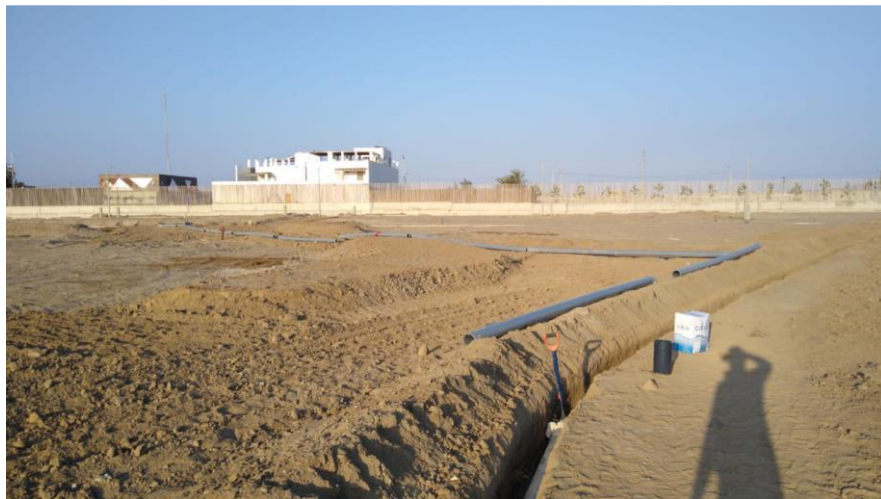
Figura 14: Zanja de porta lateral
