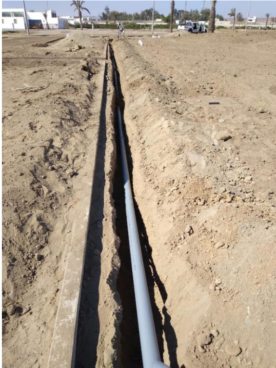
Figura 15: Tendido de tubería porta lateral en campo
