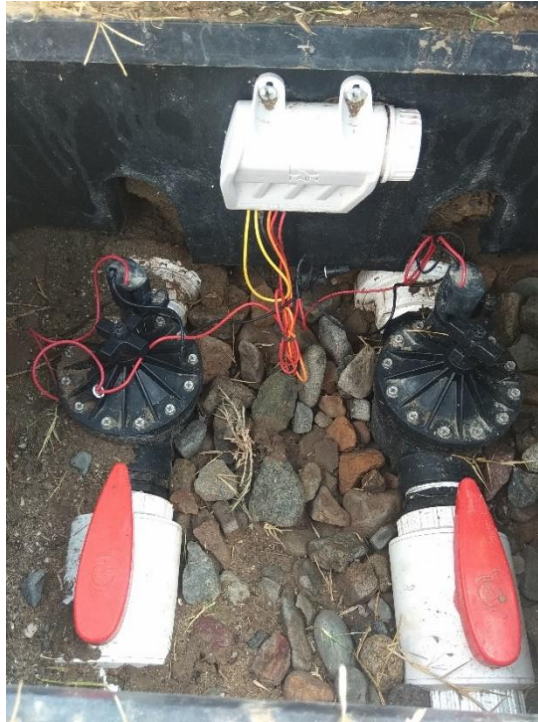
Figura 40: Programador BL-KR de dos estaciones instalado en proyecto
