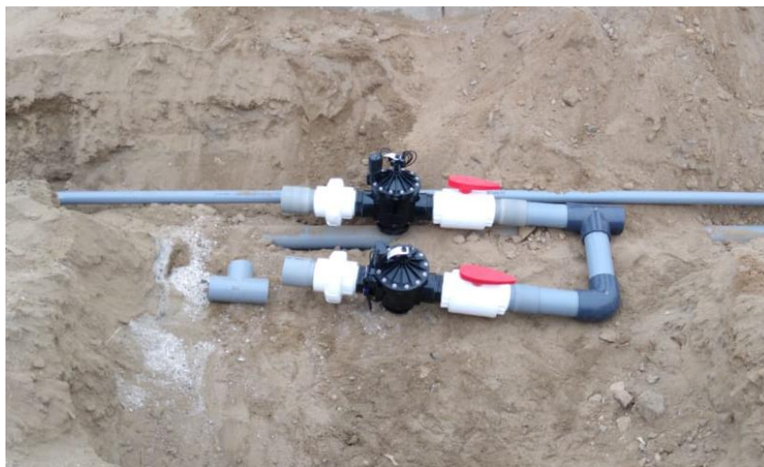
Figura 31: Instalación de arco de riego de 2"
