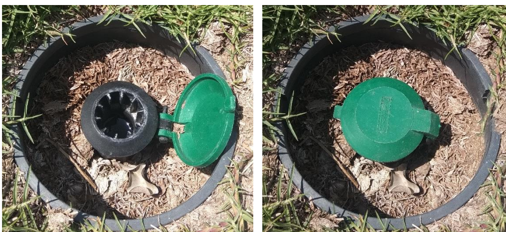
Figura 35: Válvulas de acople instaladas en campo
