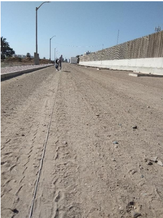
Figura 11: Tendido de cordel y trazo de las delimitaciones del área verde
