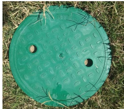
Figura 33: Tipo de cajas porta válvulas instaladas en campo
