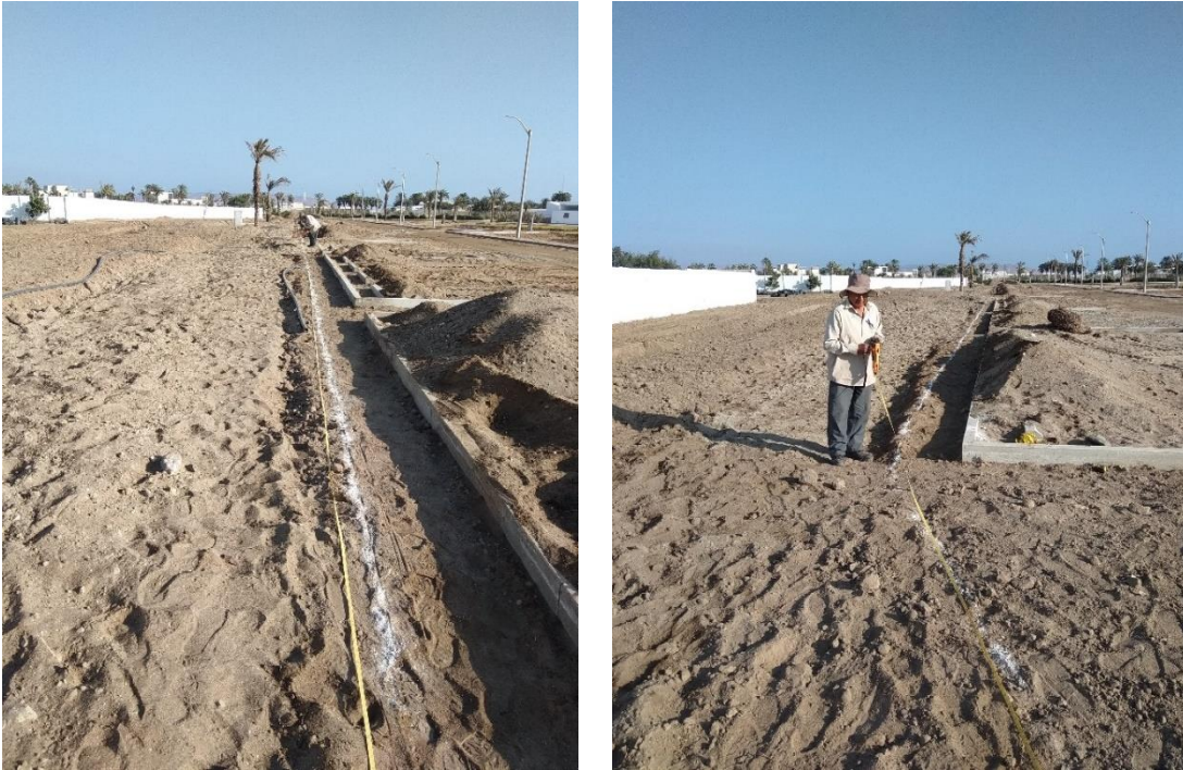
Figura 12: Trazo con yeso del paso de la tubería mediante wincha y cordel
