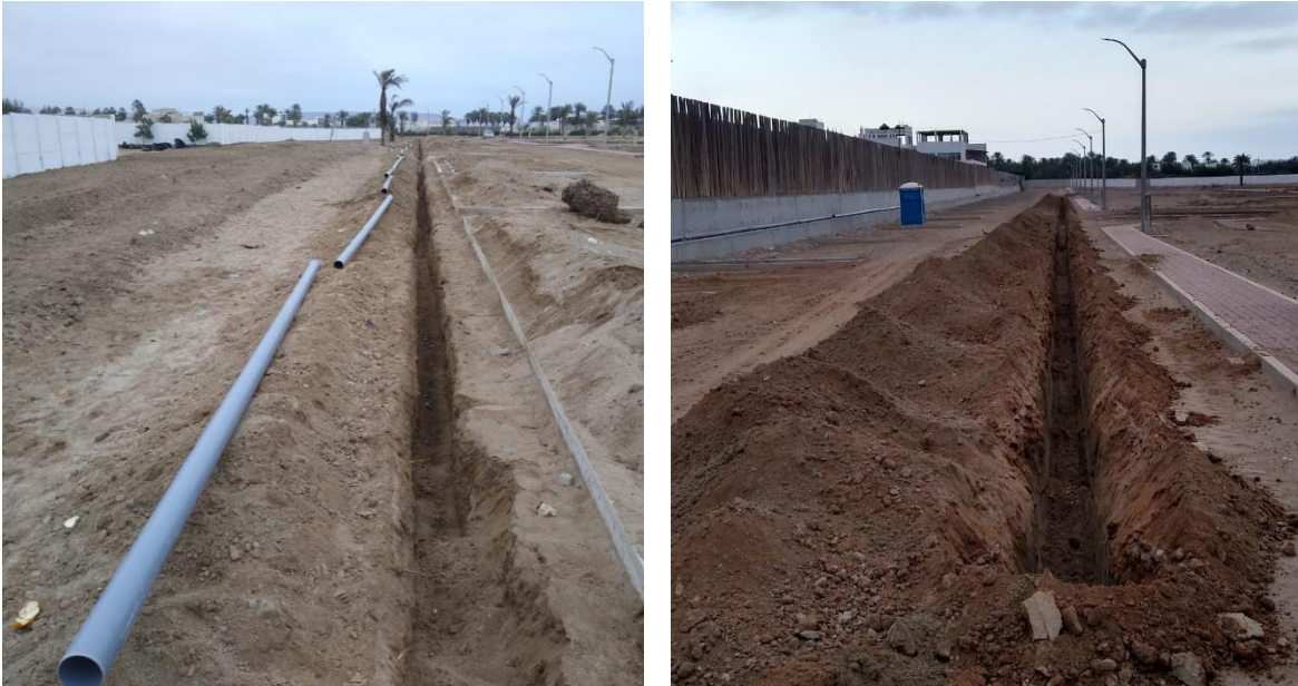
Figura 13: Zanja de porta laterales y matriz
