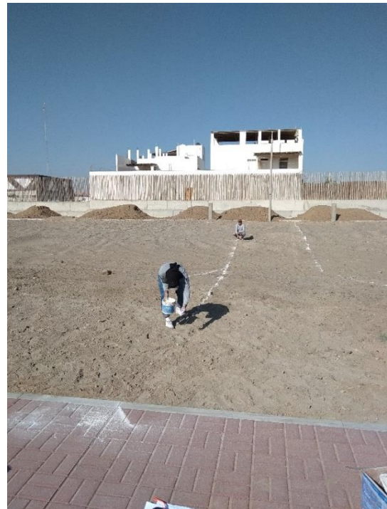
Figura 11: Tendido de cordel y trazo de las delimitaciones del área verde
