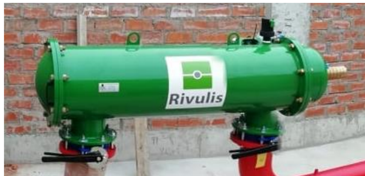
Figura 19: Filtro de mallas instalado en el cabezal de filtrado de agua dulce
