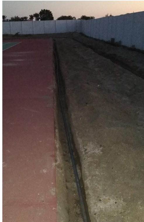
Figura 15: Tendido de tubería porta lateral en campo
