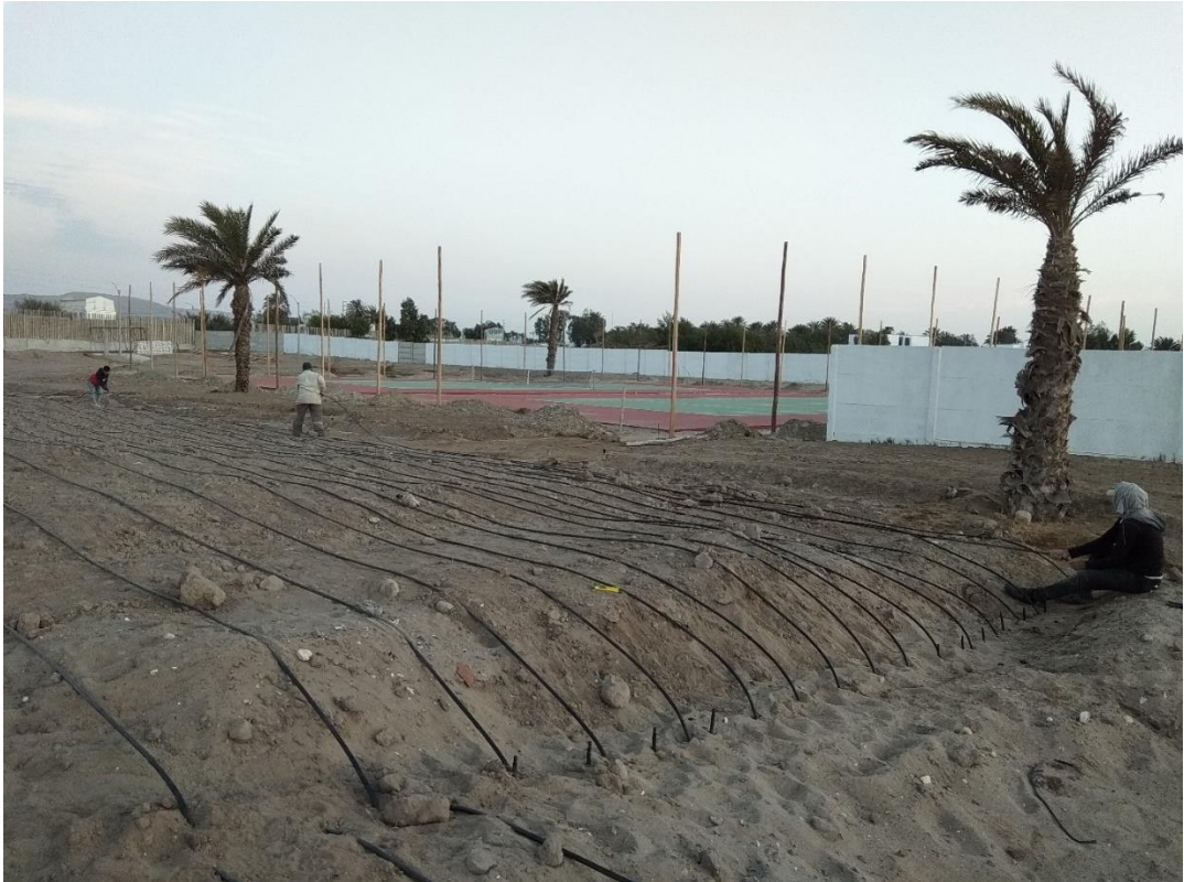
Figura 23: Instalación de bigotes de riego y tendido de mangueras
