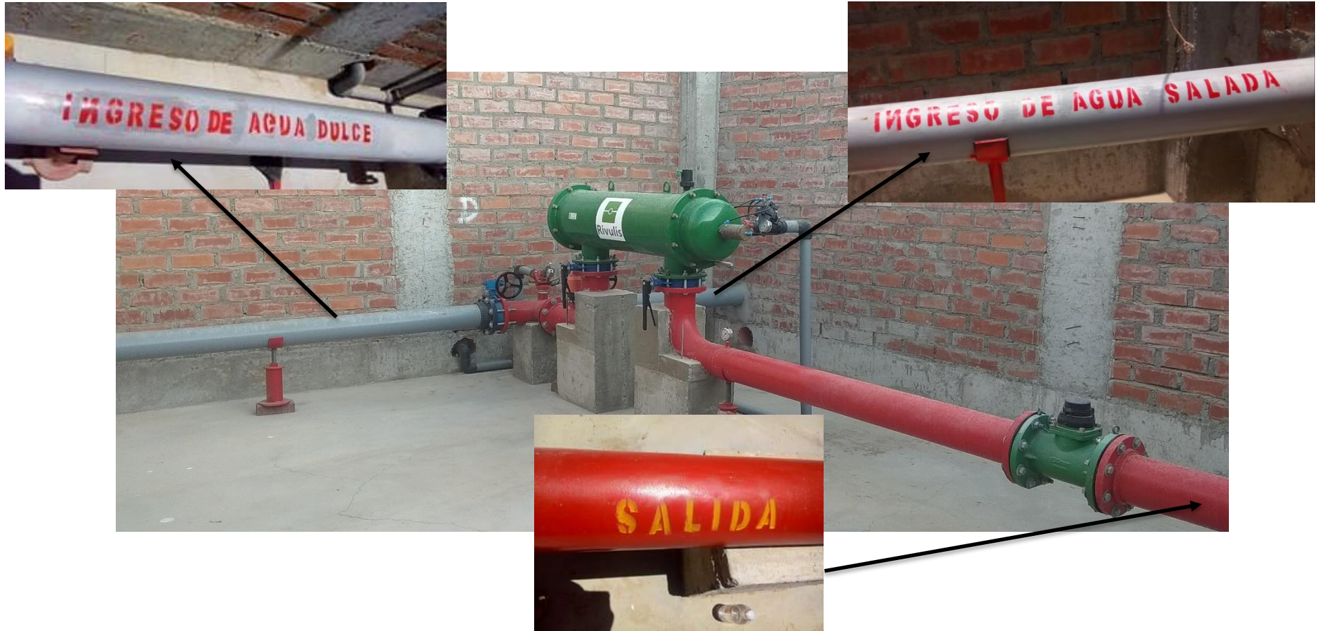
Figura 17: Esquema de entrada de agua según fuente en el cabezal de riego
