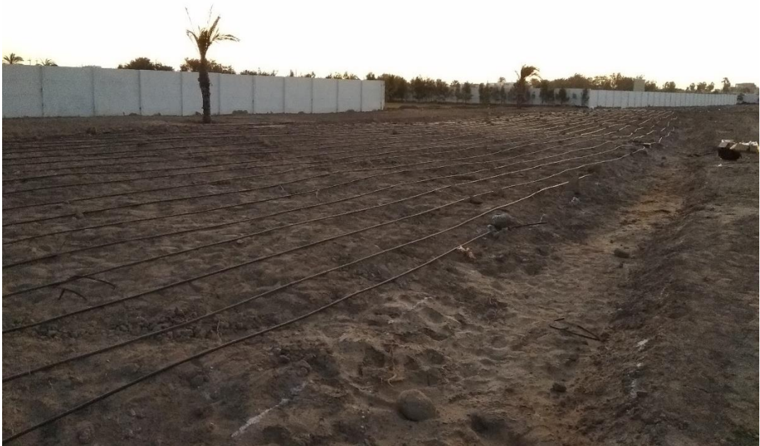
Figura 24: Tendido de mangueras de riego
