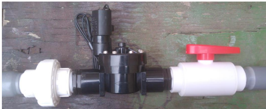
Figura 30: Presentación de arco de riego de 1"
