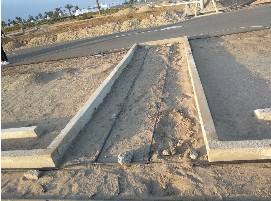
Figura 25: Instalación de manguera de riego en campo
