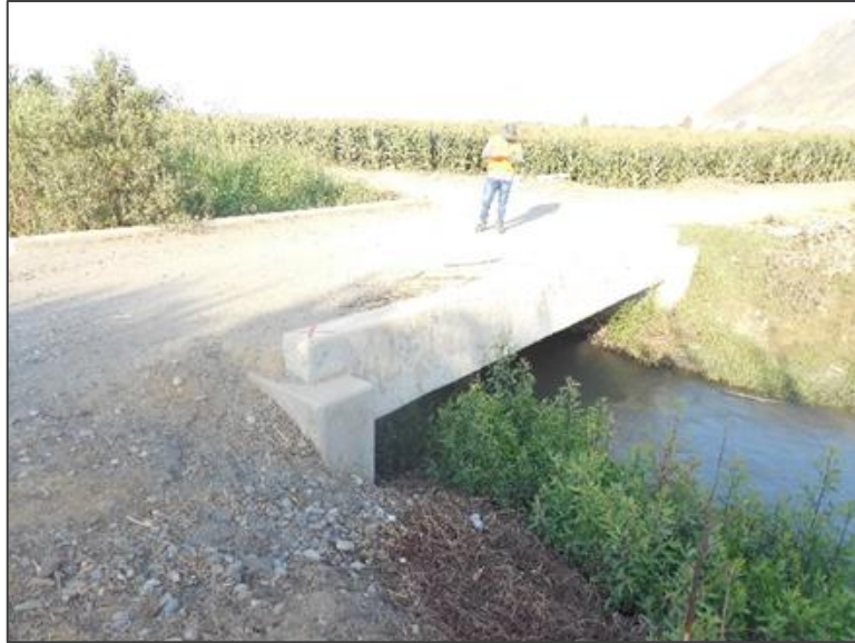
Figura 6: Puente vehicular ubicado en la progresiva Km. 6+414.12
