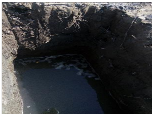
Figura 27: Calicata N° 4, profundidad 1.50 m. y ubicado en el Km. 7+948
