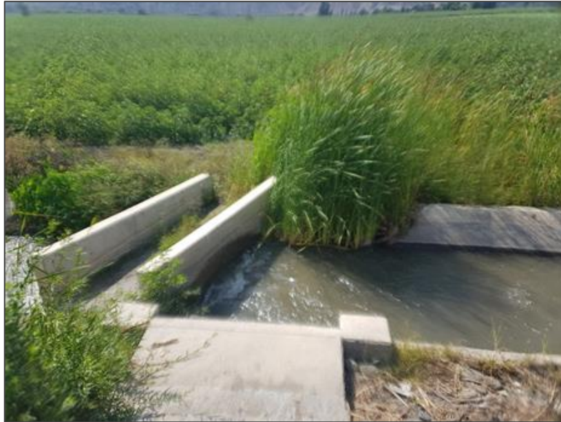
Figura 4: Puente peatonal ubicado en la progresiva Km. 4+602.36
