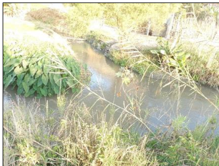
Figura 12: Dren partidor ubicado en la progresiva Km. 7+934
