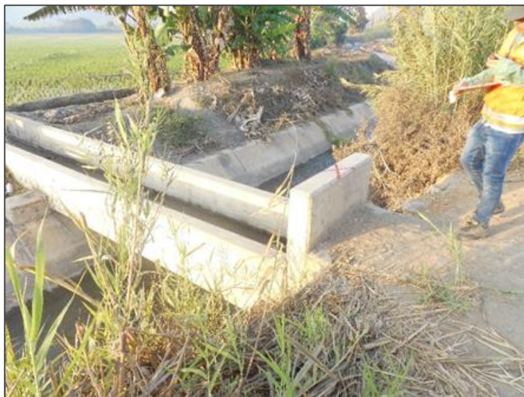
Figura 8: Acueducto ubicado en la progresiva Km. 8+340
