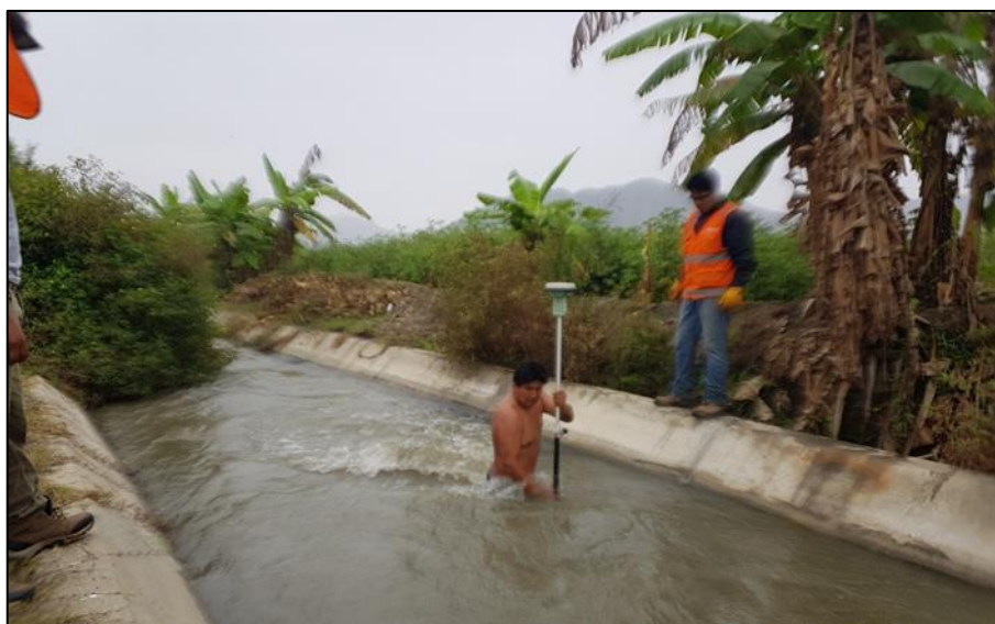
Figura 19: Levantamiento topográfico con gps diferencial en la base del canal
