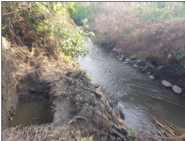
Figura 10: Tramo de canal sin revestir
