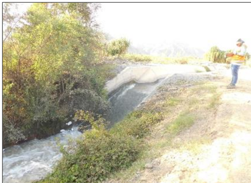
Figura 5: Caída inclinada ubicado en la progresiva Km. 6+224.63
