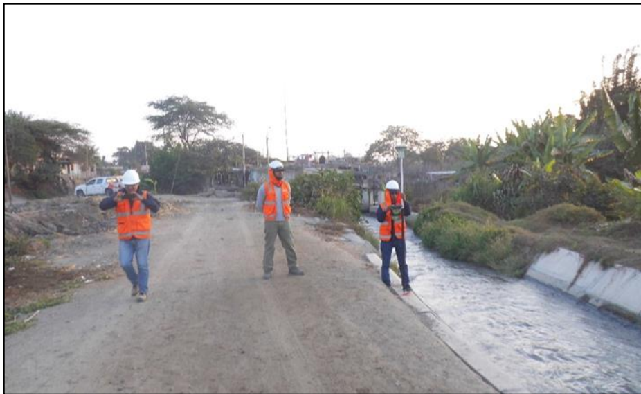
Figura 18: Levantamiento topográfico con gps diferencial en el borde del canal
