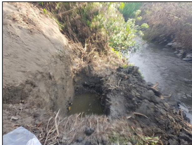
Figura 24: Calicata N° 1, profundidad 1.50 m. y ubicado en el Km. 7+125
