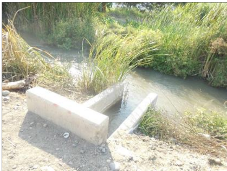
Figura 7: Desagüe ubicado en la progresiva Km. 5+589.95
