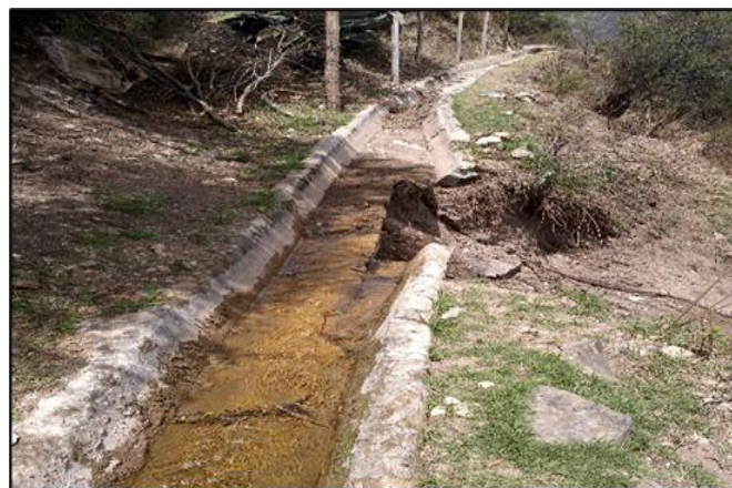
Figura 10: Condición actual del canal de concreto
