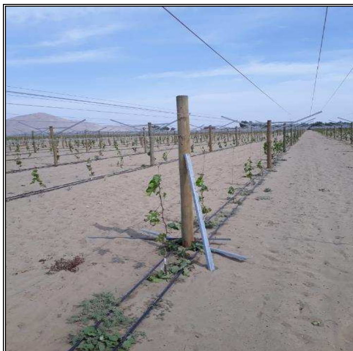
Figura 12: Colocado de crucetas
