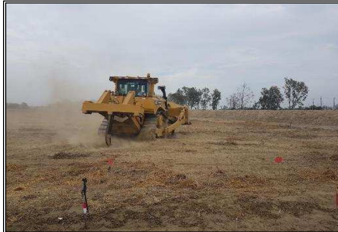
Figura 3: Subsulado con tractor oruga D-7.
