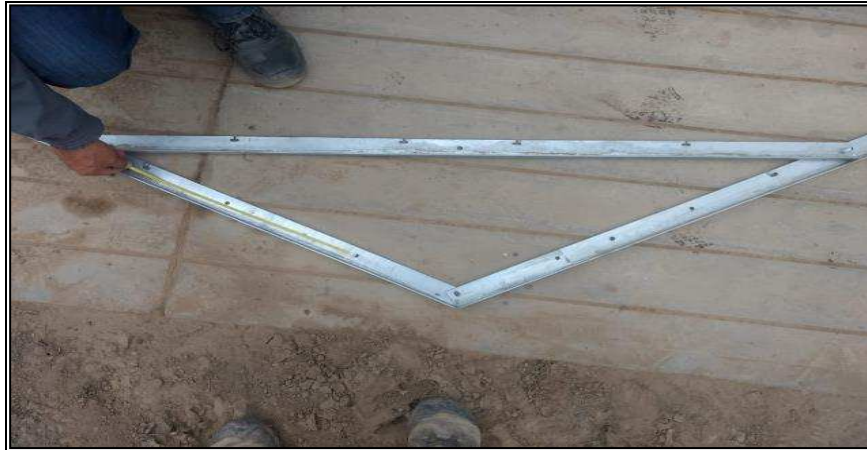
Figura 11: Armado de crucetas de fierro
