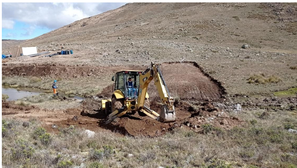
Figura 36: Excavación de la cimentación del dique de la cocha Aradacocha 1
