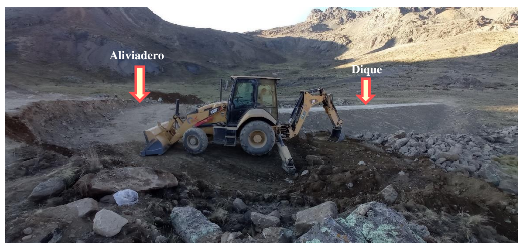
Figura 41: Excavación del aliviadero de la cocha Aradacocho 3
