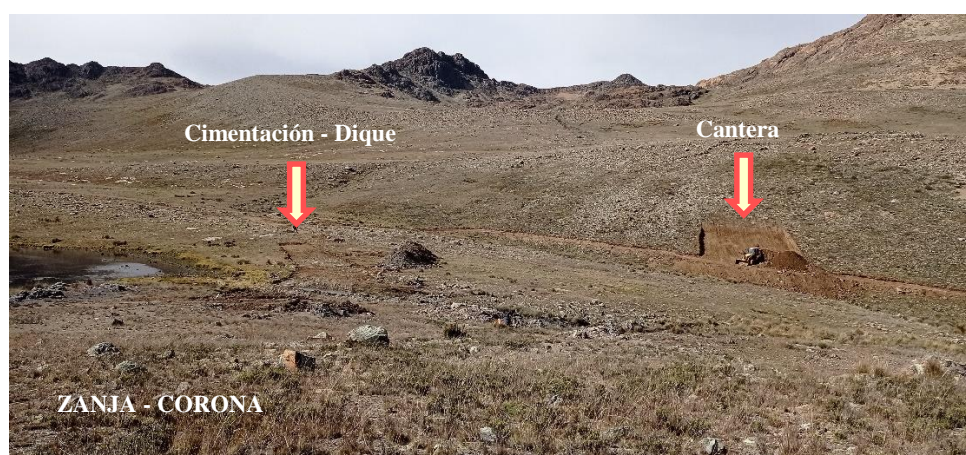
Figura 43: Extracción de material de préstamo de la cantera, para la cocha Aradacocha 2
