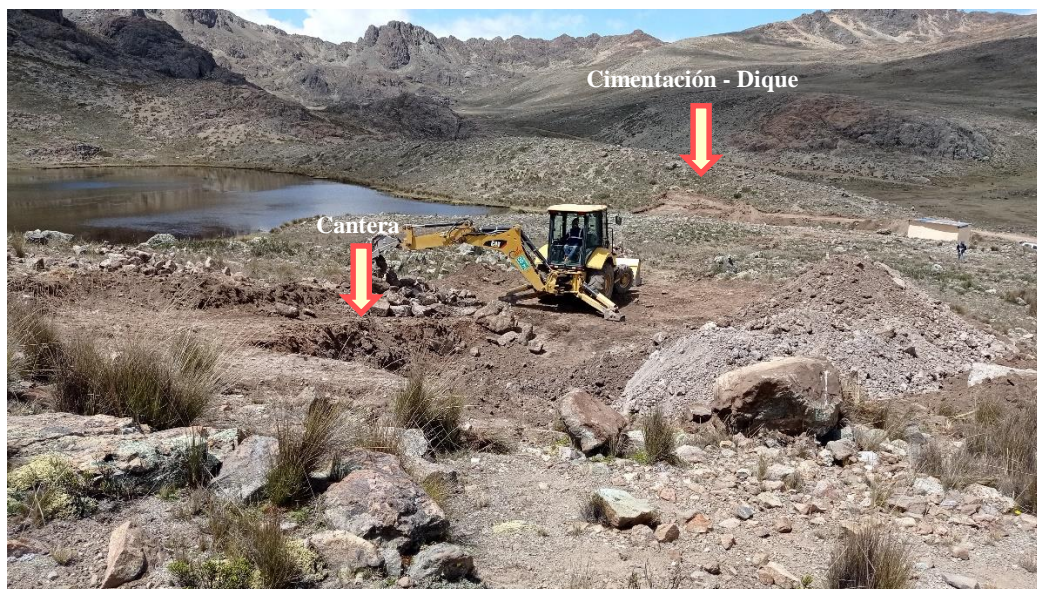
Figura 42: Extracción de material de préstamo de la cantera, para la cocha Aradacocha 1
