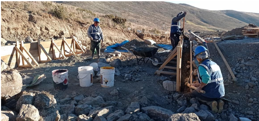
Figura 23: Enrocado y braseado de las paredes del aliviadero
