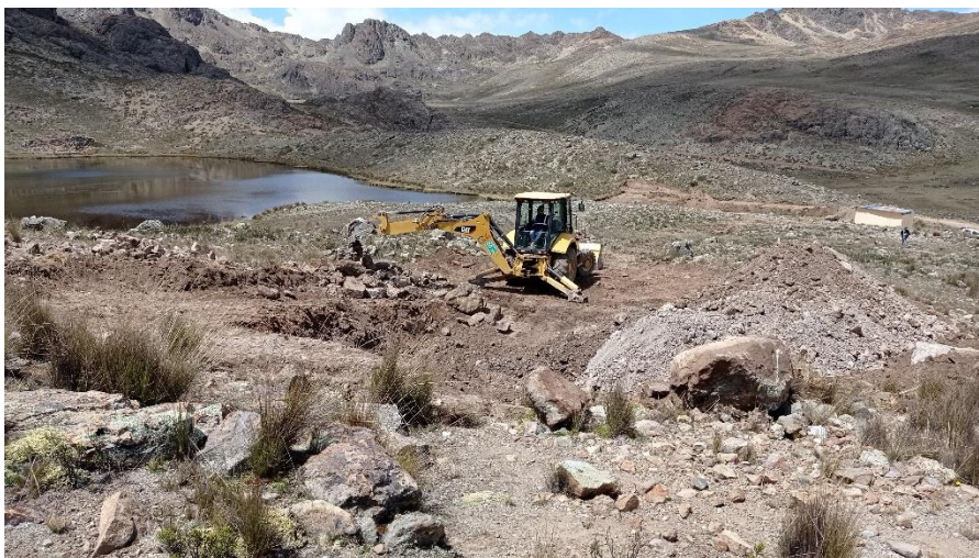
Figura 7: Excavación y habilitación de material en la cantera
