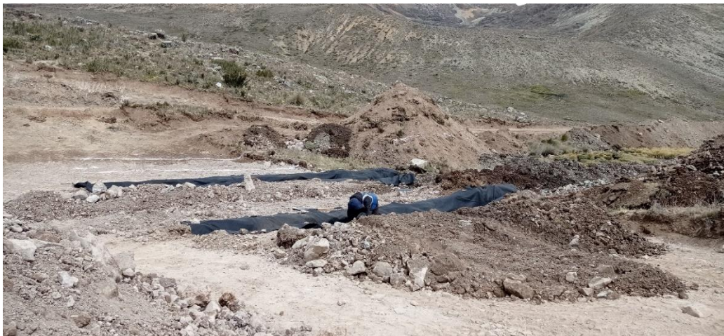
Figura 9: Instalación de los drenes en campo
