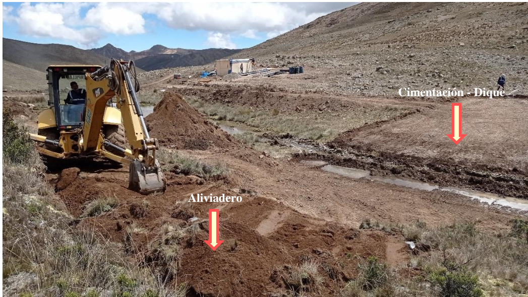
Figura 39: Excavación del aliviadero de la cocha Aradacocha 1
