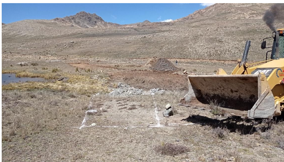
Figura 37: Excavación de la cimentación del dique de la cocha Aradacocha 2
