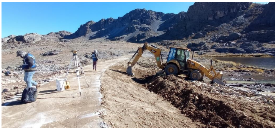
Figura 12: Perfilado de la cara húmeda del talud del dique
