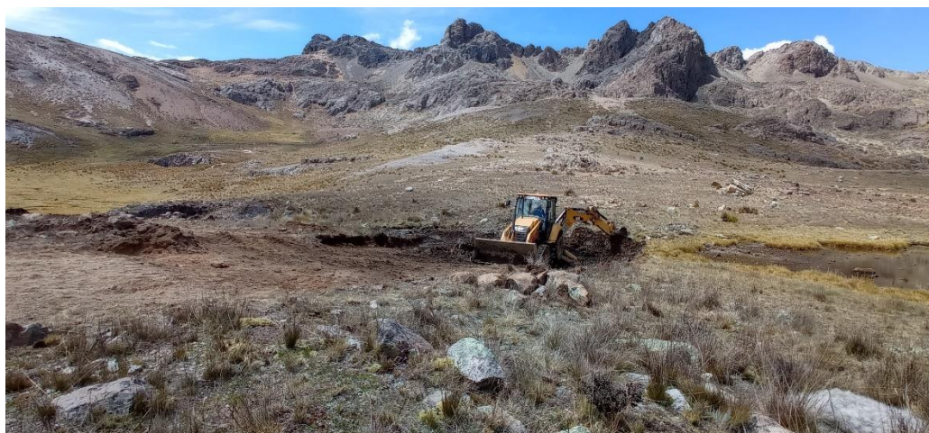
Figura 38: Excavación de la cimentación del dique de la cocha Aradacocha 3
