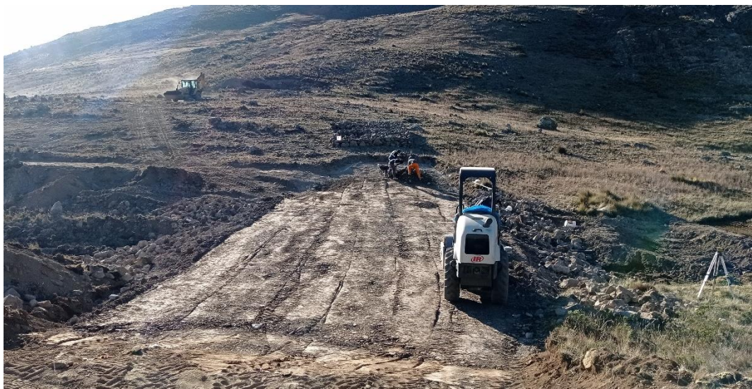
Figura 49: Compactación de capas con Rodillo Ingersoll Rand SD45D
