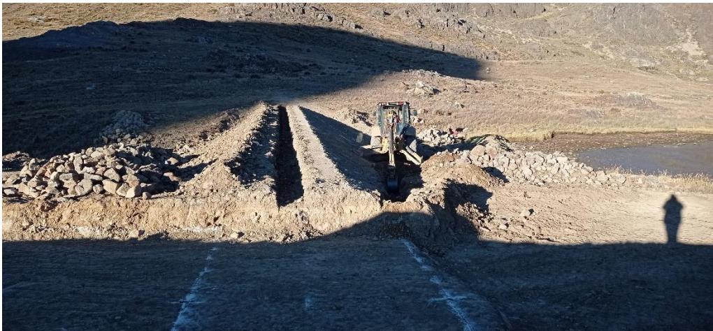
Figura 14: Excavación de las zanjas de anclaje
