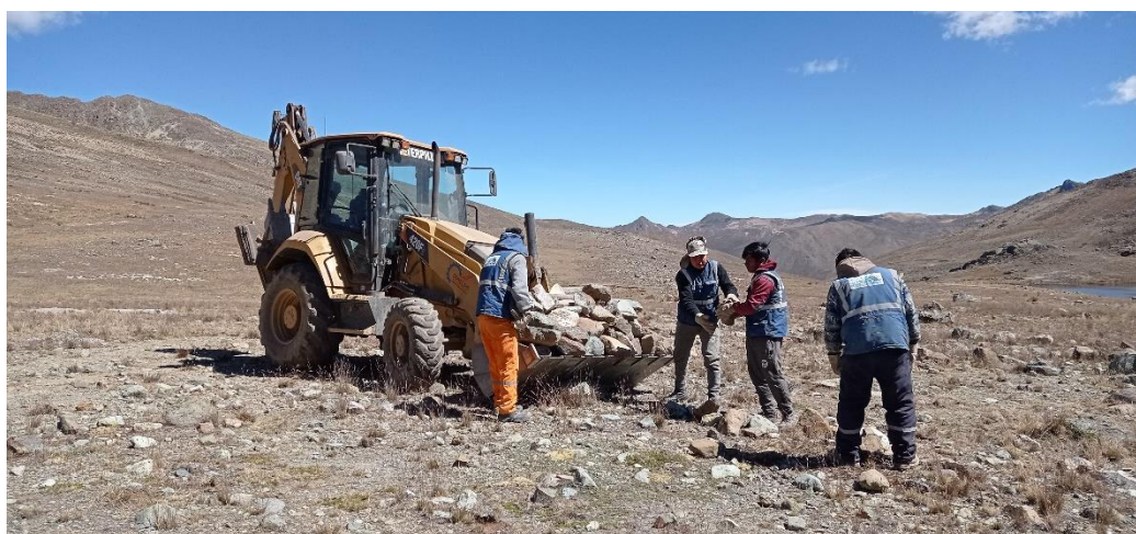
Figura 46: Traslado de piedra mediana con maquinaria
