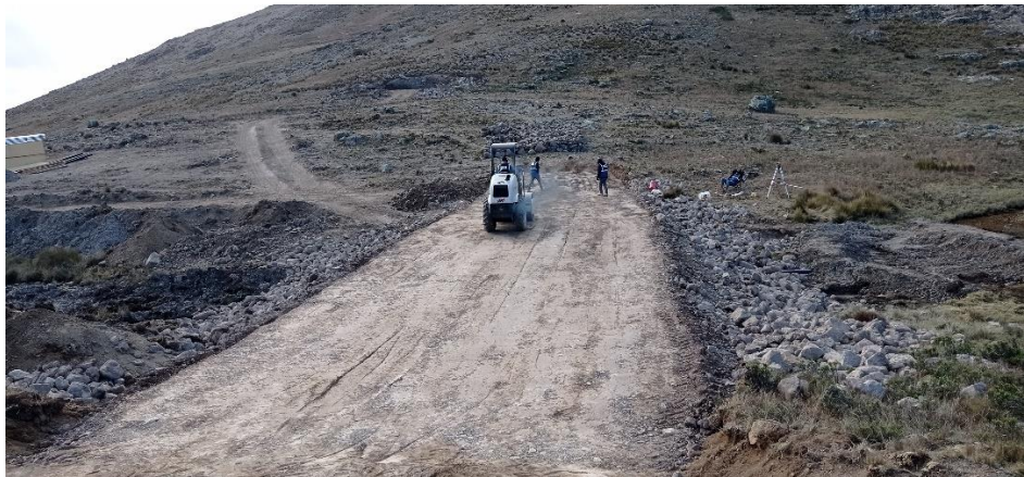
Figura 11: Compactación por capas en el cuerpo del dique
