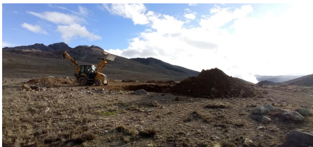
Figura 44: Extracción de material de préstamo de la cantera, para la cocha Aradacocha 3
