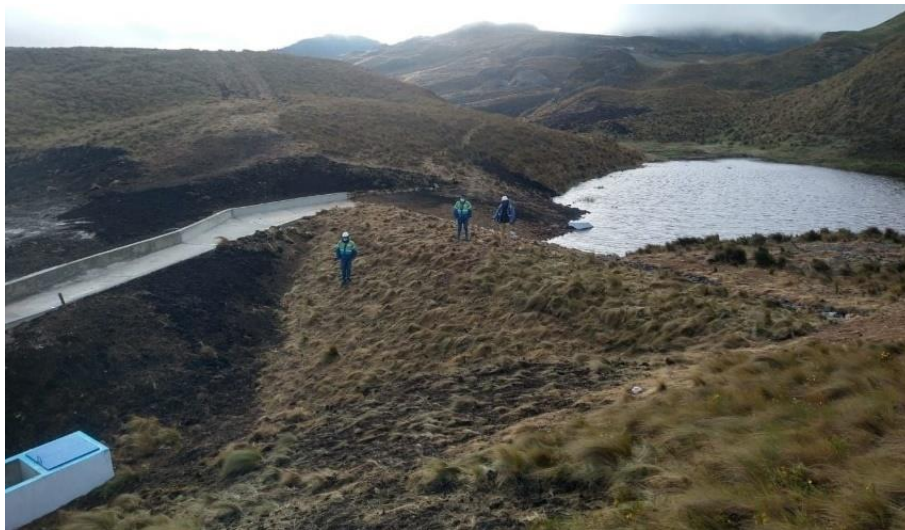
Figura 5: Cocha culminada y pleno funcionamiento
