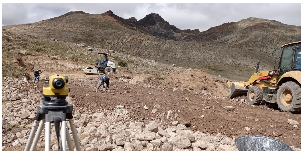
Figura 48: Esparcimiento de material suelto, en cuerpo del dique
