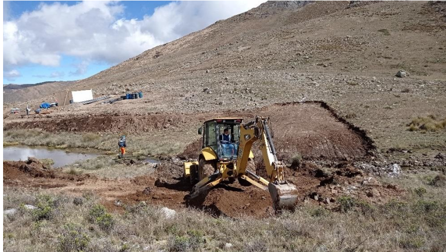
Figura 6: Excavación de la cimentación del dique
