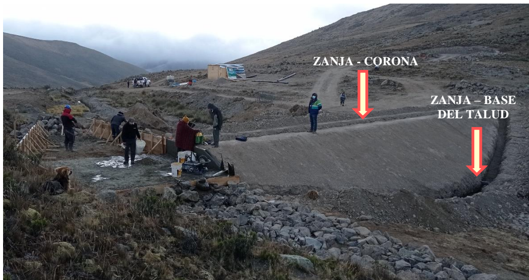
Figura 51: Zanjas de Anclaje, Aradacocho 1
