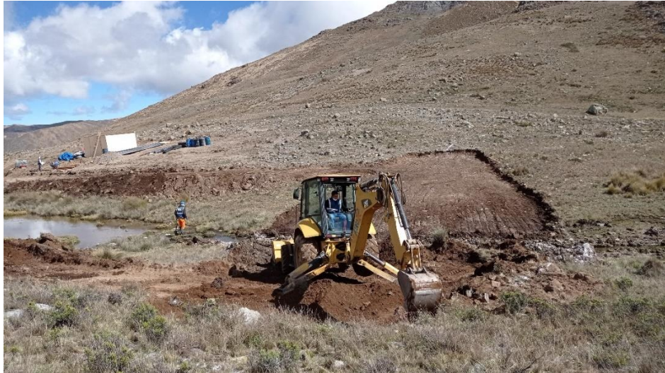
Figura 22: Excavación de a nivel de rasante del aliviadero
