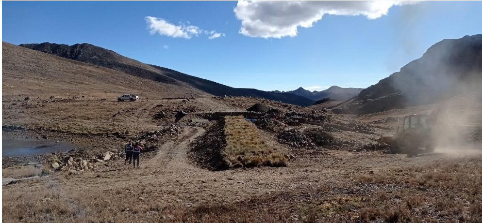
Figura 20: Instalación y siembra de la champa sobre la corona del dique
