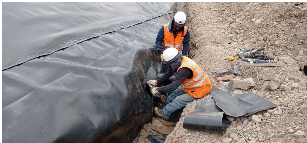
Figura 17: Soldadura mediante extrusión de la geomembrana HDPE
