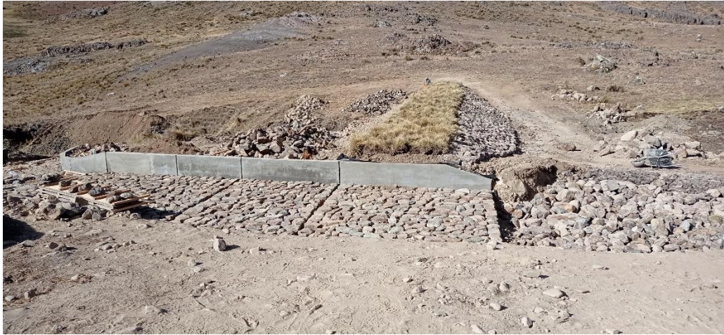
Figura 24: Asentado de piedras sobre el piso del aliviadero
