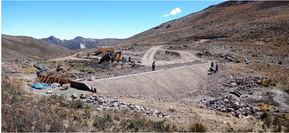
Figura 13: Rastrillado del talud del dique
