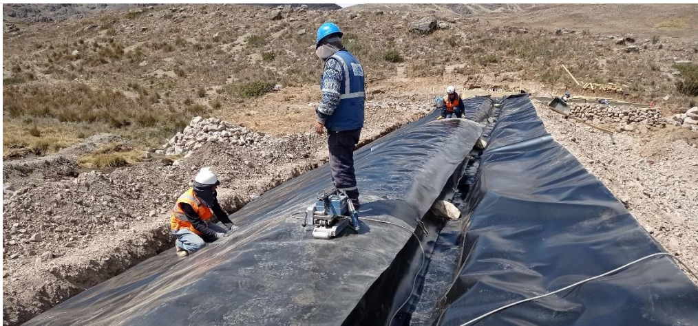
Figura 16: Soldadura mediante termofusión de la geomembrana HDPE
