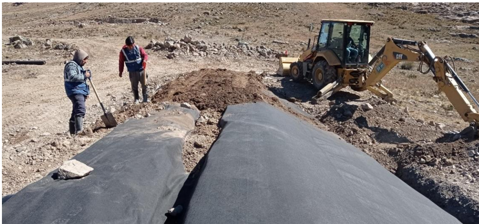
Figura 19: Relleno de las zanjas de anclaje
