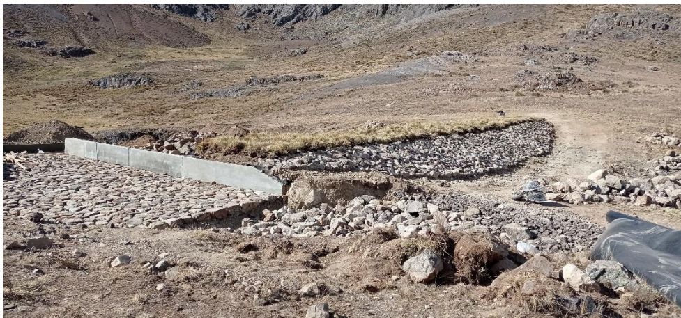
Figura 21: Enrocado de la cara húmeda del dique
