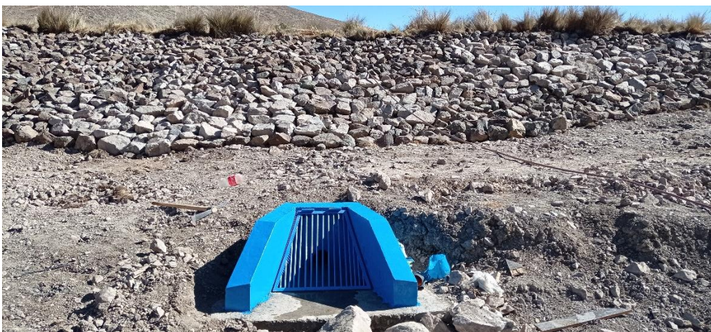
Figura 25: Estructura de ingreso culminado
