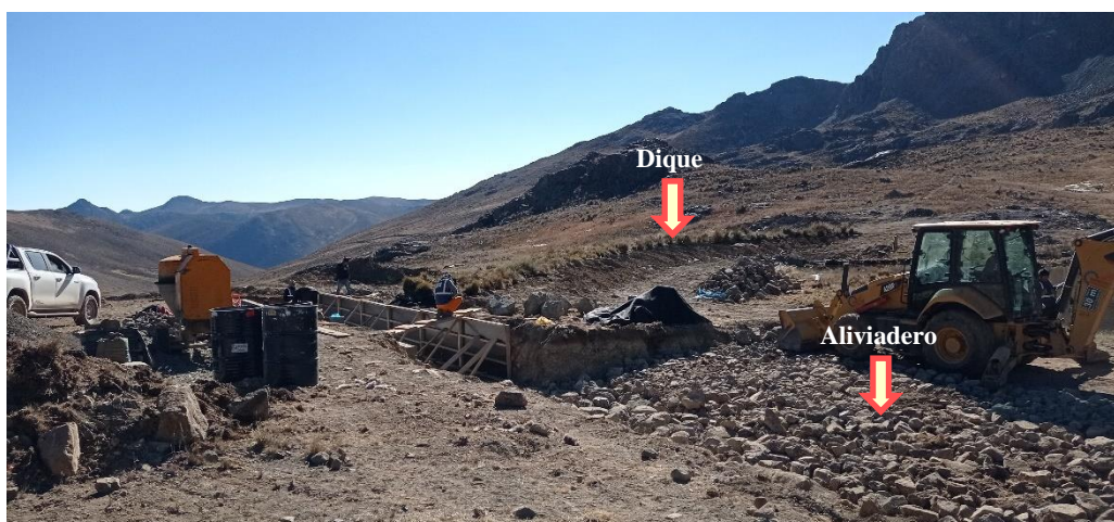
Figura 40: Excavación del aliviadero de la cocha Aradacocha 2
