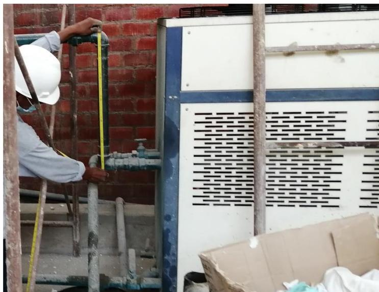
**Anexo 23:** Tuberías de conexión entre la campana y el condensador
